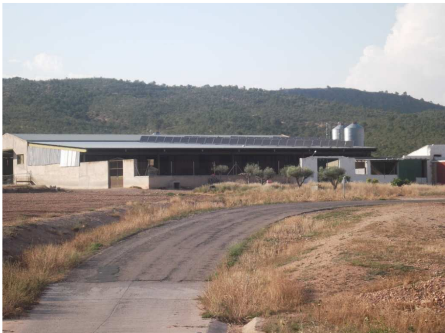
Figura 118. Módulos solares fotovoltaicos en la Casa del Cura.
