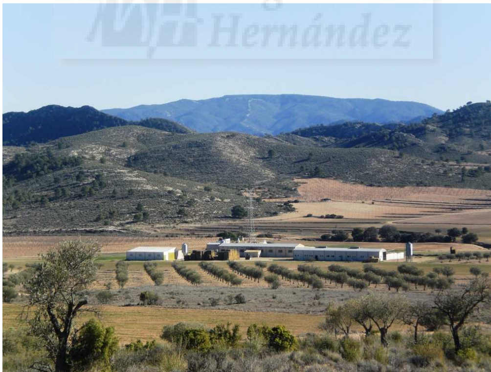
Figura 111. Instalaciones de la explotación de la Casa del Cura.
