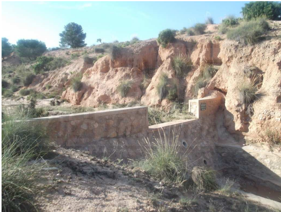
Figura 119. Represa construida en el año 1999 sobre la Rambla Madre.
