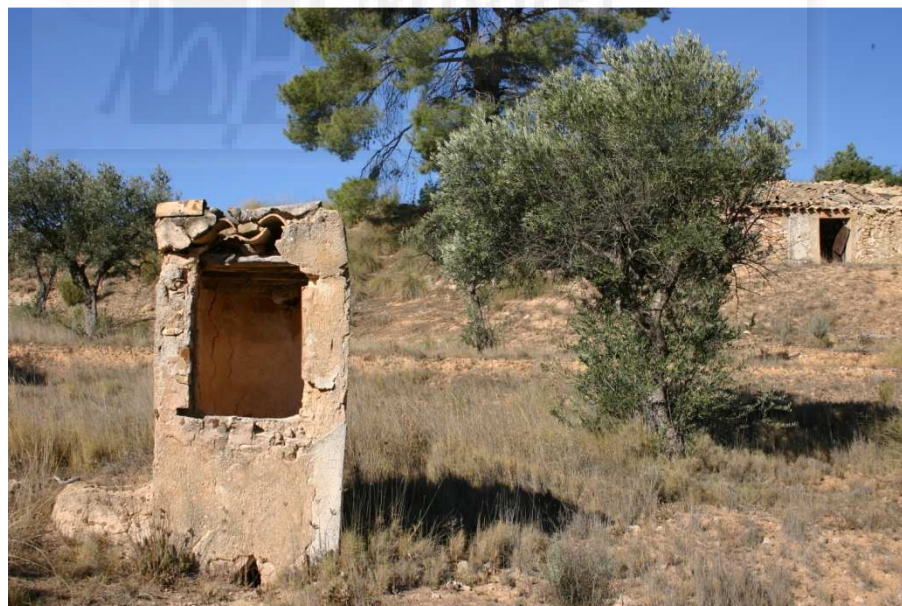
Figura 6. Antiguo aljibe junto a una edificación rural. Foto: A. García.
