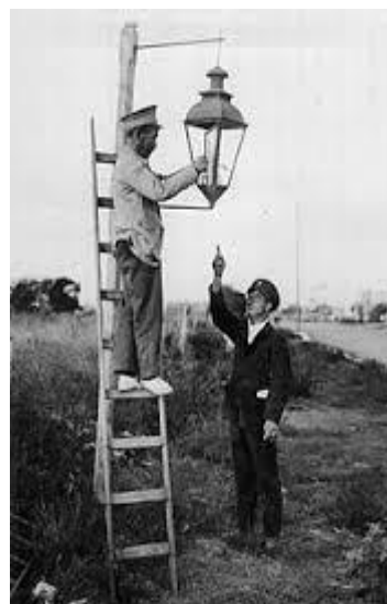
Figura 53. Encendido de Luminarias de gas para alumbrado público. Fuente Fundación Gas Natural.
