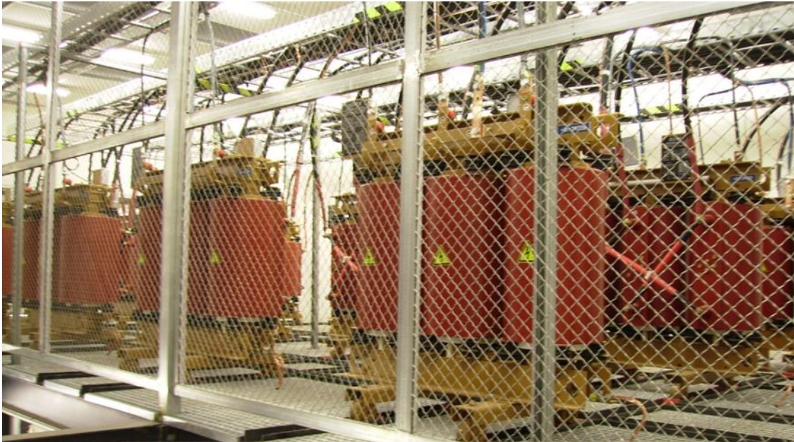
Fotografía 44. Instalación fotovoltaica de 20 MW, dividida en pequeñas instalaciones de 100 kVA. Trafos secos. Fuente propia.
