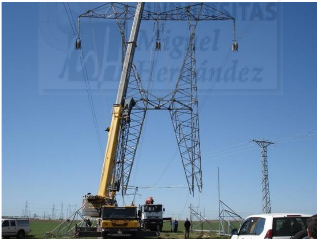
Fotografía 27. Repotenciación de una línea de transporte. Fuente propia.
