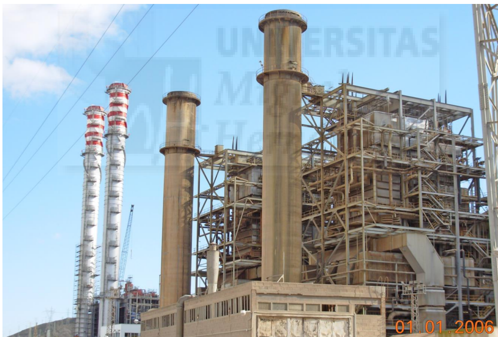
Fotografía 7. Antigua central térmica de Cartagena. Fuera de servicio. A la izquierda una de las tres centrales térmicas situadas en el valle de Escombreras con gas natural. Fuente propia.
