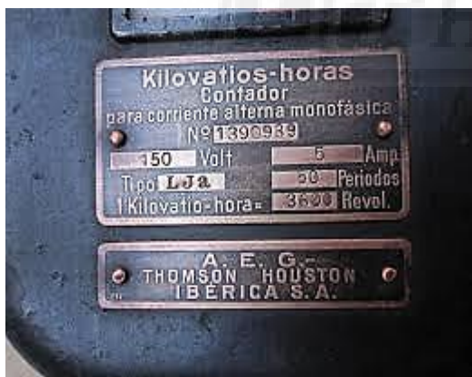
Figura 54. Placa de características del contador de energía eléctrica de la sociedad A.E.G. Fuente AEG
