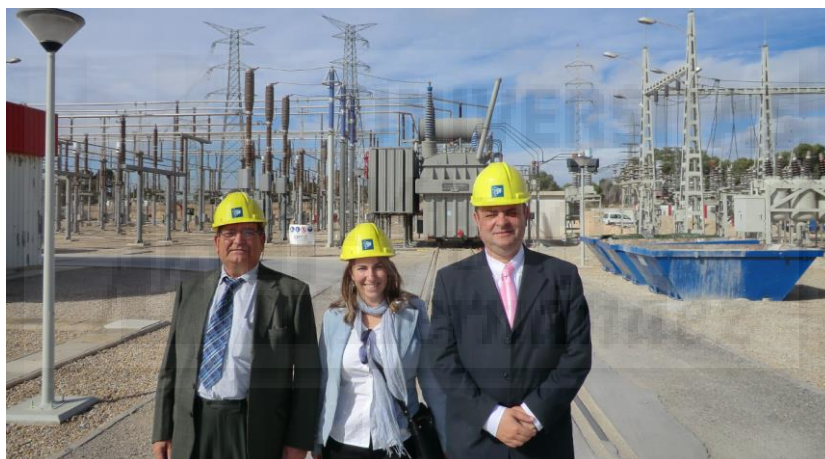
Fotografía 4. Acta de puesta en marcha de posición de la Subestación eléctrica Campoamor de REE 220 kV e Iberdrola 132-20 kV. Fuente propia.
