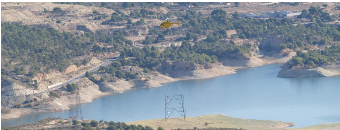
Fotografía 46. Izado con helicóptero de apoyo de línea de alta tensión, por difícil acceso. Alicante. Fuente Iberdrola Ingeniería.
