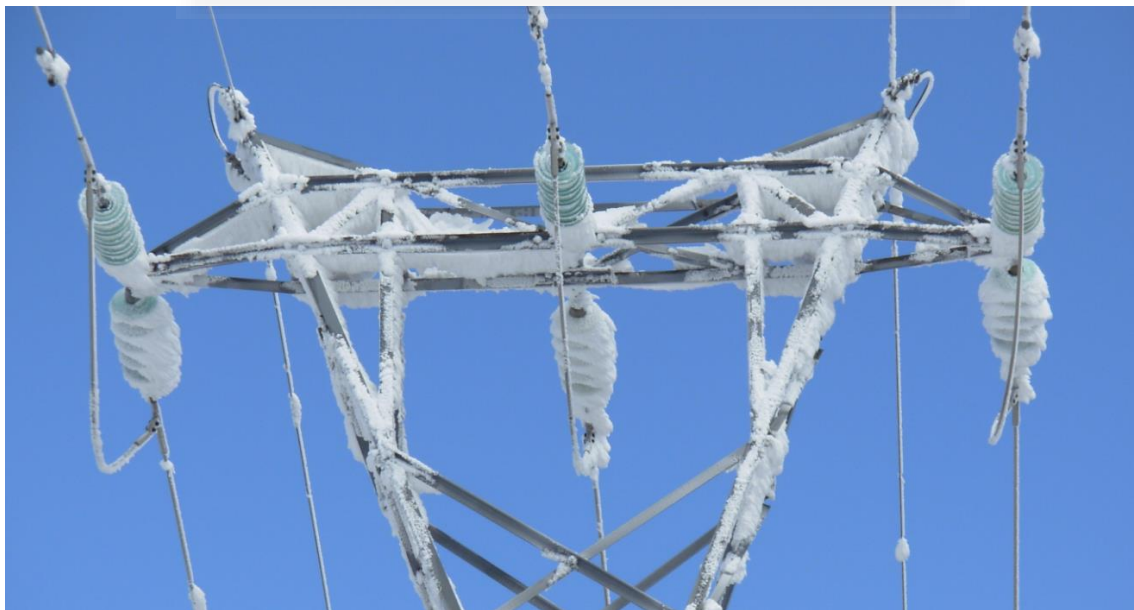
Fotografía 36. Influencia del hielo sobre el peso del conductor. Fuente propia.
