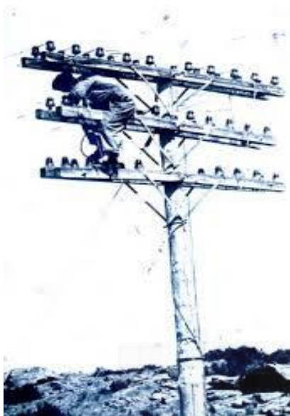
Figura 52. Tendido de línea telegráfica sobre poste de madera. Fuente: historia telefonía.
