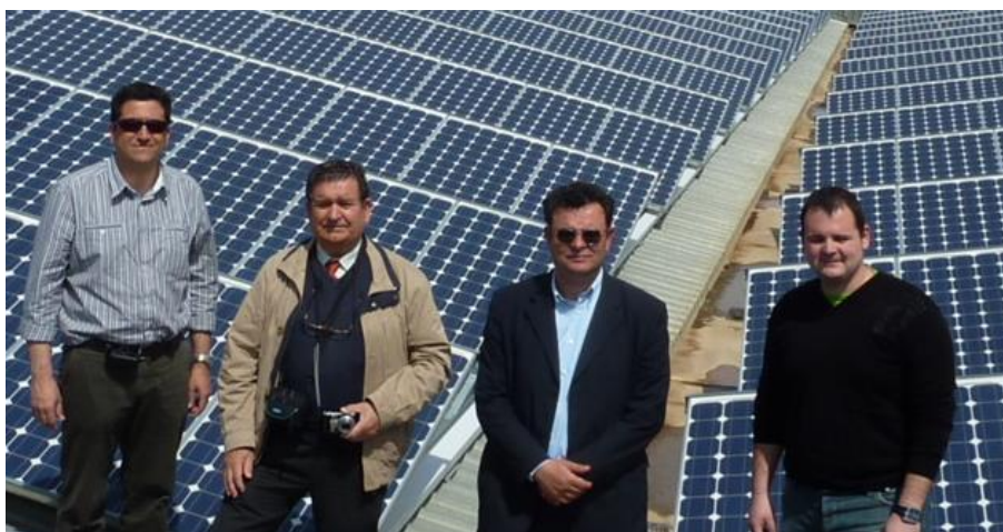
Fotografía 15. Primeras instalaciones fotovoltaicas en techo de la provincia de Alicante. Fuente propia.
