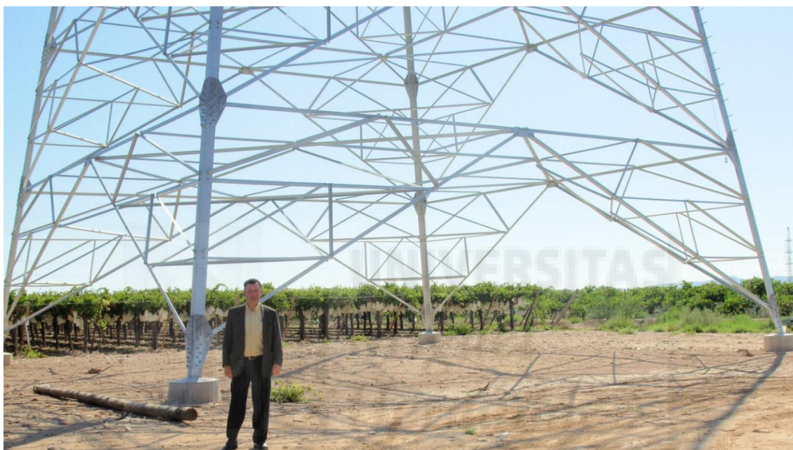
Fotografía 40. Influencia de la expropiación en el trazado de una línea de alta tensión. Fuente propia.
