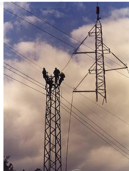
Figura 101. Repotenciación línea Tambre. Unión FENOSA Montaje.
