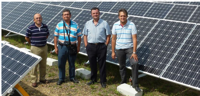
Fotografía 48. Instalación fotovoltaica de suelo en Alicante. Fuente propia.
