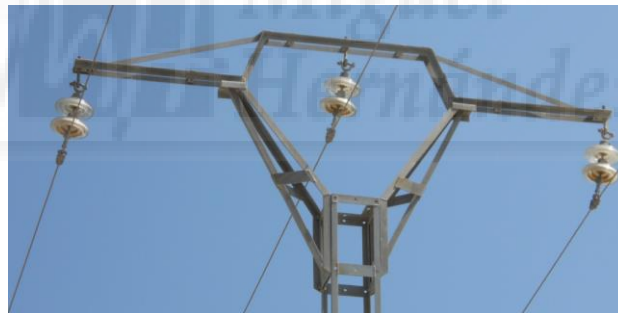
Fotografía 38. Cruceta bóveda de alineación empleada para los cálculos para la línea de LA simple circuito.
