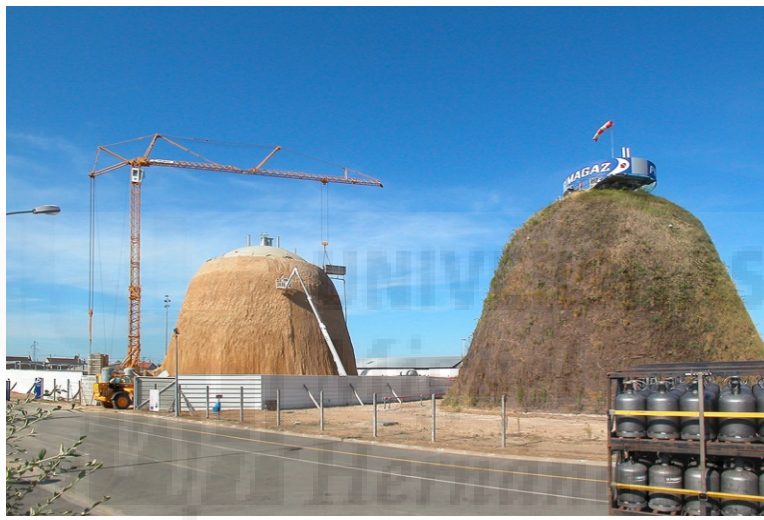
Fotografía 1: Esferas recubiertas para evitar BLEVE. Texsol.
