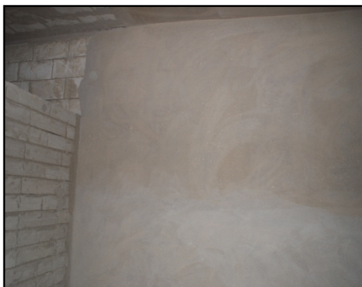
Fotografía 30: Enlucido de pared a base de mortero de sulfato cálcico. Departamento de Ingeniería.
