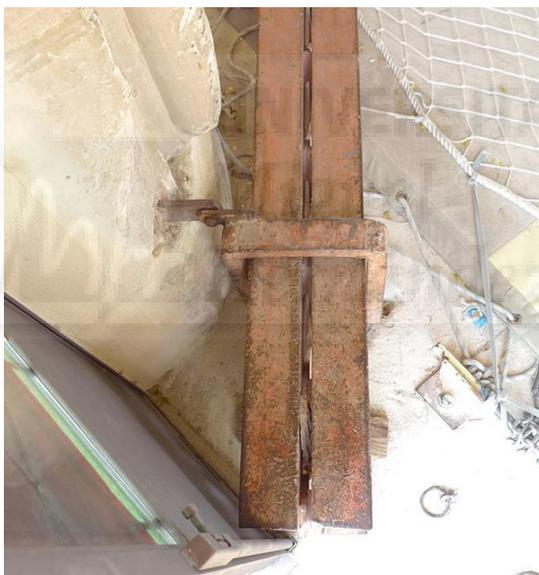
**Figura III-50:** El estribo de sujeción de la viga situado en la puerta del noreste colocado en su posición.
