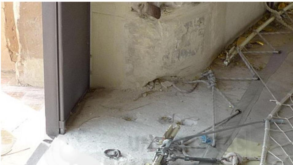
**Figura III-18:** Jamba junto al umbral de la ventana del noreste. En ella se puede ver una escuadra de sujeción del aro anclada al sillar, un trozo de aro, una anilla anclada al sillar y en la parte de arriba, sujeto al sillar de la jamba, el cáncamo para la sujeción del correspondiente estribo que impide el vuelco la viga maestra.
