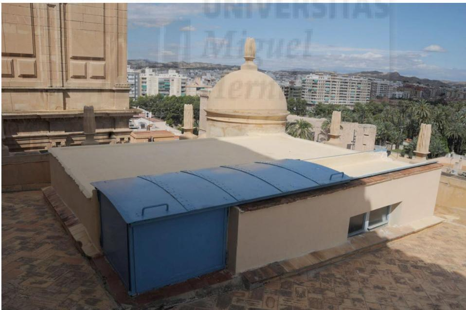
**Figura III-9:** Cubierta de la nave del crucero, zona norte, donde se ve en primer plano la caseta de vestuario, su cubierta, las puertas de acceso y la cubierta corrediza, estas últimas pintadas de azul, una de las ventanas de ventilación y tras la caseta la torrecilla del vértice.
