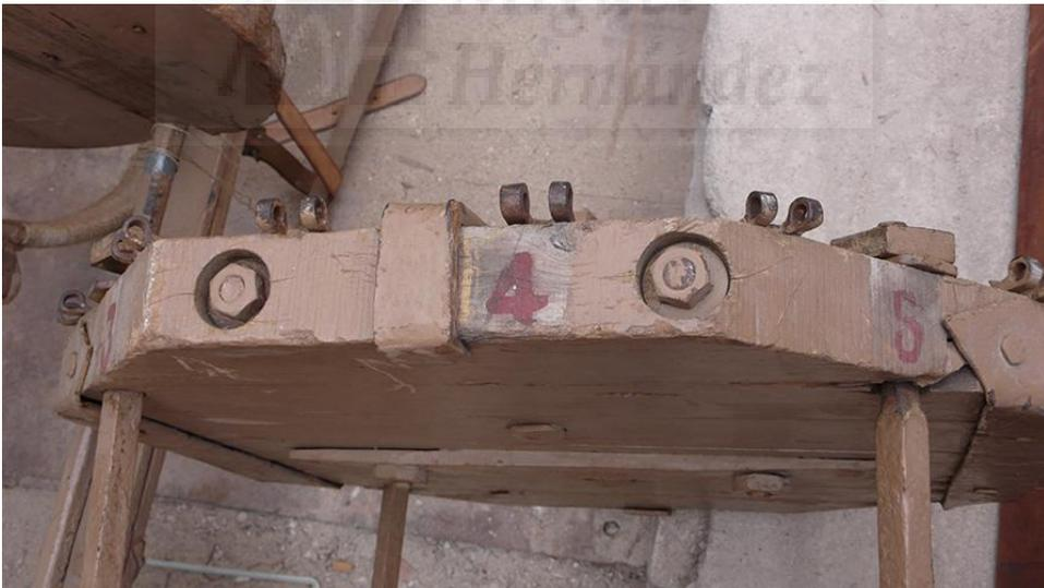
**Figura III-161:** Vista de la cara lateral del prisma que forma la cubierta. Pueden verse las tuercas de los pernos que sujetan las maderas que las forman, la pletina de sujeción de los cáncamos con las anillas y por la parte superior las bisagras que articulan las alas.
