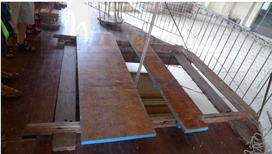
**Figura III-149:** Fotografía del orificio de la plataforma destinado al paso de los aparatos cubierto con las tablas de trabajo y la maroma entre ellas.
