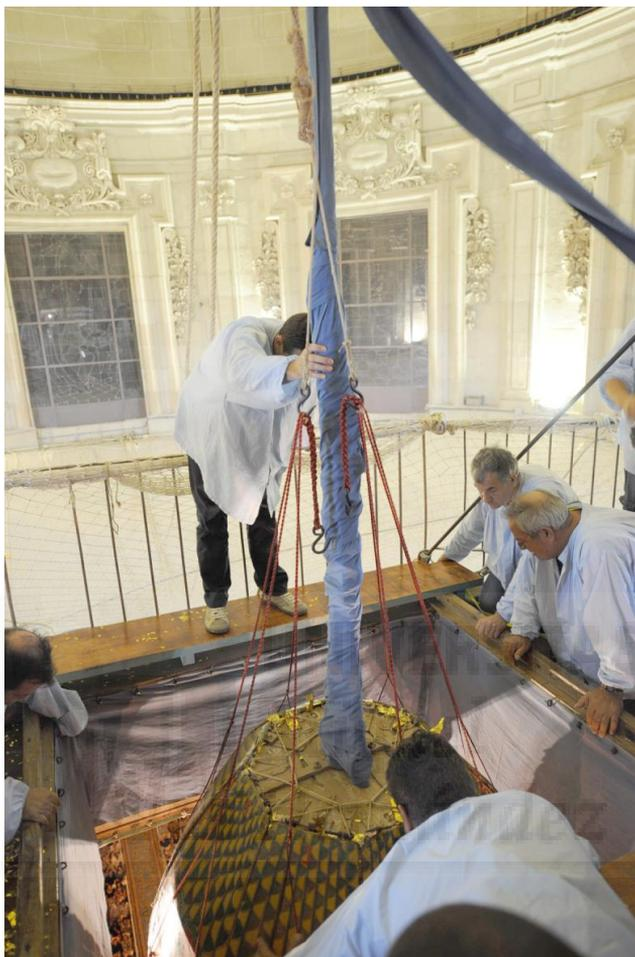
**Figura III-94:** Cuerda destinada a albergar los ganchos de las alas que la mantienen abierta, ganchos que los vemos colgando y sujetos a una cuerda granate, que a su vez, están sujetas a los dos ganchos unidos a las cuerdas tensas de cáñamo, de color claro, que son las que procedentes de la polea sujeta al vértice ejercen la fuerza los tramoyistas que están de pie.
