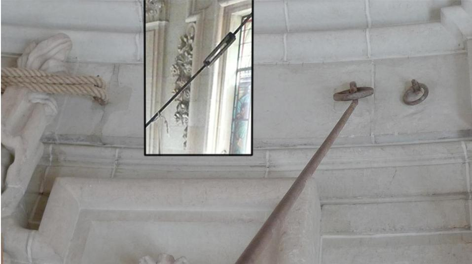
**Figura III-60:** Enganche del tirante con la anilla situada arriba del dintel de la ventana de levante y detalle del tensor del tirante.
