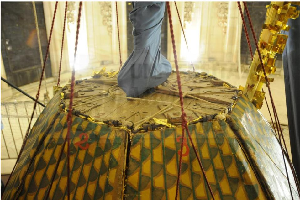
**Figura III-165:** Sistema de sujeción entre los quicios sujetos a la cubierta y los sujetos a las alas.
