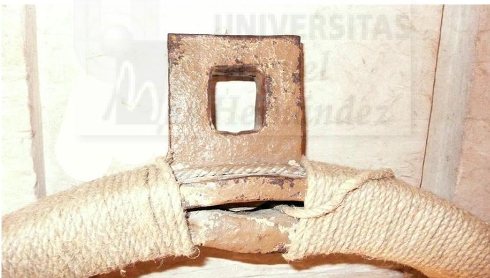
**Figura III-198:** Anillo de enganche sujeto al arco exterior.
