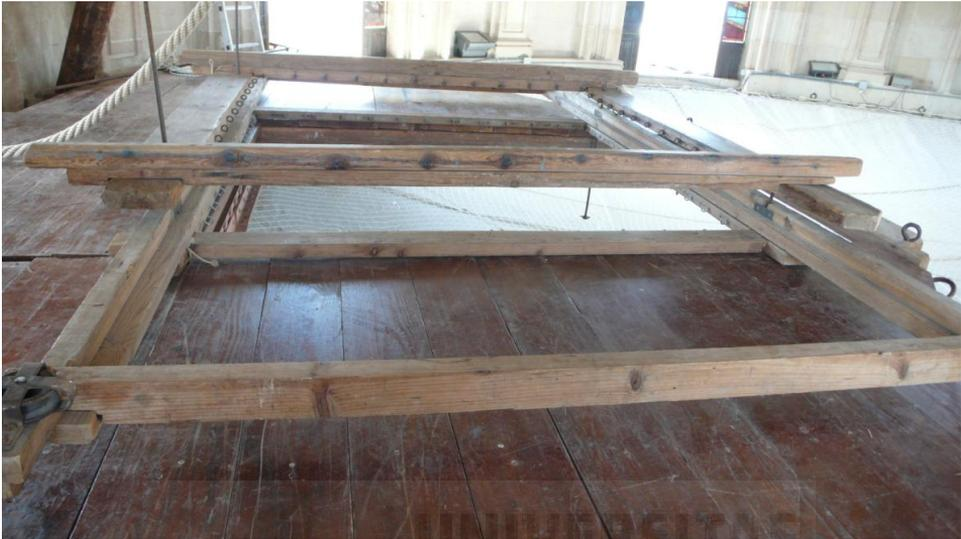
**Figura III-141:** Fotografía del armazón donde se pueden ver los tres bastidores que lo componen. Debajo hacia arriba: pegado al tablado el de sujeción del cielo, le sigue el de las guías de la puerta y por último y por arriba de estas el de las tablas.
