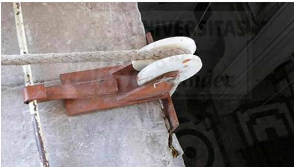
**Figura III-32:** Una de las poleas destinadas al izado del cielo, sujeta al anillo de acero para atar el lienzo del cielo y una de las maromas pasando por su garganta.
