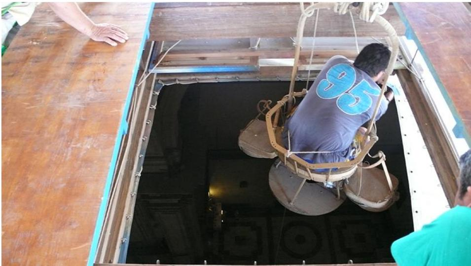
**Figura III-153:** Fotografía de tramoyista montado sobre el aparato de la coronación cosiendo el cielo al bastidor correspondiente.
