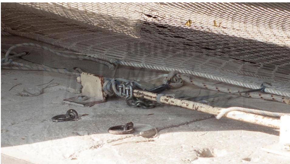
**Figura III-37:** Sujeción del lienzo a la cornisa. Un radio atado a un tensor, una cadena y cuerda de poliamida cosiendo el lienzo. En la foto se aprecia la escuadra de sujeción del aro de acero a la cornisa y el propio aro.
