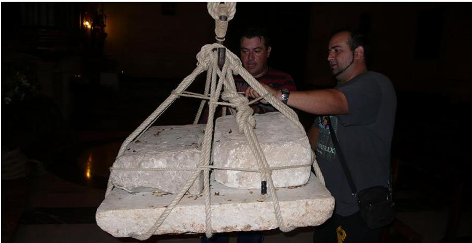
**Figura III-121:** Fotografía del atado de las losas y de estas al extremo de la maroma.
