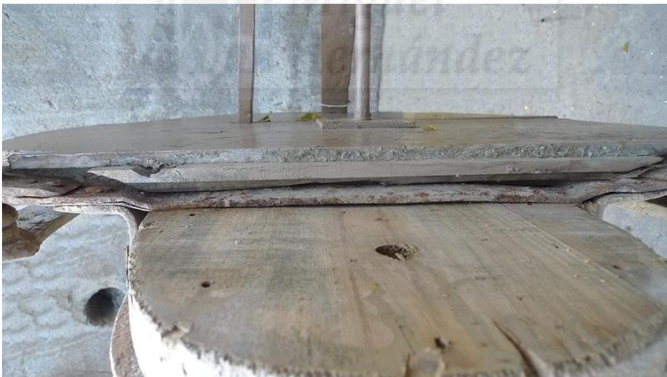
**Figura III-203:** Puentes del refuerzo para la sujeción de la plataforma.
