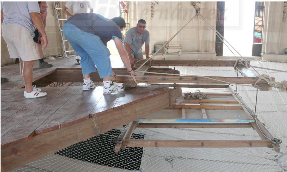
**Figura III-142:** Fotografía del armazón instantes antes de ocupar su posición de trabajo. Se puede ver en ella la parte que queda por encima de la plataforma y la que lo hace por la parte baja. Foto del autor.
