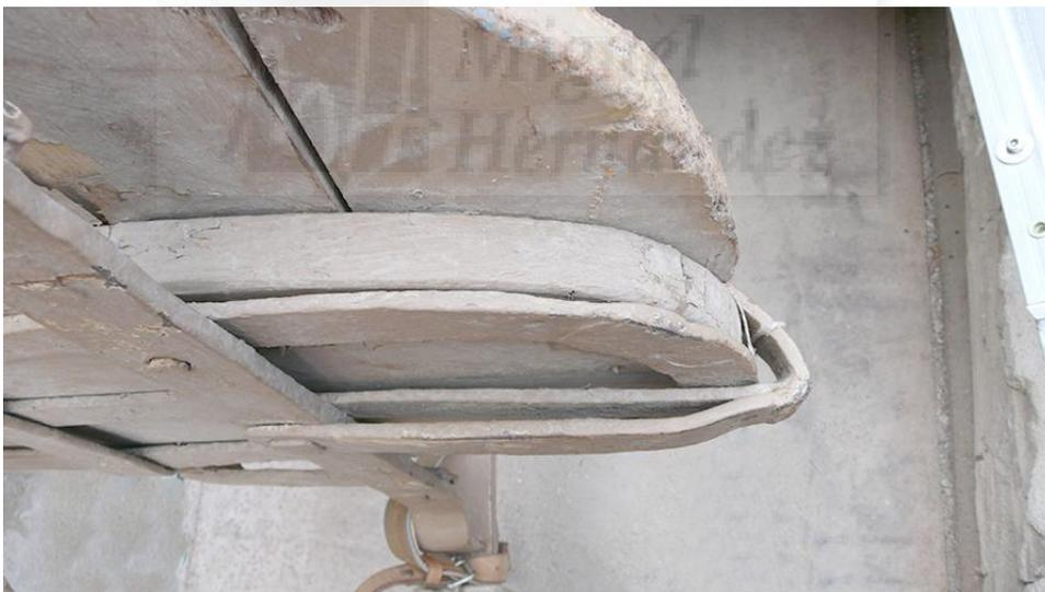
**Figura III-206:** Parte cota de la L correspondiente al pilar del arnés, su sujeción al travesaño superior.
