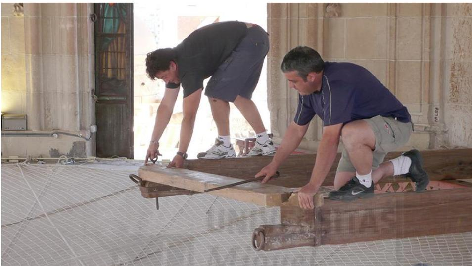
**Figura III-59:** Extremo de las vigas de voladizo con la de cierre colocada en su posición. Los tramoyistas, están cerrando los nudos formados con las tres vigas con las clavijas.
