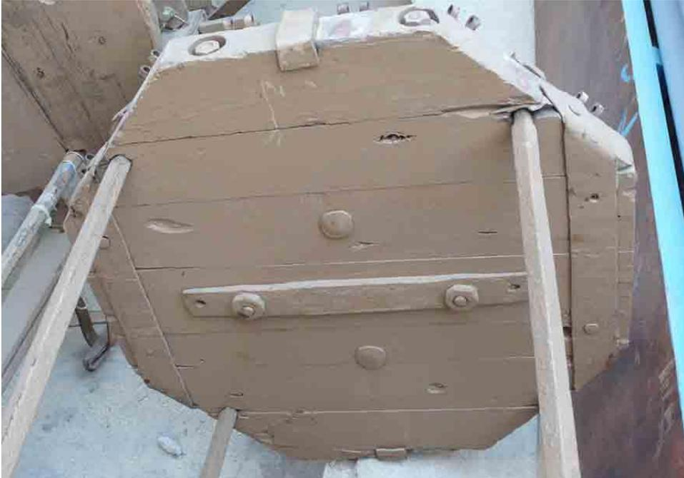
**Figura III-160:** Vista de la cara interior del prisma que forma la cubierta. Pueden verse las tuercas de los pernos que sujetan las maderas que las forman y la pletina de sujeción de los cáncamos con las anillas.
