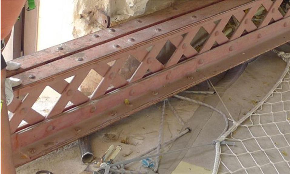
**Figura III-48:** Empalme de la viga.
