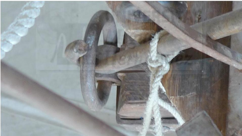
**Figura III-61:** Nudo formado por el extremo de la viga de voladizo, la de borde, la de cierre y sujetas con la clavija. Detalle del enganche del tirante a la anilla del extremo de la viga de voladizo.
