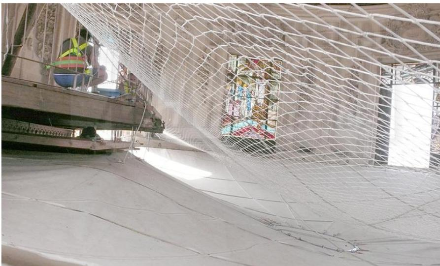
**Figura III-154:** Fotografía de la nueva forma que toma el lienzo una vez sujeto al bastidor de sujeción del cielo.
