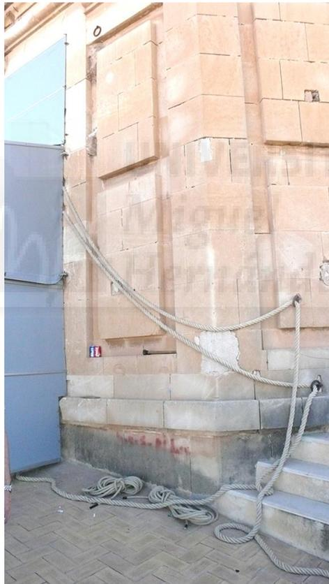
**Figura III-81:** Fotografía de los tirantes de la cabria discurriendo por la fachada de levante en busca de las anillas situadas junto a las escaleras de acceso a la terraza del crucero.
