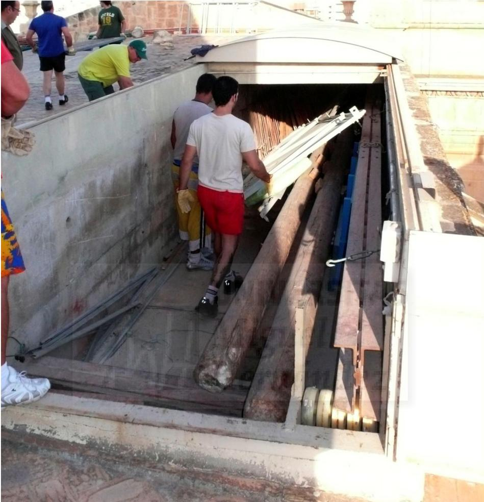
**Figura III-11:** Interior de la caseta de vigas, con las puertas abiertas y el cierre de corredera de la cubierta desplazado hacia el forjado, a la derecha se ven las ruedas sobre las que está apoyada la viga de celosía y junto a esta los pilares de la cabria. Encima de las paredes de cerramiento se ve las guías de rodadura.
