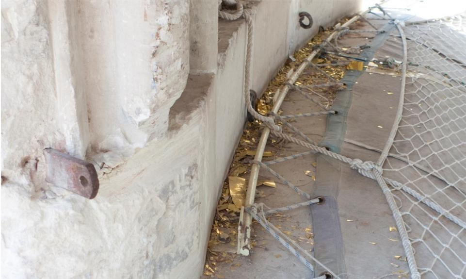
**Figura III-38:** En primer plano el cáncamo anclado a la jamba que se destina a la sujeción del estribo de contención de la viga maestra y a su derecha parte del anillo de acero de sujeción del lienzo, al que se encuentra cosido en zigzag el lienzo.
