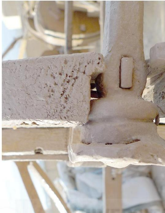
**Figura III-202:** basa de uno de los pilares sujeto al extremo exterior de la pletina en voladizo y sujeción al pilar de las pletinas en voladizo de los puentes.
