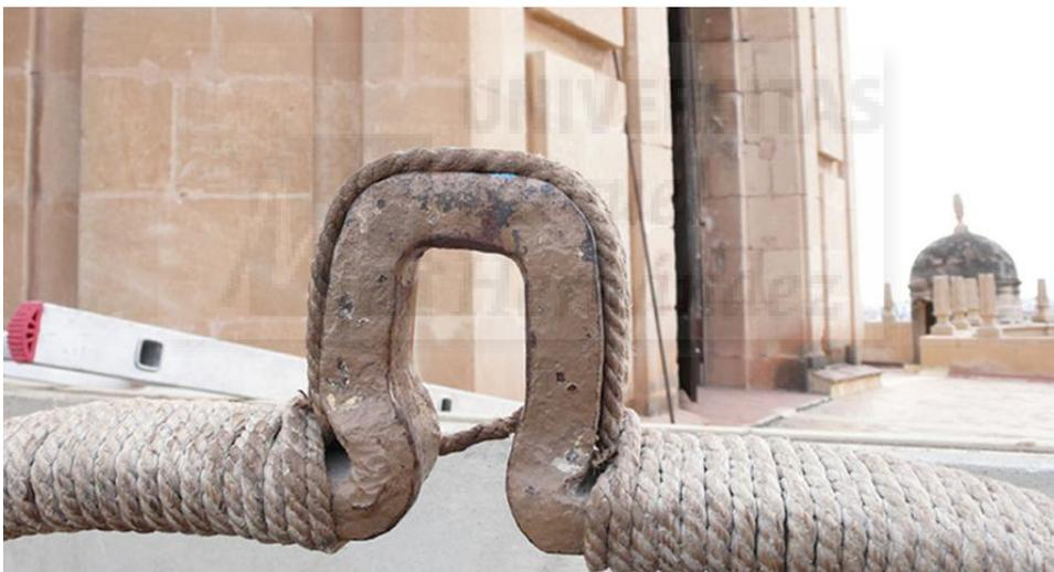
**Figura III-243:** Vértice del arco de suspensión.
