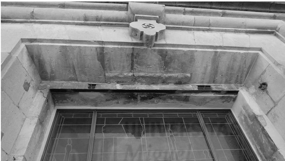
**Figura IV-9:** Estado actual del dintel y las jambas de la ventana orientada al este del tambor de la basílica de Santa María. En ellos se puede ver el hollín procedente del incendio y restos de yeso, sujeto a la sillería del dintel, pertenecientes a la antigua caseta.
