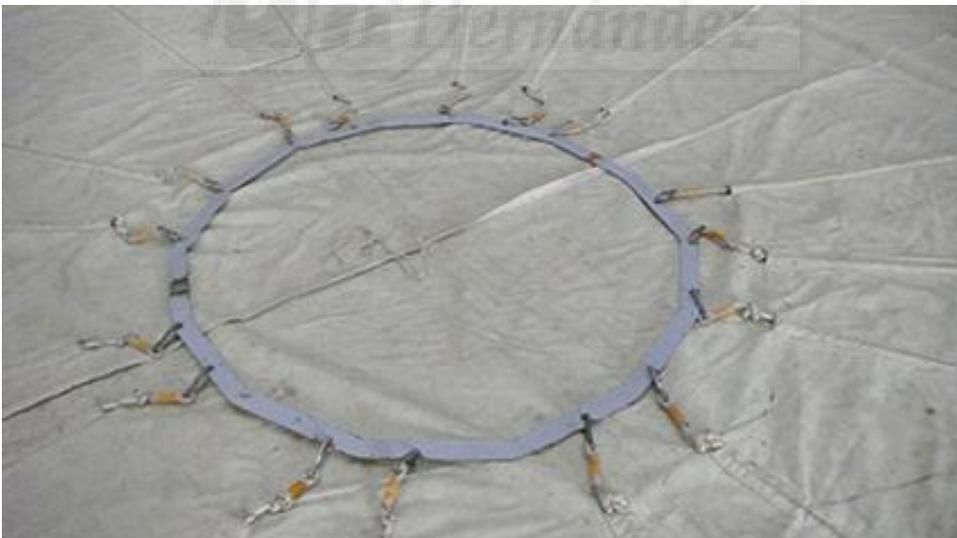
**Figura III-29:** Anillo central del lienzo, receptor de todos los radios que se extienden por el interior de la 16 vainas los respectivos radios hasta la periferia.
