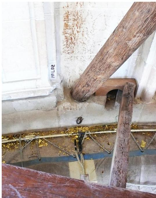
**Figura III-73:** Pilar apoyado en la oquedad labrada en el anillo toral.
