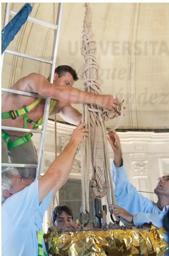
**Figura III-181:** Sistema de enganche y atado de la maroma con el gancho a la *mangrana*.
