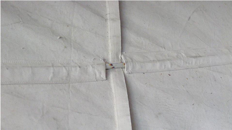
**Figura III-25:** Costura que forma la unión entre dos piezas que forman el lienzo, una de las vainas de los radios, el radio formado con cuerda de poliamida y el corte que efectúa la vaina en la intersección con las costuras.
