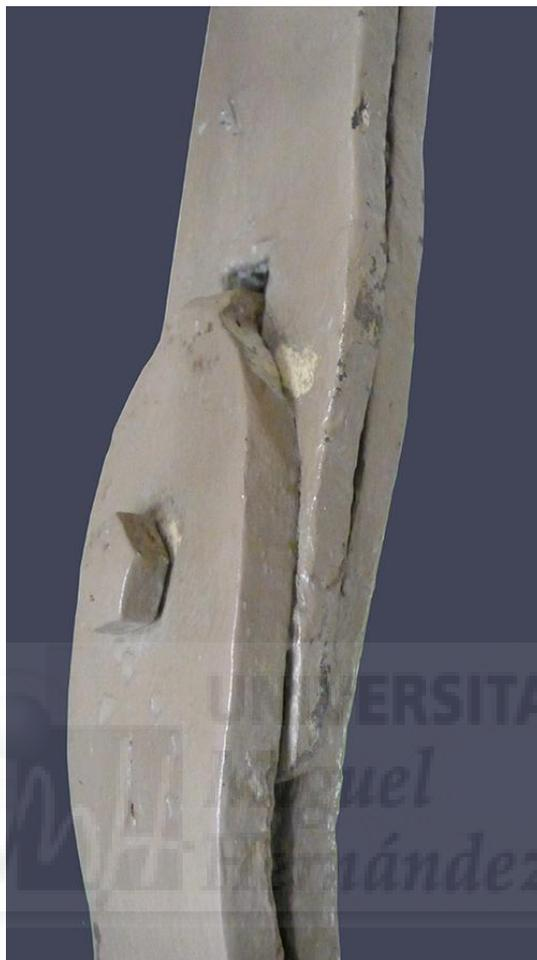
**Figura III-195:** Detalle de un punto de unión con coincidencia de tres pletinas donde se ve el detalle de la espiga que penetra en la muesca.
