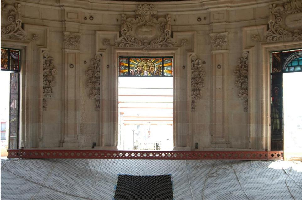
**Figura III-47:** La jácena en su posición de trabajo, como vemos queda simplemente apoyada por sus extremos sobre el anillo toral, rebasando la cornisa.
