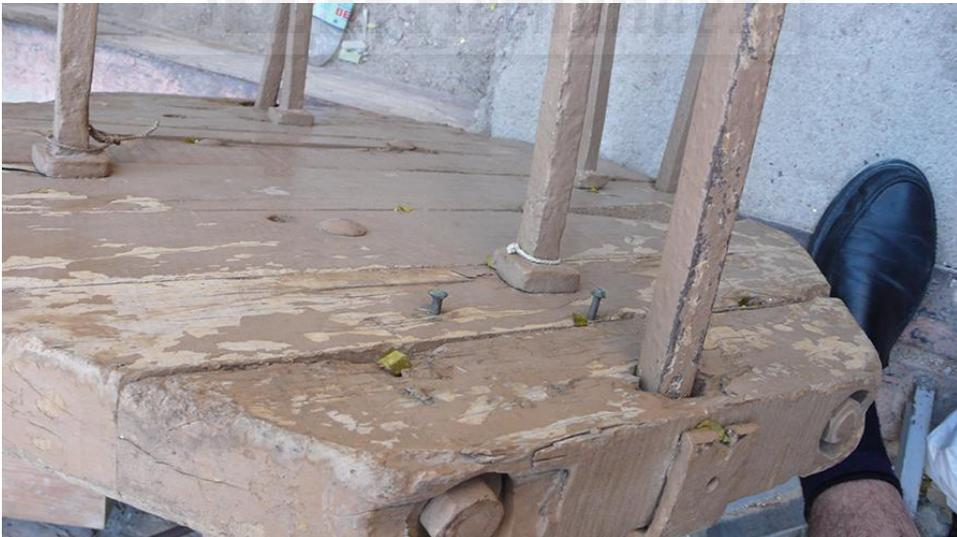
**Figura III-159:** Vista de la base por el interior, se pueden ver los pilares principales, al exterior, y los del arnés en el interior con unos toques en la base. En la cara del prisma los tornillos de sujeción de las tablas que forman la base.
