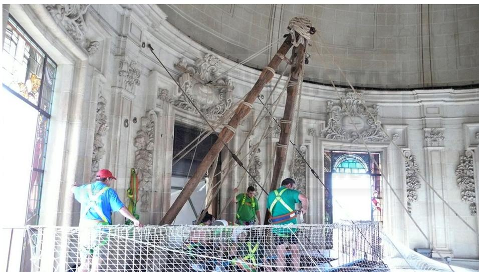
**Figura III-84:** Fotografía efectuada desde la ventana situada al norte, en ella podemos ver a la cabria compuesta de todos sus complementos, el tirante numero 8 se ve desde el vértice, hasta la parte inferior derecha de la foto.
