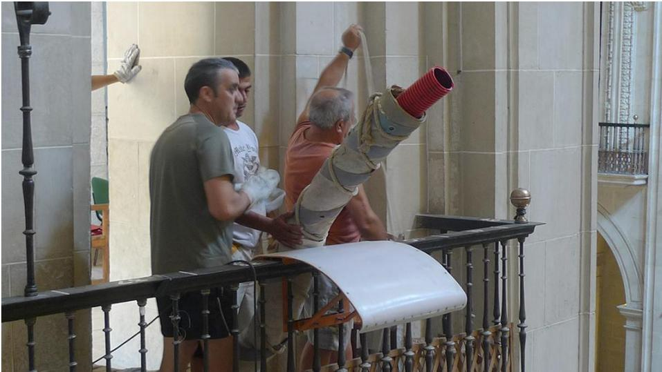
**Figura III-41:** Tobogán sujeto al balcón tras finalizar la labor de ascenso.
