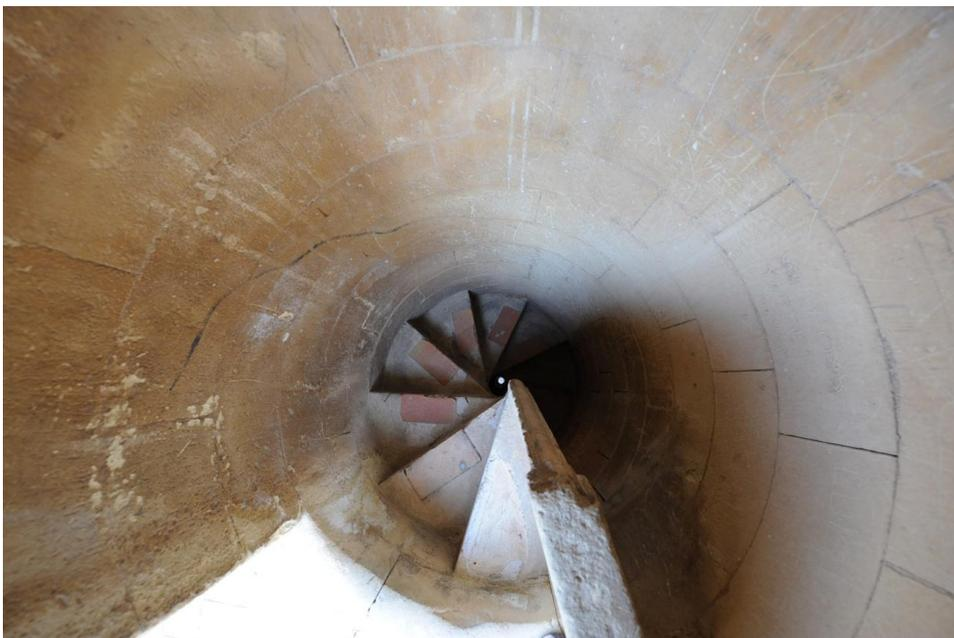
**Figura III-23:** Último tramo de la escalera de caracol, antes de su salida a la terraza del presbiterio, tercer tramo de escalera. Como se puede apreciar carece de alma.
