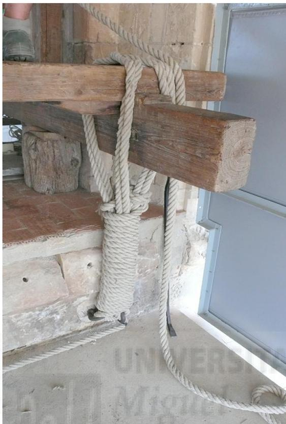
**Figura III-83:** Fotografía del tercer tirante, pilar derecho, pendiente de atar a la viga de voladizo y de cierre.
