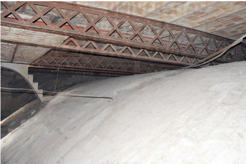
**Figura III-7:** Interior del trasdós de la nave, donde podemos ver el forjado de la cubierta de la nave principal, las viguetas, las bovedillas de ladrillo, y las vigas de celosía que sostienen la cubierta. Al fondo a la izquierda se ven las escaleras de acceso desde la caseta de vigas y el forjado que forma el piso de la caseta de vigas.
