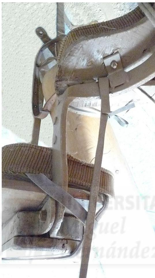
**Figura III-232:** Inicio de la formación del arco de circunferencia que sostiene al sitial lateral izquierdo, por delante del arco se puede ver el puente de cierre.
