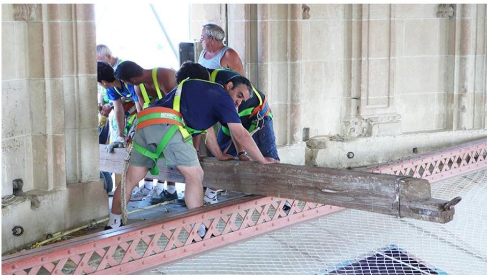
**Figura III-68:** Fotografía de los tramoyistas introduciendo una viga de voladizo.
