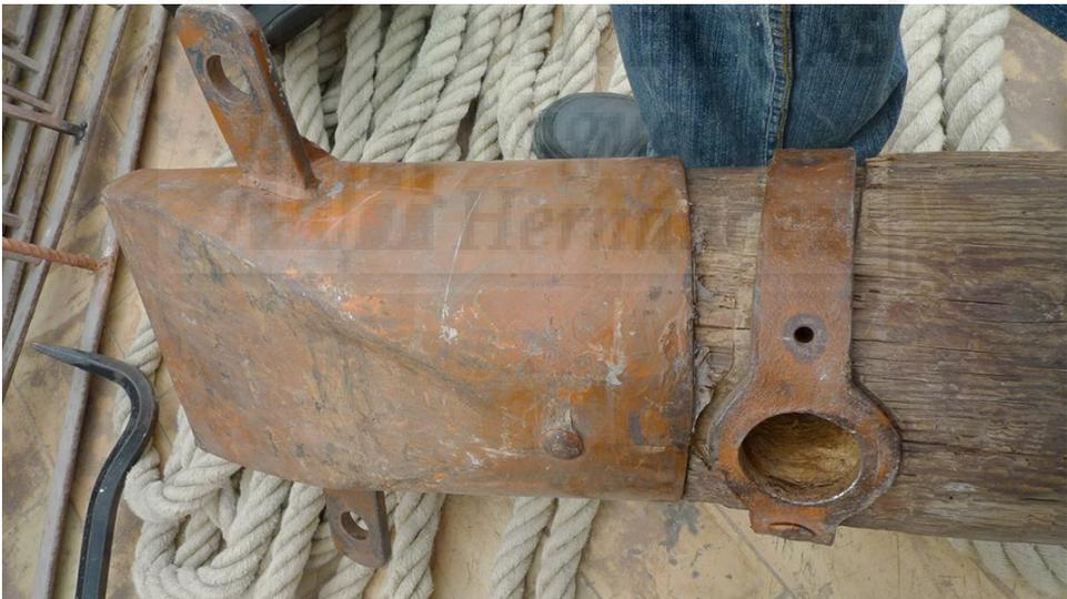
**Figura III-75:** Herraje de refuerzo de la cabecera del pilar.
