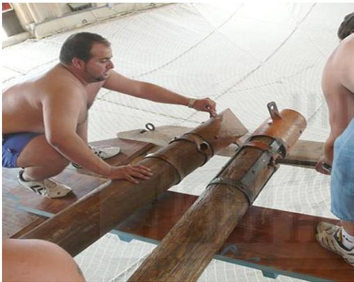
**Figura III-127:** Ensartado de los dos pilares.
