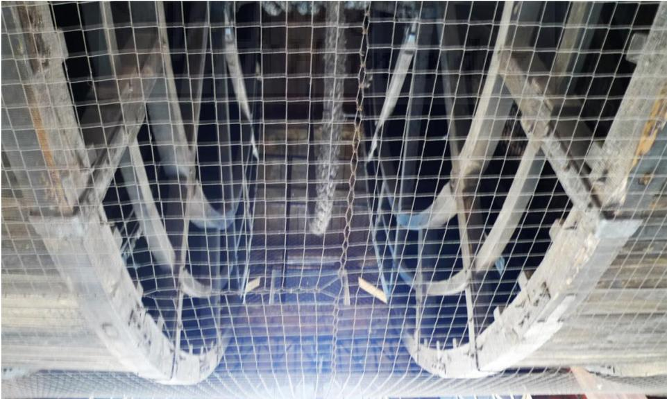
**Figura V-11:** Sistema de doble rueda, con el carrete situado entre ambas y perteneciente a las grúas de la figura anterior.
