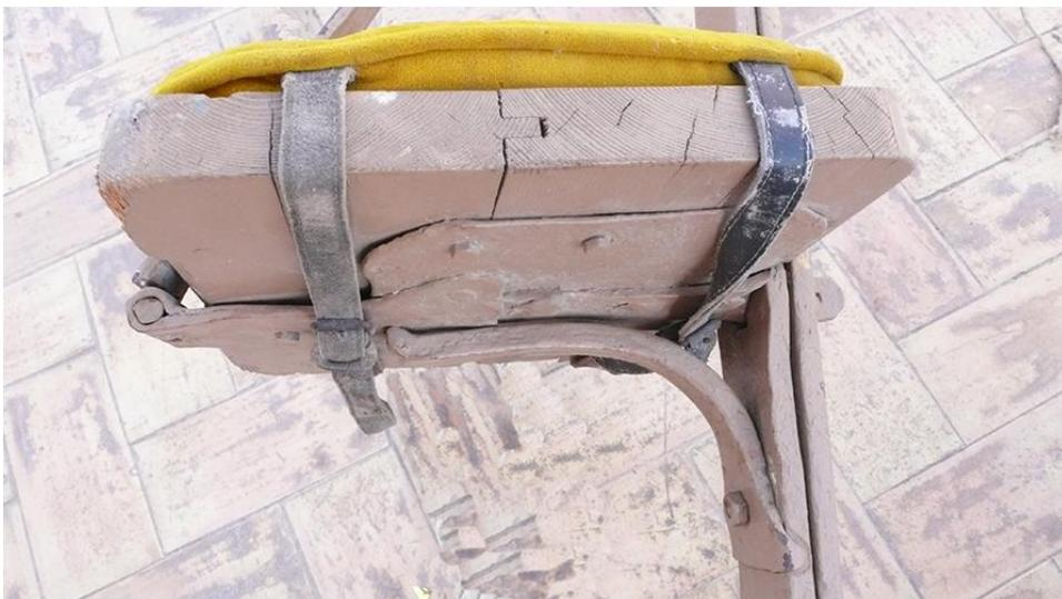
**Figura III-209:** Uno de los siales laterales, concretamente de los pertenecientes a la parte superior. Bajo el sitial se ve el jabalcón de refuerzo.
