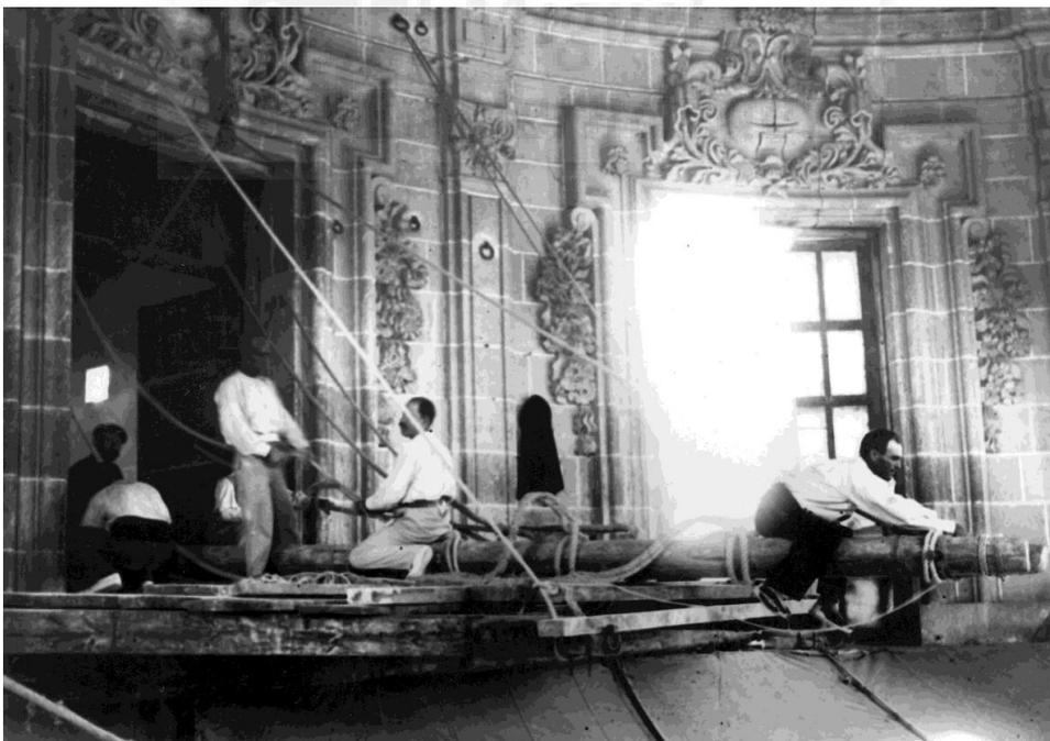
**Figura III-124:** Fotografía en la que un tramoyista está sujetando el vértice de la cabria mediante una maroma. Compárese con la figura III-135. Foto Pedro Ibarra.
