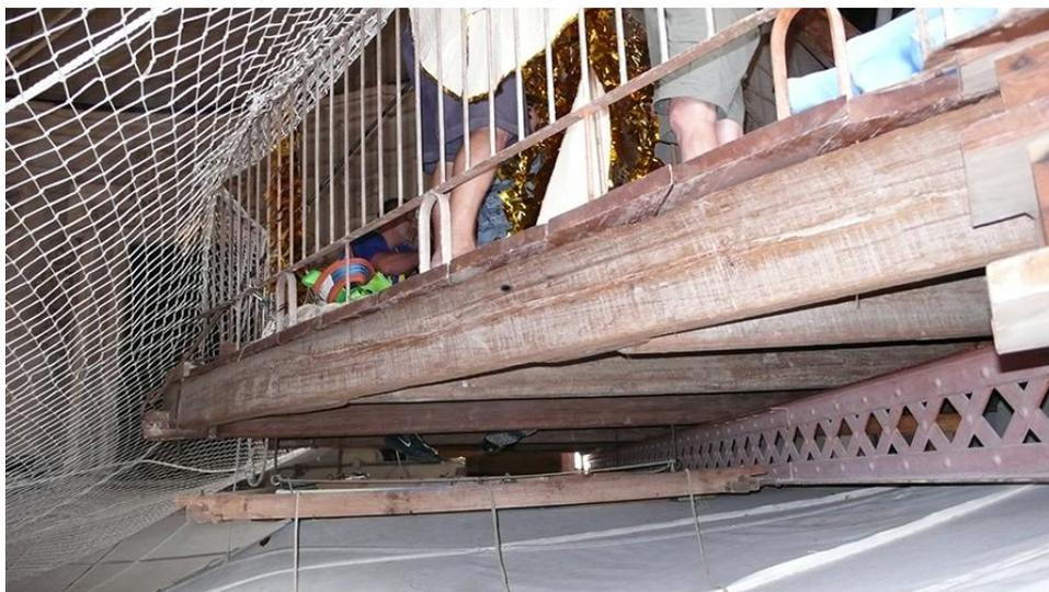
**Figura III-65:** Fotografía de la barandilla de protección sujeta a la plataforma.
