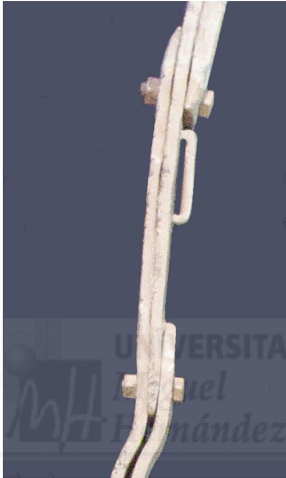
**Figura III-193:** Detalle de la unión de entre las pletinas que forman las parábolas en la parte izquierda.
