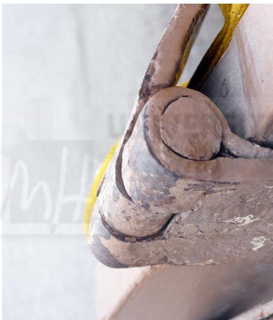
**Figura III-112:** Articulación correspondiente al arnés. La parte inferior son los cilindros del segundo trapecio.
