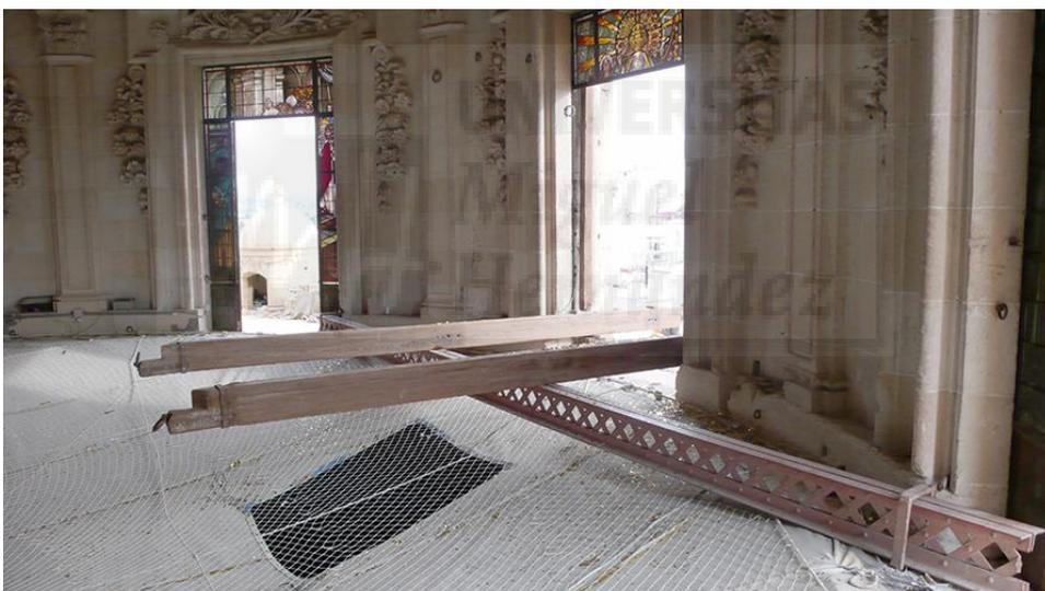
**Figura III-69.** Fotografía de las vigas de voladizo montadas.
