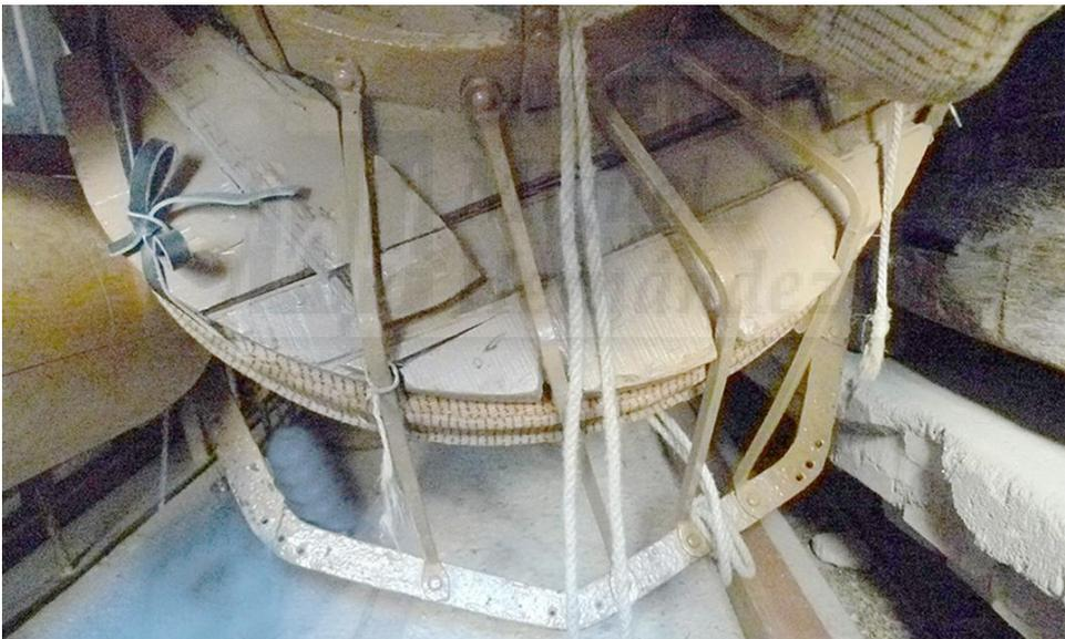
**Figura III-235:** Vista inferior del sitial central donde se ven las piezas con forma de L que crean el respaldo.
