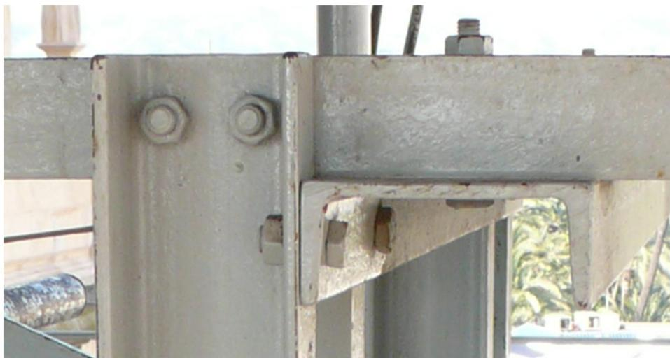
**Figura III-105:** Fotografía realizada a la unión de las vigas en un vértice del ortoedro.
