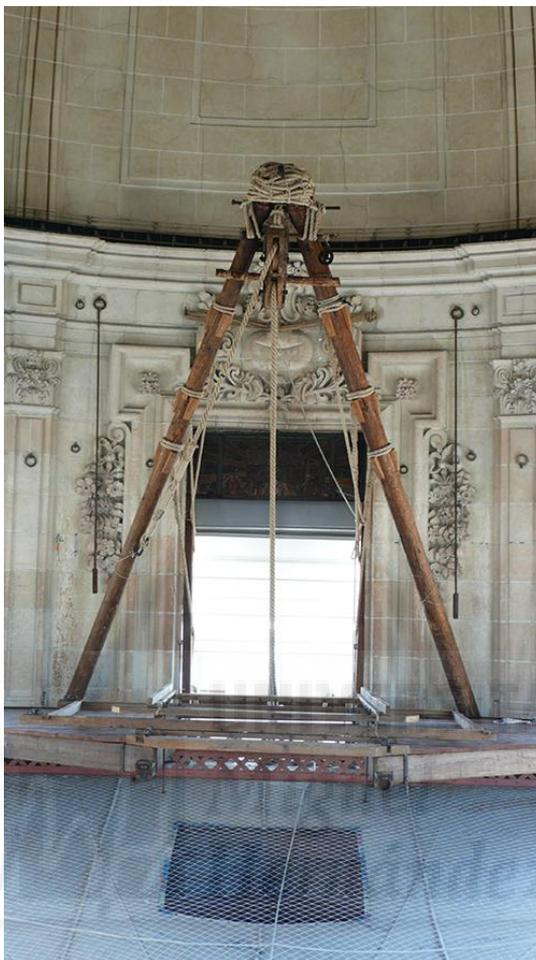
**Figura III-70:** Fotografía tomada desde la ventana de poniente de la cabria montada a falta del tirante compensador de fuerzas pasivas. Al fondo, por encima del dintel y a los laterales de las jambas de la ventana se encuentran colgando parte de los tirantes de la plataforma.
