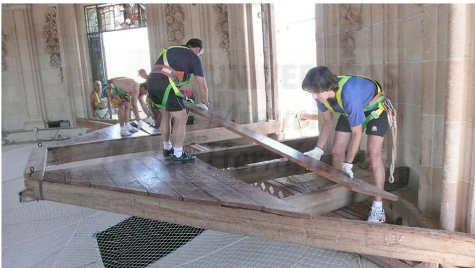
**Figura III-63:** Fotografía efectuada desde la cornisa en la que se ve cómo se va colocando el piso del tablado.
