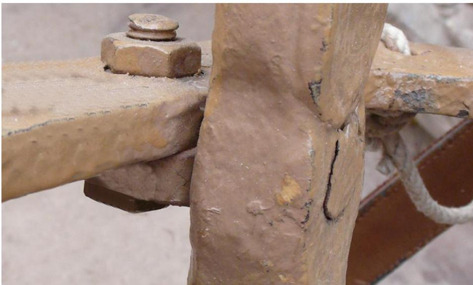
**Figura III-238:** Cancano de sujeción del aro octagonal al arco de suspensión.
