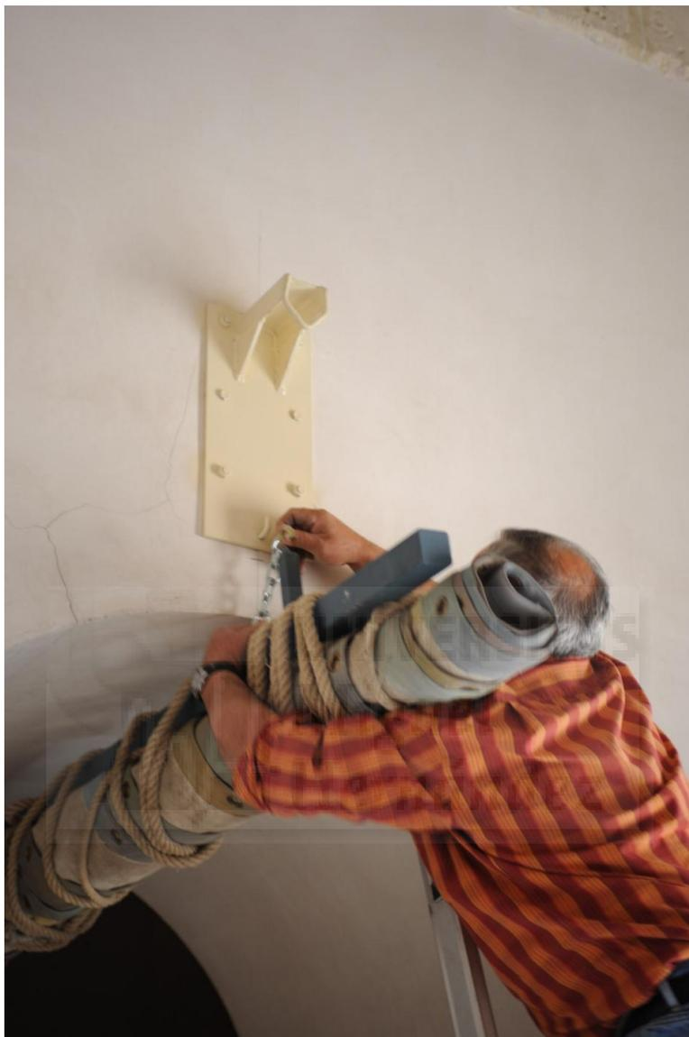
**Figura III-44:** Sujeción con una cadena de la viga al punto anclado a la clave del arco.
