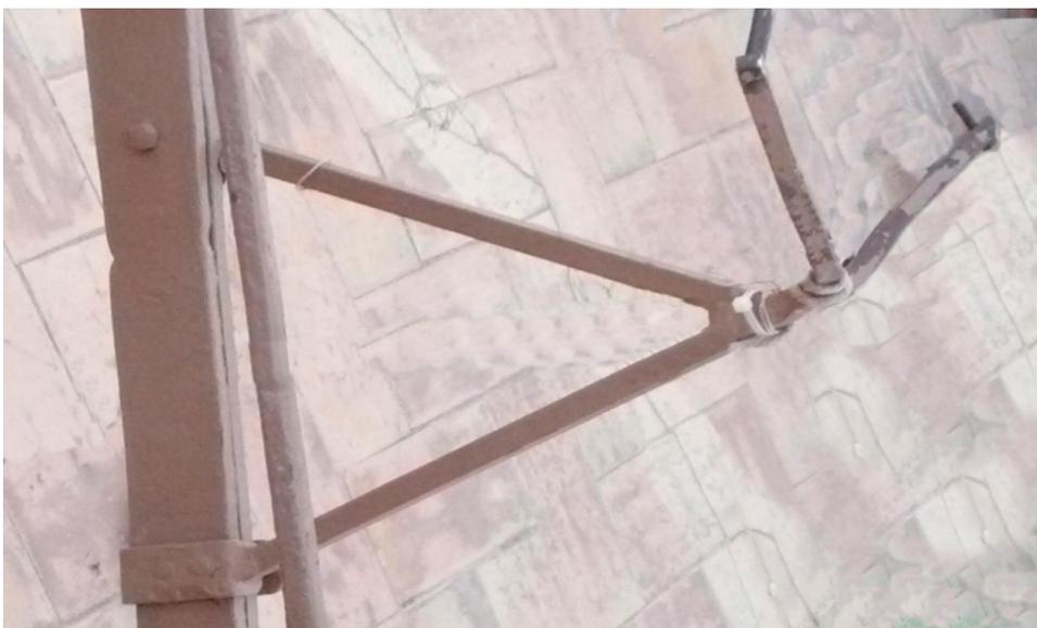
**Figura III-215:** Accesorio para la sujeción del arpa al aparato.
