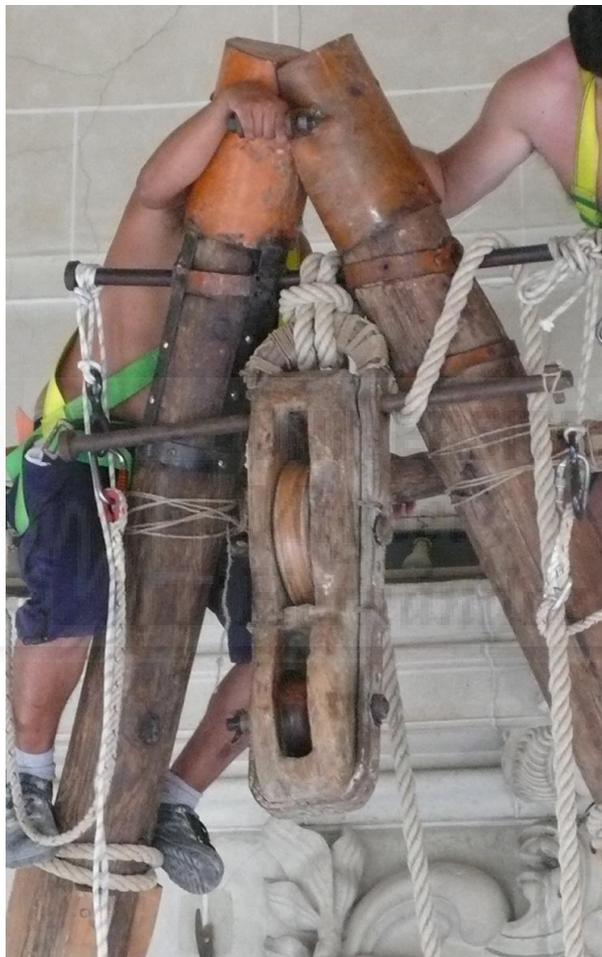
**Figura III-92:** Unión del vértice y el atado a la barra de acero de la polea del vértice.
