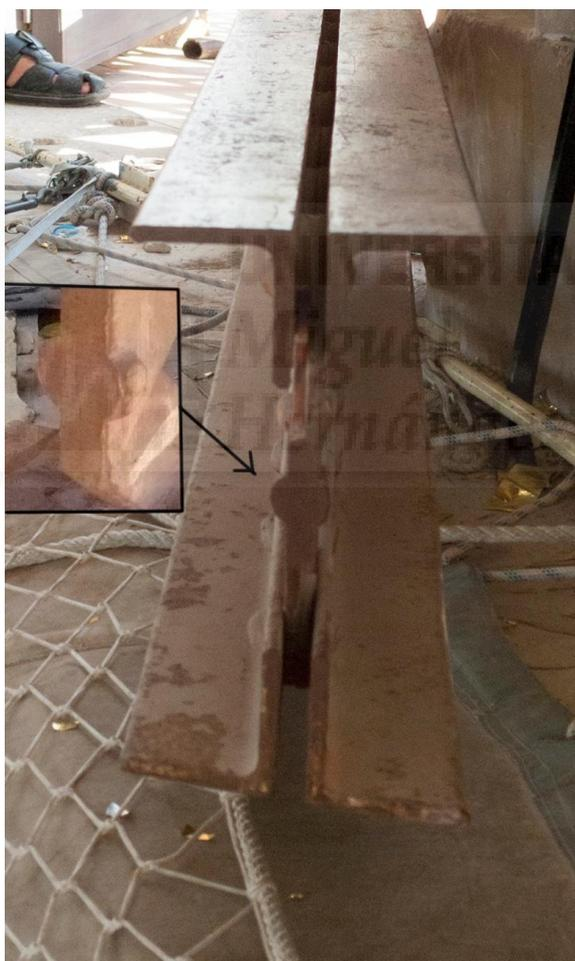
**Figura III-46:** Sección de la jácena o viga maestra, con el detalle de uno de los roblones, que fija a las aspas por el centro, seccionado.
