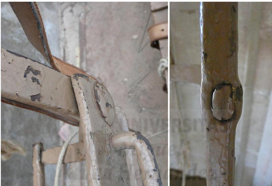
**Figura III.208:** Detalle de sujeción con roblones de los arcos de elipse a los pilares de sujeción del arnés. A la izquierda extremos de los arcos, a la derecha sobre la pletina con forma de L.
