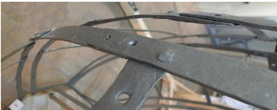
**Figura III-168:** Detalle de empalme en el lateral del bastidor del ala. En primer plano, la arista lateral izquierda del ala número 8 compuesta por nueve trozos de pletina empalmada.
