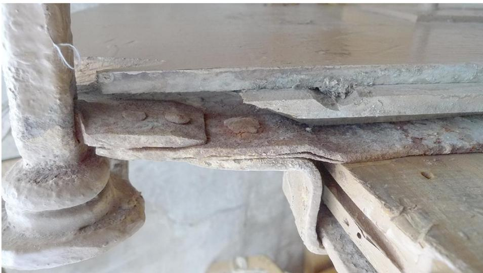
**Figura III-204:** Sujeción al pilar izquierdo de la pletina en voladizo y a esta los dos puentes de sujeción de la tabla y del herraje.
