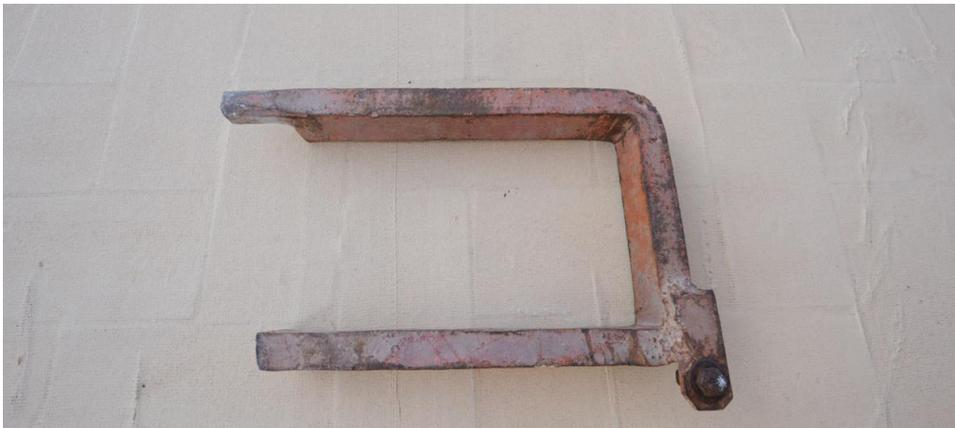
**Figura III-49:** Uno de los estribos de sujeción de la viga maestra.
