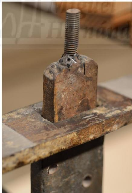
**Figura IV-20:** Sistema de unión muesca-espiga que efectúan los pilares secundarios al marco superior o a los travesaños.
