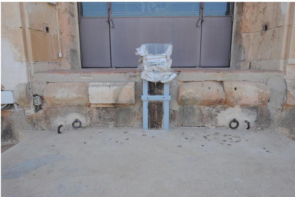
**Figura III-10:** El umbral de la ventana de levante, donde se pueden ver las anillas y ganchos anclados a los sillares y que se destinan a la sujeción de la plataforma, la armadura de las poleas de remonte y la protección de las poleas, que quedan cubiertas, contra la intemperie; también se aprecia el desnivel que hay con respecto a la terraza del presbiterio.
