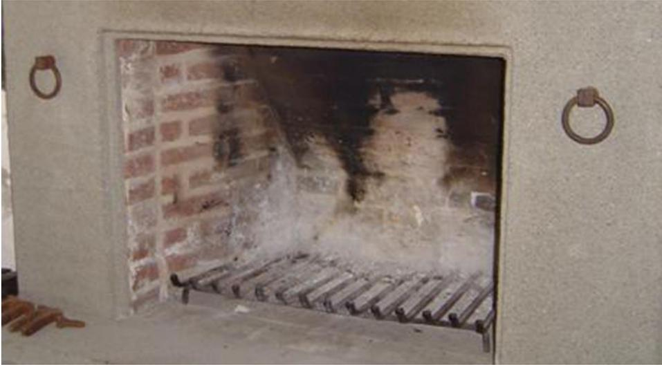
**Figura IV-6:** Cocina de calefacción por combustión de biomasa. Sobre la pared se puede apreciar la zona con forma de V invertida donde las temperaturas han alcanzado su máximo valor.
