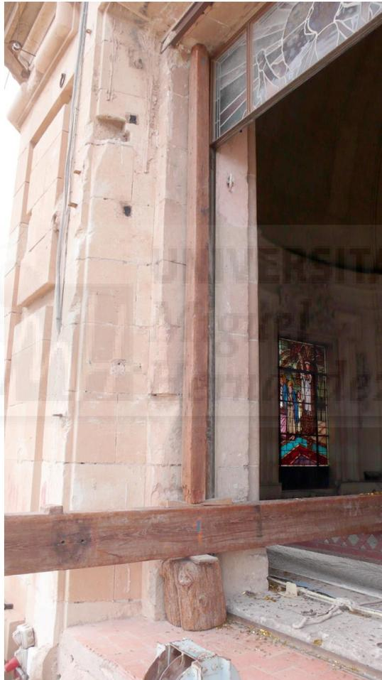
**Figura III-58:** Pilar de apoyo de la viga de voladizo sobre el umbral de la ventana y por encima de su cordón superior el pilar que apoyando en el dintel de la ventana bloquea a la viga de voladizo, la presión la ejercen la cuñas metidas a presión.
