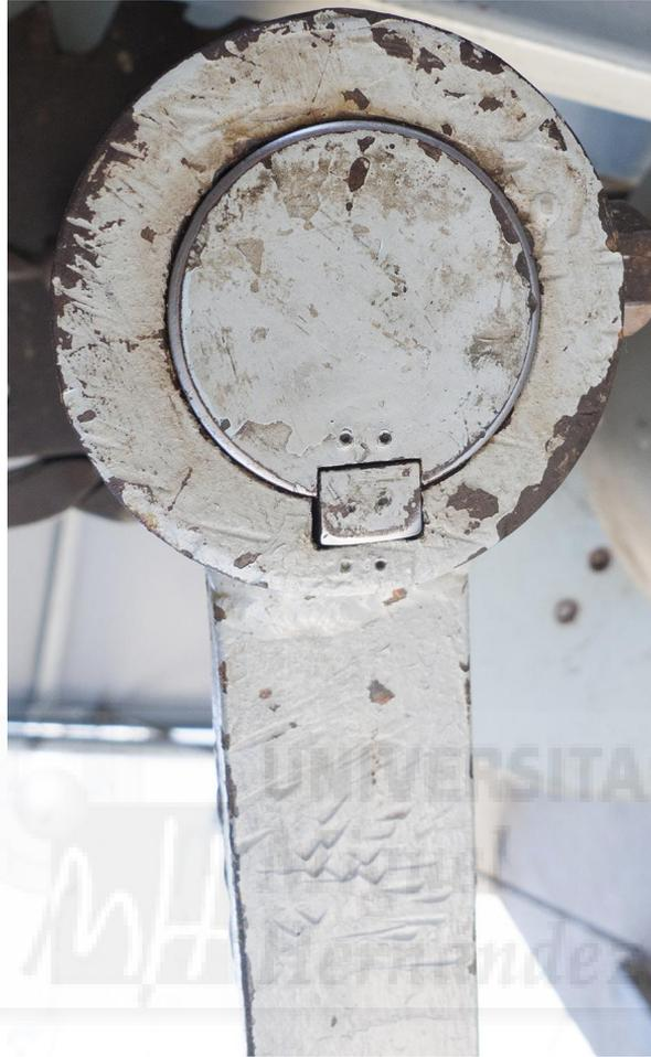
**Figura III-108:** Fotografía del detalle de unión de las cigüeñas a los árboles.
