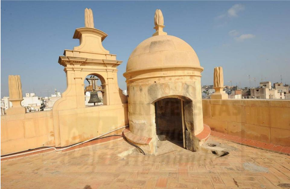
**Figura III-4:** Foto efectuada desde el cimborrio, en la que se ve la espadaña y la torreta convertida en aseo y junto a está y a su derecha un sumidero de pluviales.
