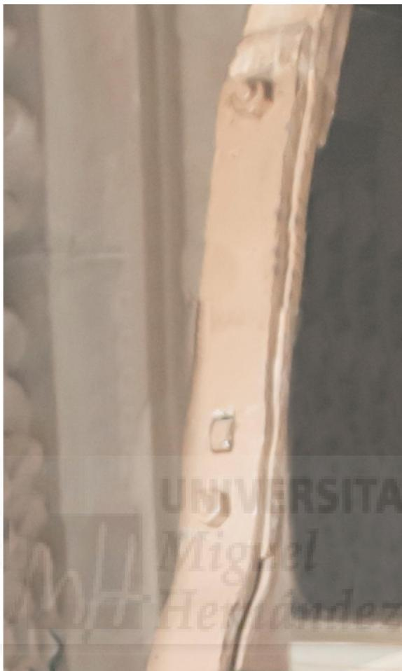
**Figura III-196:** Detalle de la unión con la coincidencia de las tres pletinas visto por el exterior. Entre tornillos de ve la muesca.
