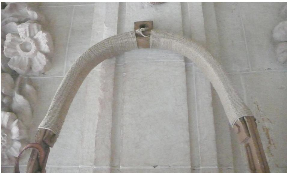
**Figura III-197:** Forma de solapar ambos arcos para evitar el giro del interior.
