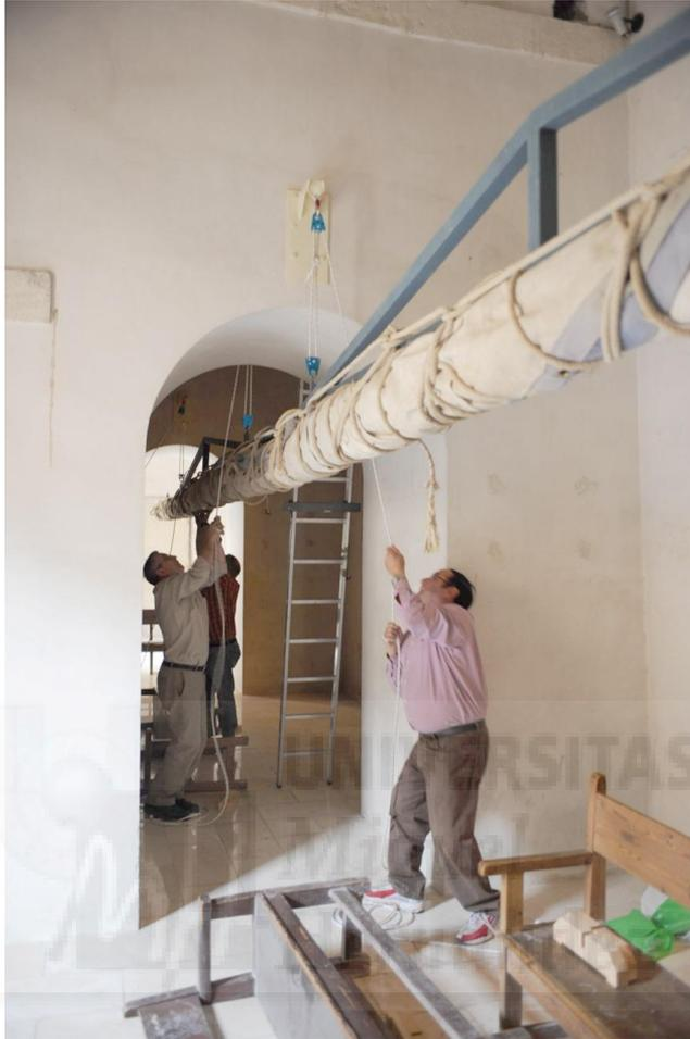
**Figura III-43:** El lienzo liado a sí mismo y a la viga que los sostiene en fase de elevación hasta las claves de los arcos con la ayuda de unos polipastos y unos puntos de fijación sujetos en las claves de los arcos.
