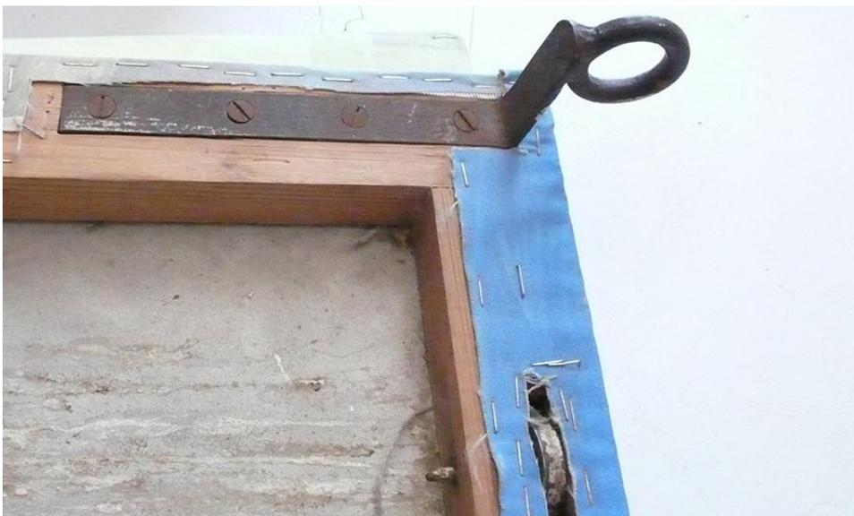
**Figura III-150:** Fotografía de un vértice trasero de una puerta. En ella se muestra la L metálica con la anilla para la sujeción de la puerta a la cuerda de apertura y cierre junto con un rodillo de rodadura de la puerta sobre el bastidor y un extremo del eje sobre el que gira.
