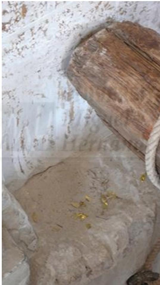
**Figura III-20:** Oquedad labrada en el sillar del cimborrio para apoyar el pilar de la cabria, arriba a la derecha, la base de un pilar de la cabria.
