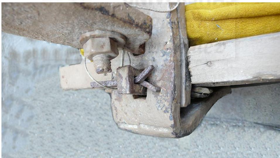
**Figura III-211:** Extremo de la espiga con el orificio por el que se ha ensartado una cuña de sujeción. En la parte superior la tuerca y el perno roscado perteneciente al jabalcón del sitial central sujeto al travesaño inferior, en la parte inferior, el jabalcón de un sitial inferior.
