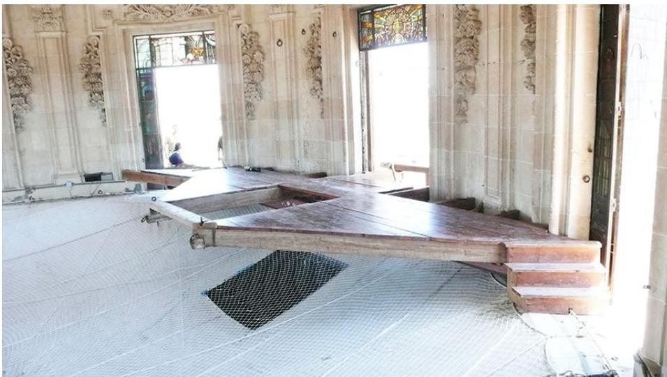
**Figura III-45:** La plataforma, centrado en ella se puede ver la puerta de levante, el orificio para el paso de los aparatos y a la derecha, junto a la puerta del sureste, una escalera de acceso. Bajo ella el lienzo del cielo con el orificio cuadrado.
