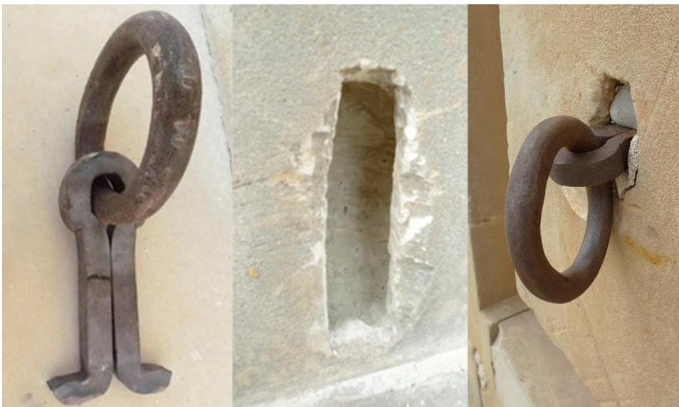
**Figura III-17:** A la izquierda en primer lugar, fotografía del herraje con forma de  $\Omega$  destinado a introducir sus dos “L” en el orificio con forma de tronco de pirámide invertida y tras girarlo 90° y rellenarlo con mortero, crear un punto de anclaje. En el centro fotografía del orificio formado en el sillar y a la derecha fotografía del anclaje terminado.
