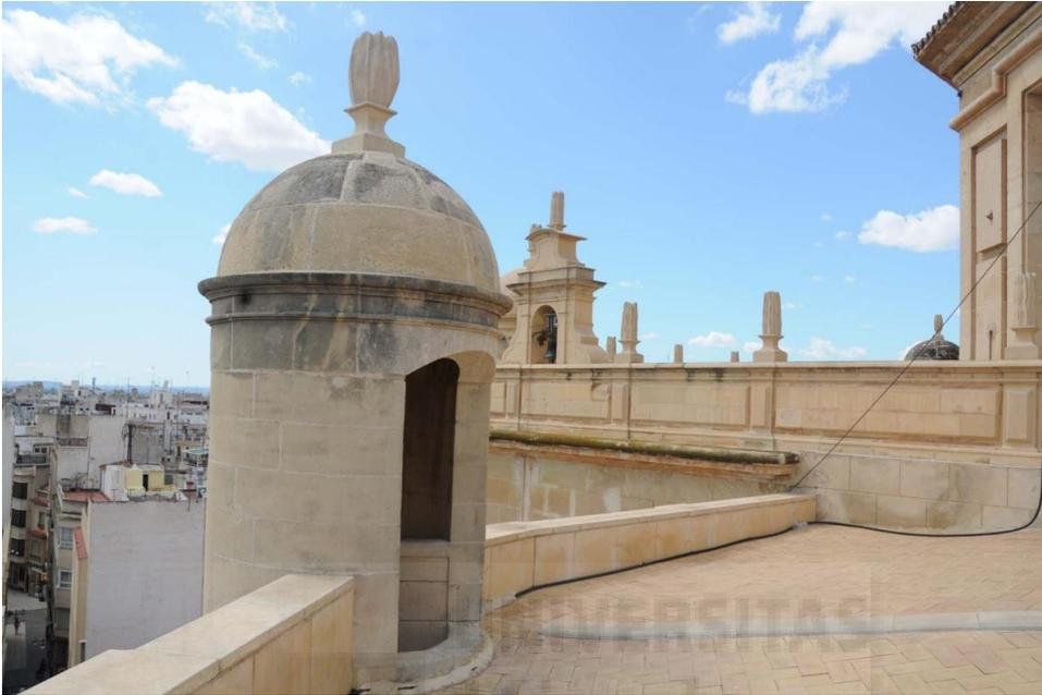
**Figura III-5:** Torreta que cierra las escaleras de acceso a la terraza. Al fondo se ve la espadaña y un tramo del pretil, situado al sur, que cierra la terraza del crucero.
