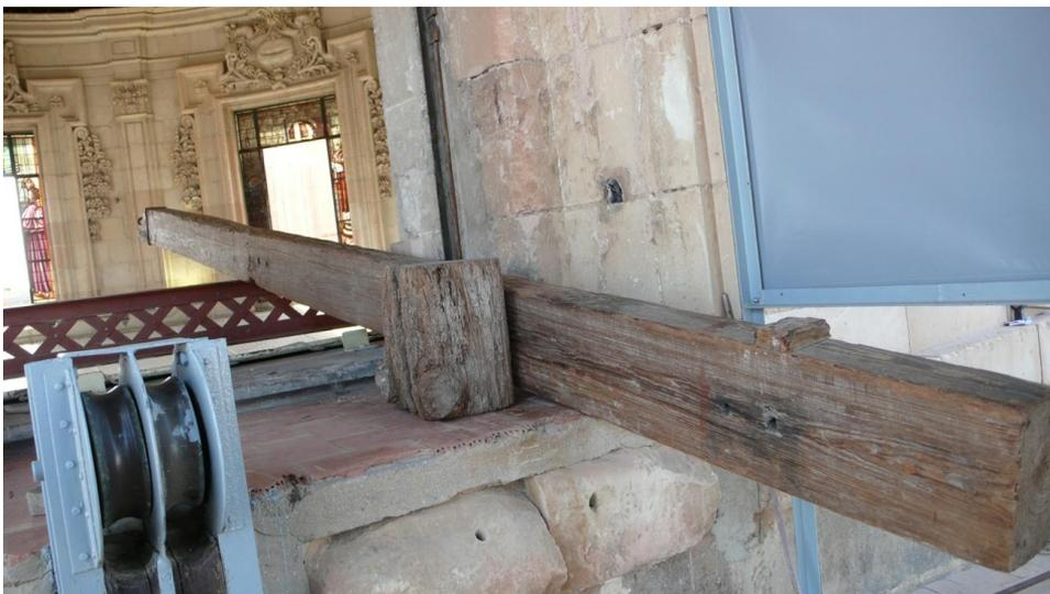
**Figura III-51:** Viga de voladizo vista por su parte trasera junto a su pilar de apoyo. En la parte trasera se puede ver el tope de la viga de cierre trasera y en primer plano a la derecha las poleas de remonte.
