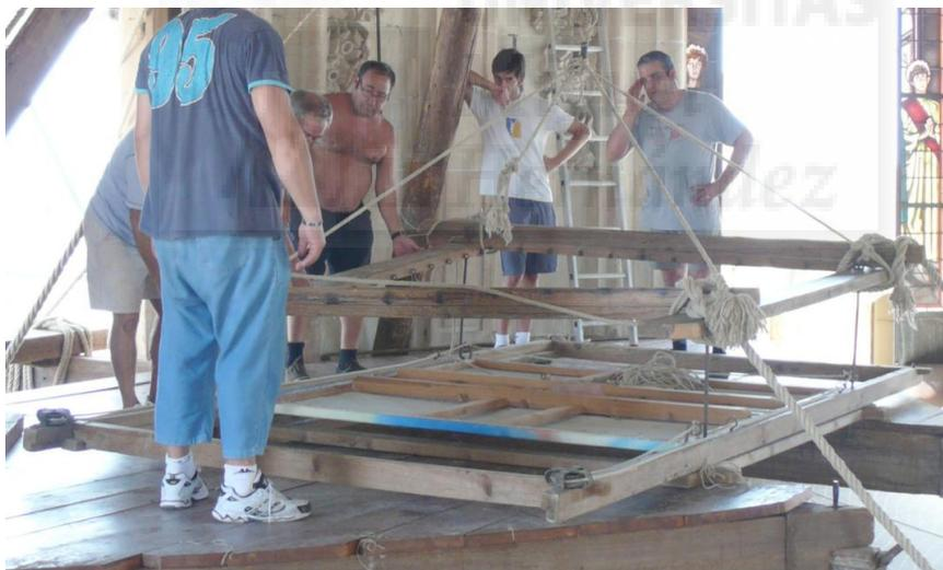
**Figura III-140:** Fotografía del armazón totalmente armado y suspendido de la cabria para ser situado en su lugar.
