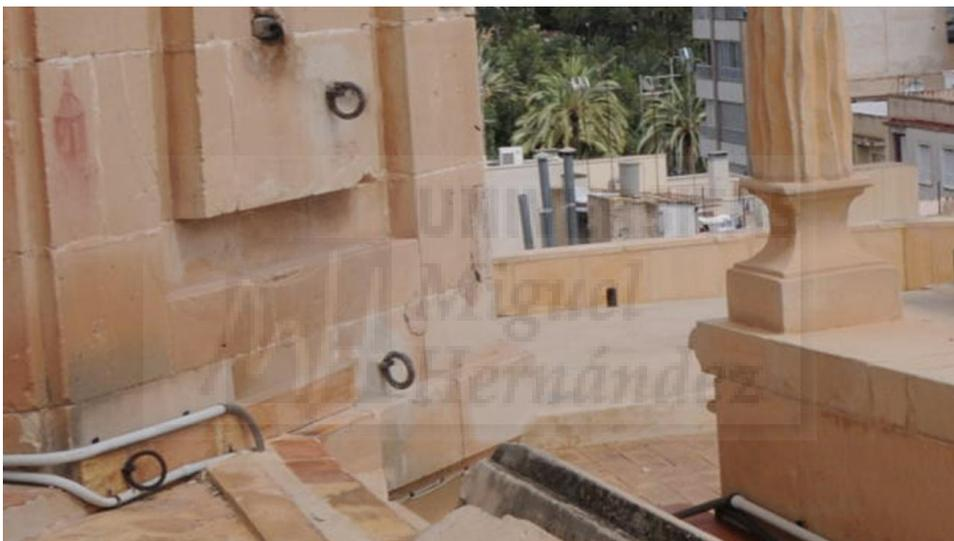
**Figura III-21:** Fotografía de las dos argollas para el atirantado de la cabria, situadas junto a la cara del sureste del tambor.
