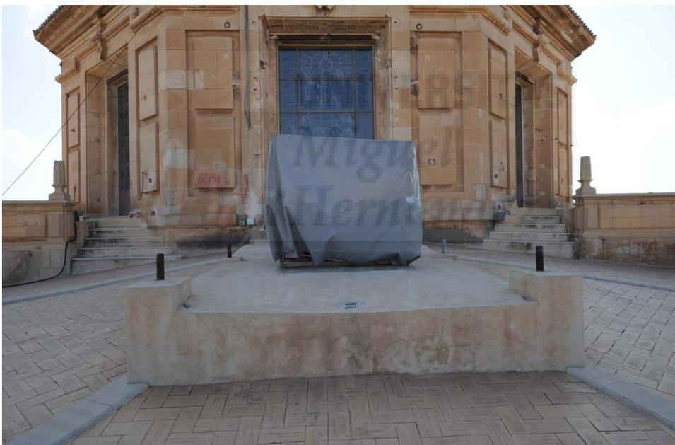
**Figura III-2:** Foto efectuada desde el lado de levante, en el que se puede ver la terraza del presbiterio, en primer plano la losa de anclaje de los tornos con estos cubiertos junto con los arranques de los pilares de la caseta desmontable; al fondo las escaleras de acceso a la terraza del crucero flanqueadas, cada una, por un penacho flamígero y en el centro la ventana de levante del cimborrio. .
