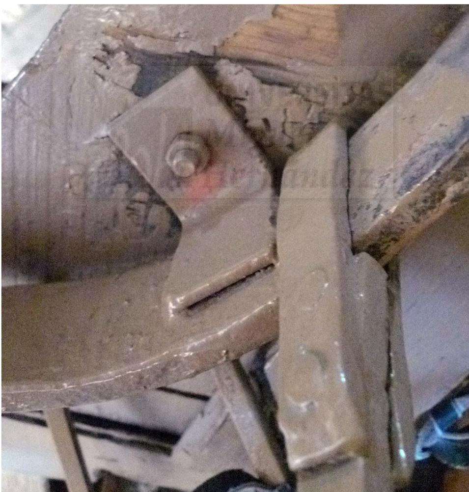
**Figura III-241:** Fijación de los tirante al arco de circunferencia y de la madera del sitial.
