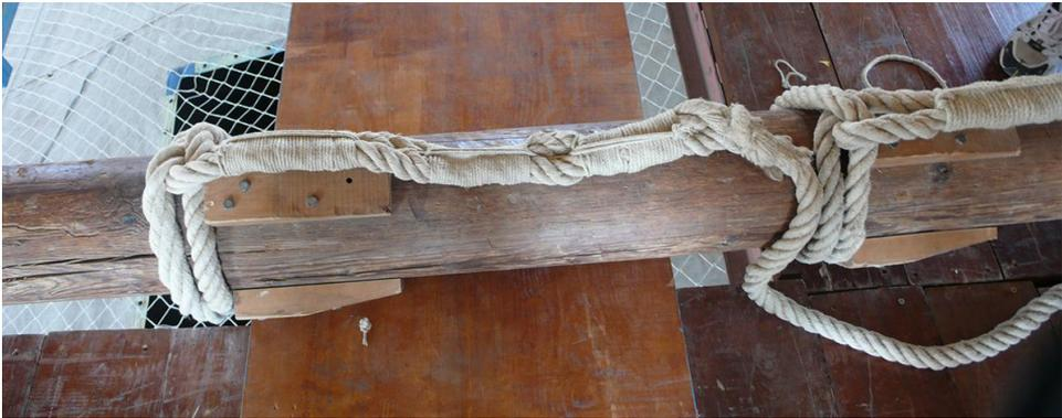
**Figura III-80:** Fotografía de los nudos de atado de las maromas a los pilares y cuñas de retención.
