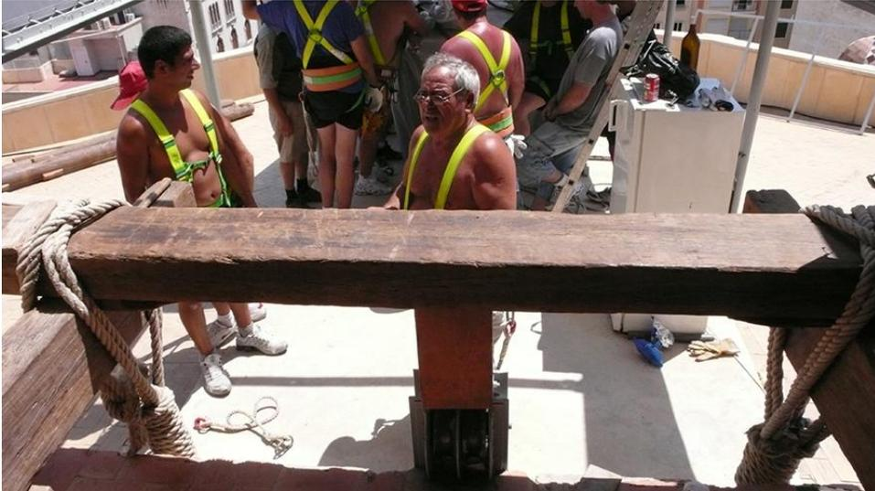
**Figura III-56:** Vista desde lo alto del umbral de la ventana de levante a la viga de cierre trasera. Se pueden observar los dos atados de los externos de las vigas de voladizo y el tope de seguridad para las poleas de remonte.
