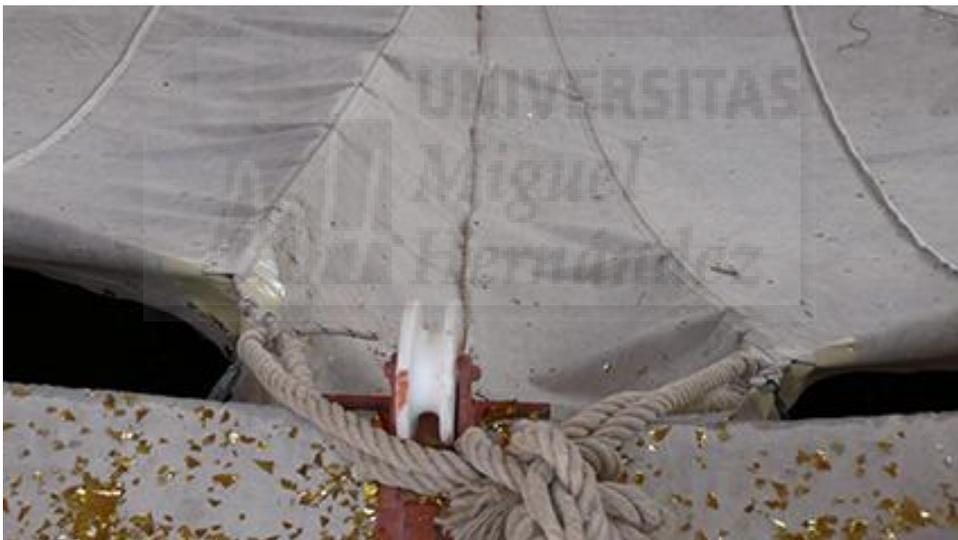
**Figura III-36:** Cómo cada dos radios, atados entre sí, se sujetan a la polea de izado.
