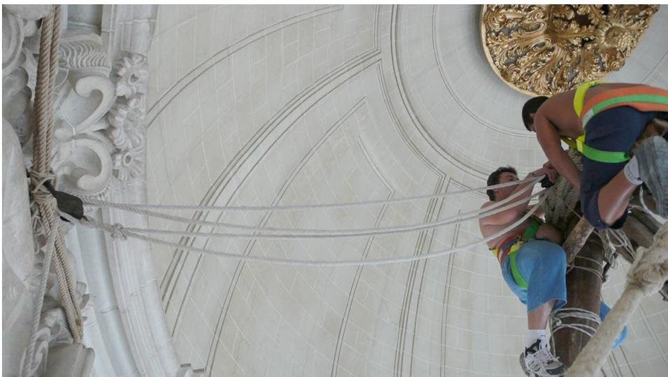
**Figura III-79:** Fotografía del aparejo para la regulación de la cabria (séptimo tirante).
