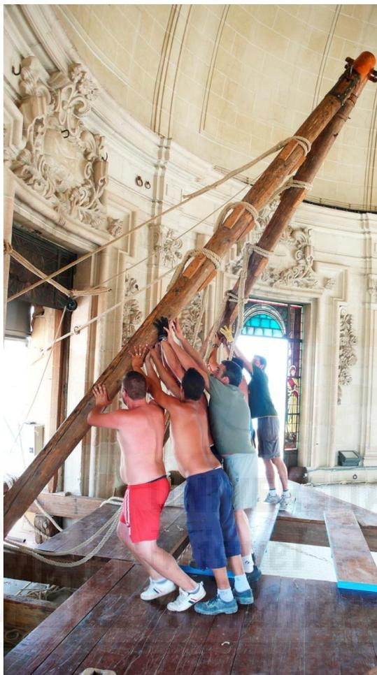
**Figura III-78:** Izado de la cabria con la ayuda de la polea sujeta a unos tirantes dispuestos entre las jambas y el torno.
