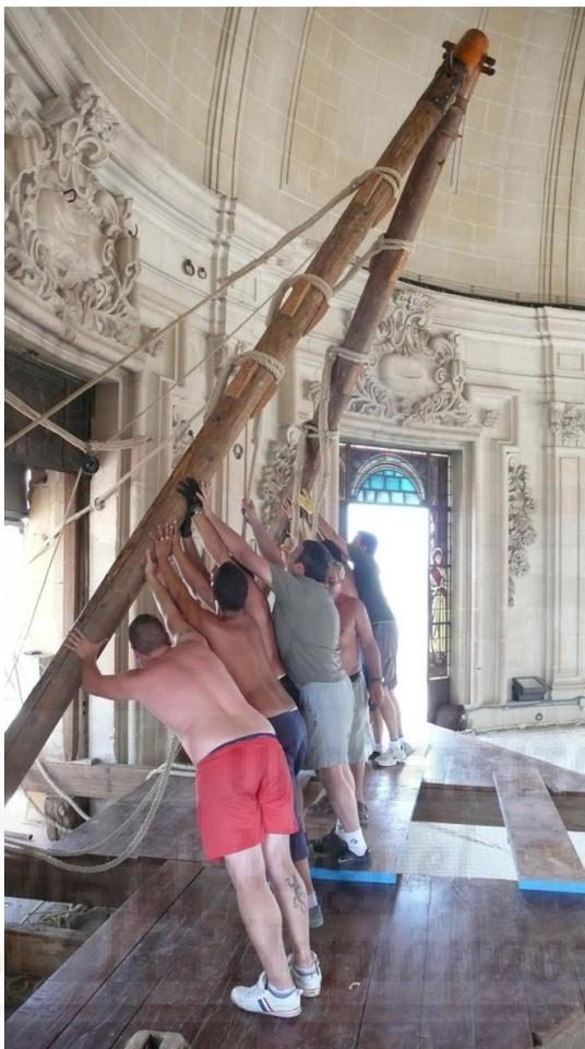
**Figura III-137:** Fotografía del izado de la cabria entre el personal y la ayuda del torno.
