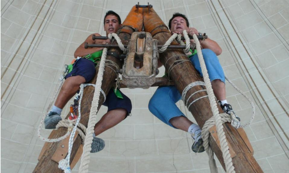
**Figura III-77:** Vértice de la cabria con los dos pilares sujetos entre sí, las barras de acero de la cabria, la polea en su posición y la polea doble del vértice comenzándose a sujetar.
