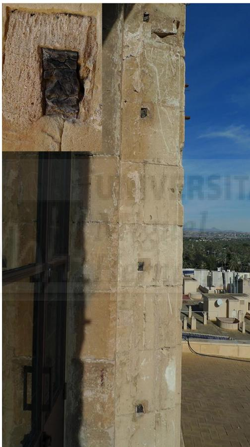
**Figura IV-10:** Situación de los puntos de anclaje a la jamba de la parte norte, perteneciente a la ventana del este, del antiguo cierre de la ventana. Actualmente se encuentra la madera que da al exterior completamente carbonizada. Uno de los anclajes se muestra ampliado en la parte superior izquierda de la figura.
