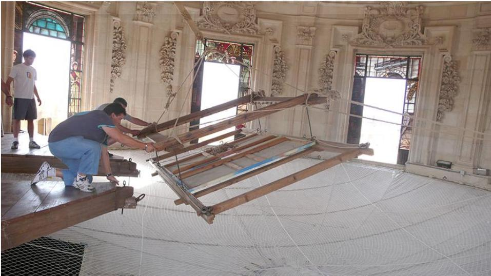
**Figura III-152:** Fotografía del armazón en alto, suspendido de la cabria, y tirando de él los tramoyistas situados en la ventana de poniente.
