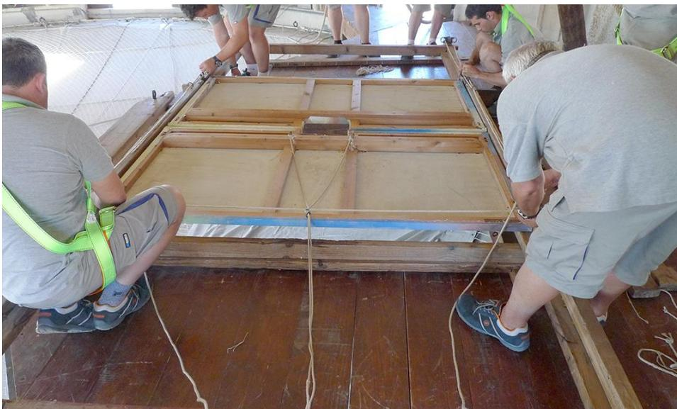
**Figura III-151:** Fotografía del sistema de cuerdas para la apertura y cierre de puertas.
