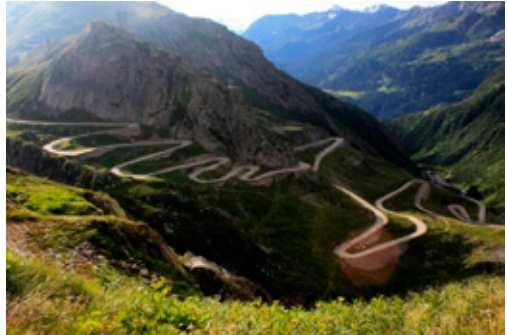
Imagen de un tramo de la carretera Transfágaras
