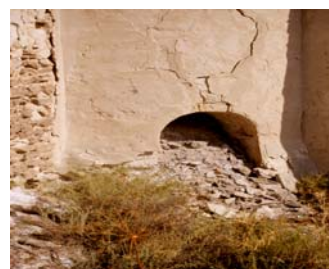
Horno tipo Claret. A la izquierda la puerta de carga y a la derecha la de descarga.
