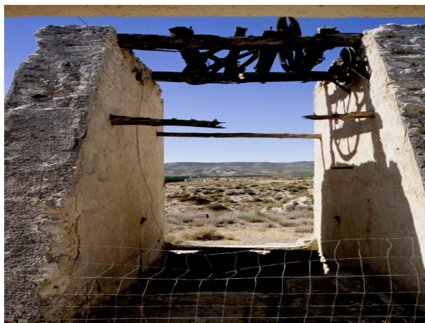
Pozo Alfonsito. Conserva su castillete con las poleas de hierro.
