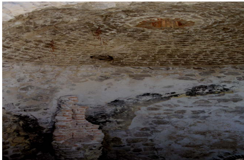
Interior de horno tipo Claret, en el que se aprecia el conducto de calor interno .
