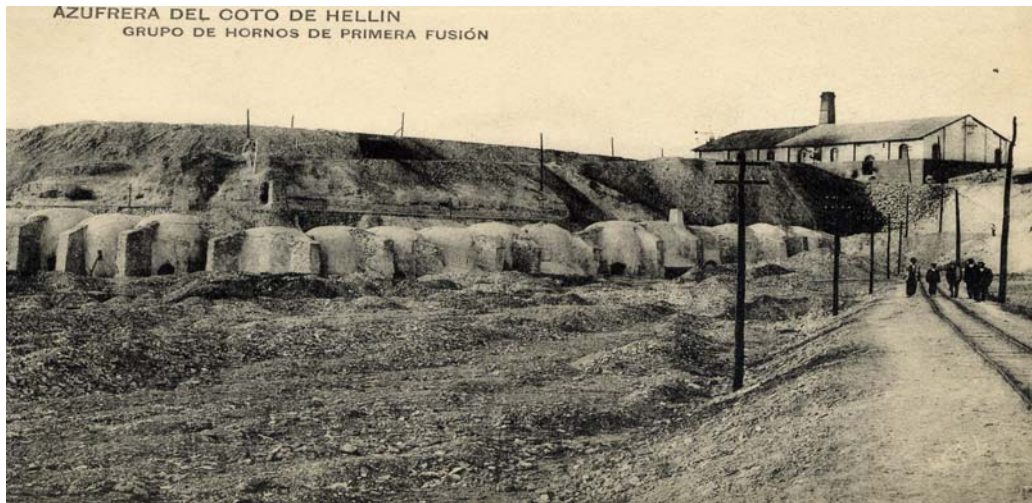
La central vista junto al grupo de hornos el Carmen. De ella asoma la chimenea de las calderas a vapor.
