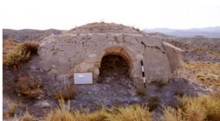
Horno tipo Claret. A la izquierda la puerta de carga y a la derecha la de descarga.
