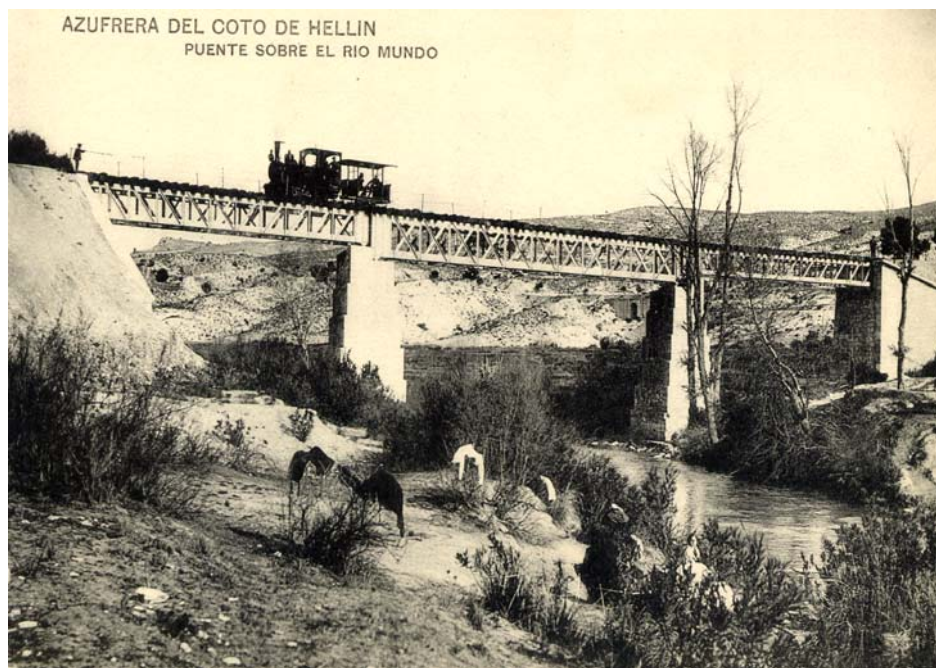
Puente del tren minero sobre el río Mundo.
