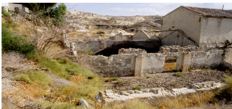
Almacén con pasillos cortafuegos.
