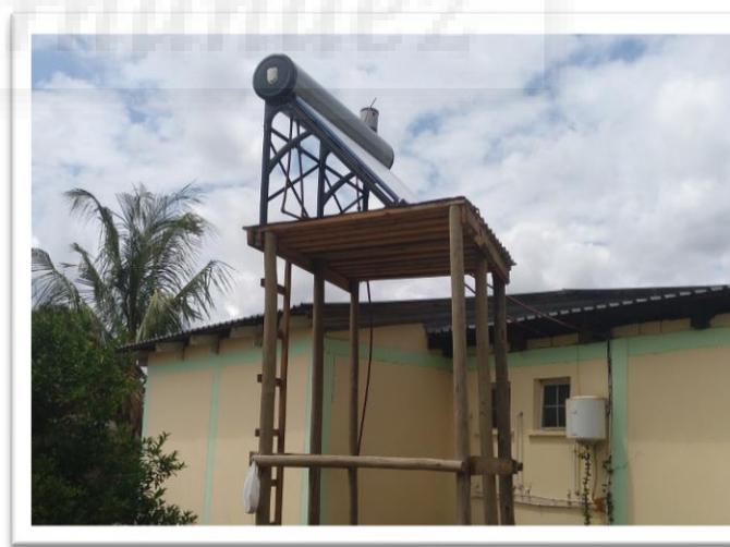
Imagen 4: Crear e instaurar un depósito de agua caliente
