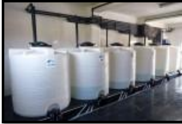
Figura 2. Cubas de riego. Sistema de abonado.
