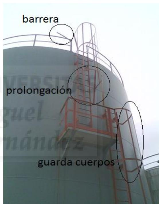
Figura 6: Descripción de los elementos de protección en las escaleras de gato.
