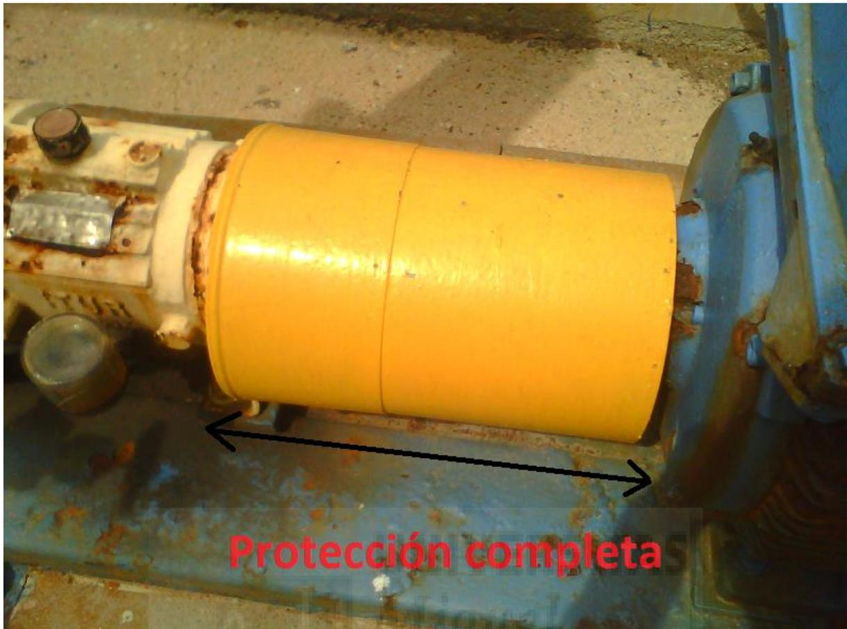
Figura 9: Protección de motor ideal o esperado.
