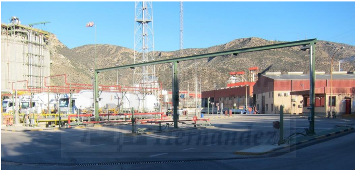
Ilustración 5. Área de carga de cisternas
