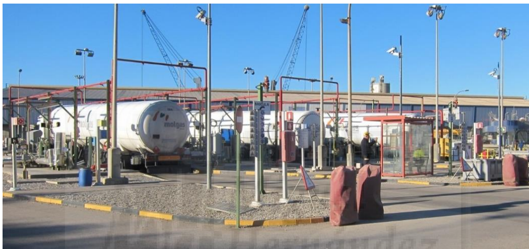
Ilustración 3. Cargadero de cisternas
