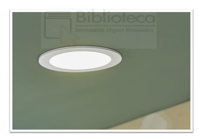
5.13 Ud Downlight led de 40W, totalmente equipada, modelo a elegir por la Dirección Facultativa y la propidad. pp del circuito, totalmente instalada y funcionando. Ubicación según planos.
