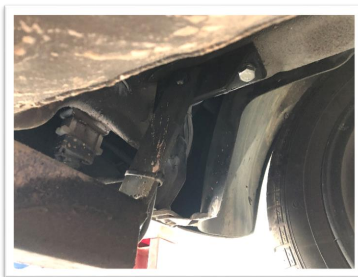
Ilustración 9: Pletinas de unión (fuente: foto propia)
