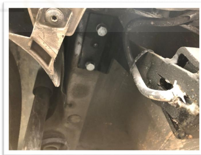
Ilustración 11: Pletinas de unión (fuente: foto propia)
