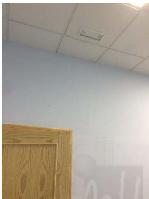
Luz de emergencia sobre puerta consulta. Luz de emergencia en sala de rehabilitación.
