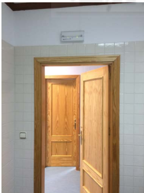
Luz de emergencia sobre puerta baño. Luz emergencia sala de electroterapia.
