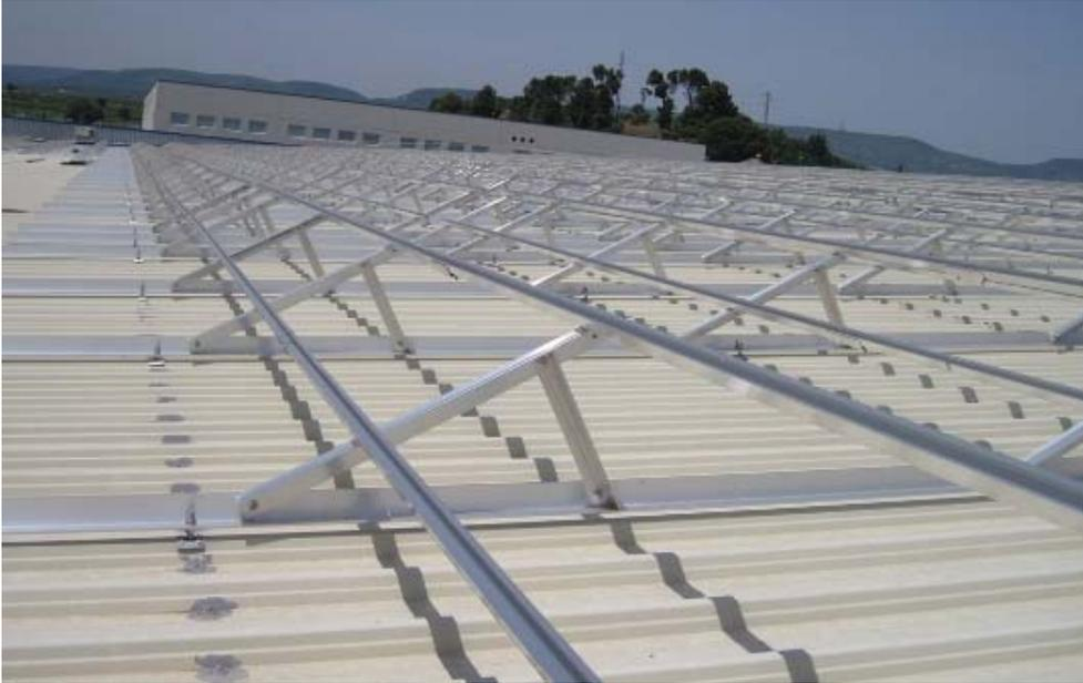
**Foto 8. Detalle de estructura metálica de fijación de placas solares a tejado de nave**
