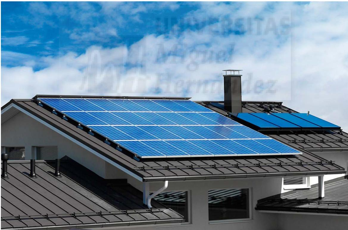
**Foto 5. Instalación solar fotovoltaica para vivienda aislada**
