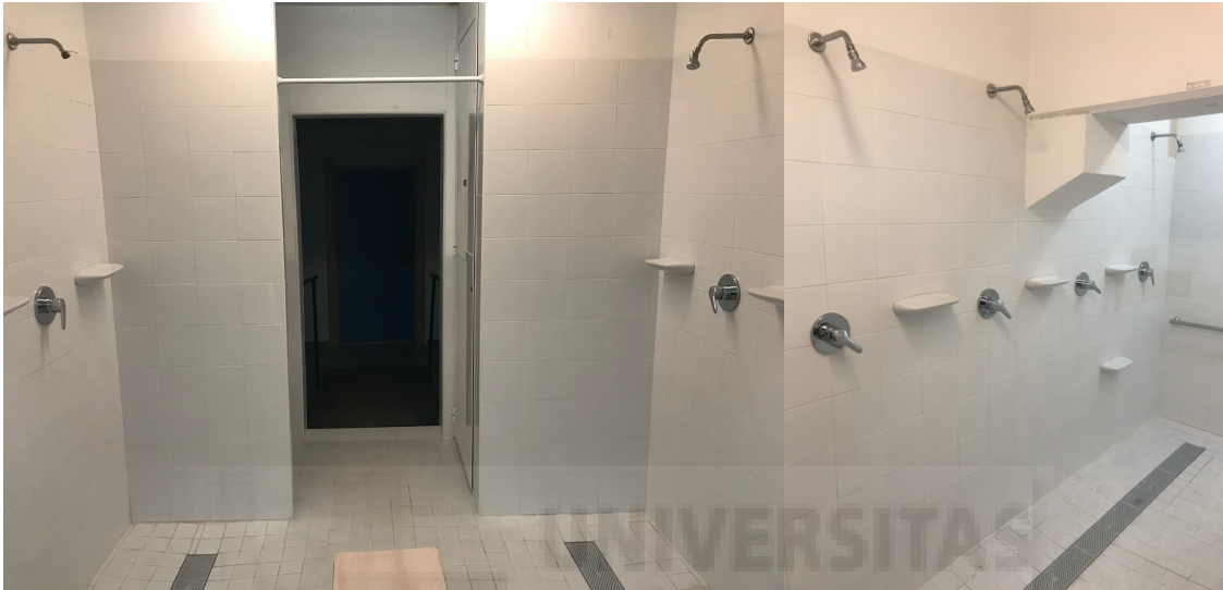
Fig. 36: Vestuarios en desuso de la Facultad de BBAA de Altea.
