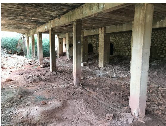
Fig. 12 Espacios industriales abandonados.
