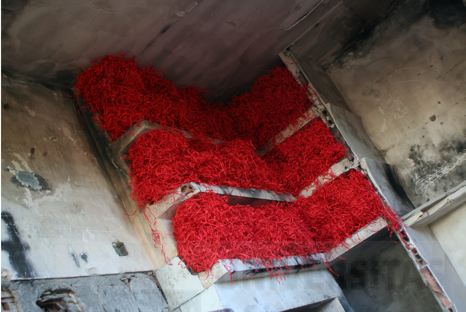
Fig. 23: Instalación en mobiliario fijo.
