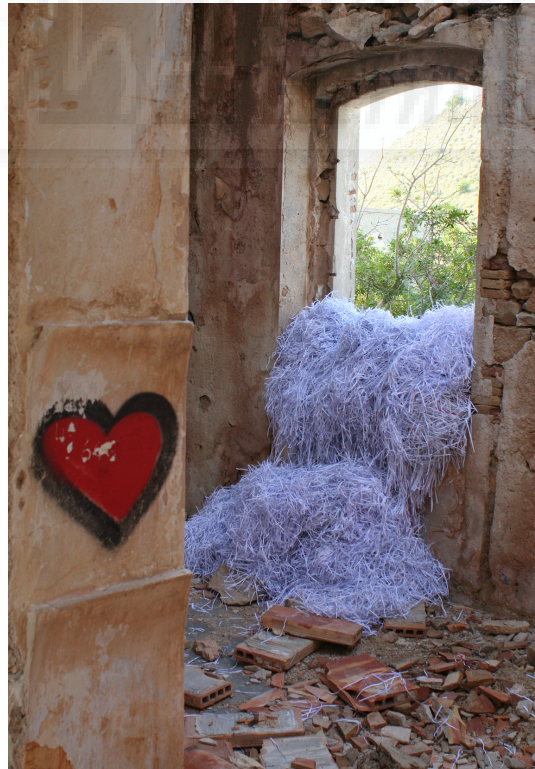
Fig. 20: Intervención en una ventana.
