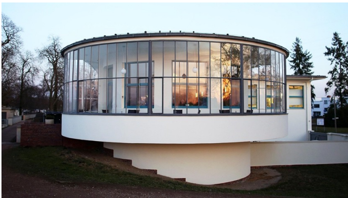
Fig. 1. Fieger, Carl. Kornhaus (1929-30), Dessau. Arquitectura de la escuela Bauhaus. Fotografía recuperada de https://www.thetimes.co.uk
