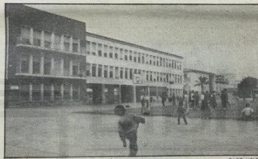
Temen que el edificio se venga abajo.
