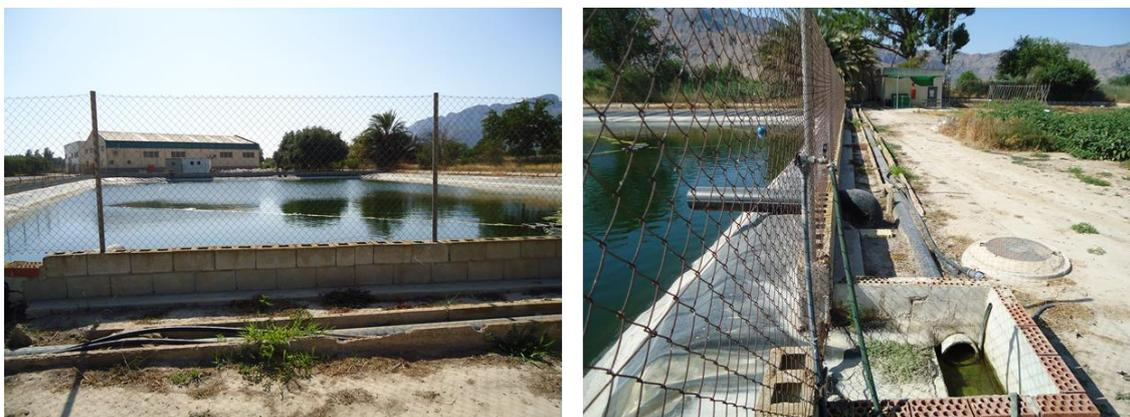
Figura 6. Izquierda: balsa de riego de la EPSO. Derecha: órgano de entrada de agua de la balsa.
