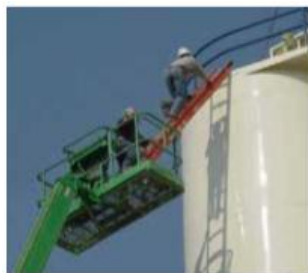
FIG. 14: Instalación inadecuada de una escalera sobre una plataforma.
