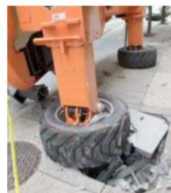
FIG.15: Colocación inadecuada de un estabilizado.
