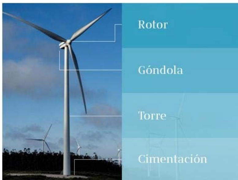
Imagen 6 Partes de las que consta un aerogenerador (fuente: <https://tecnoblogsanmartin.wordpress.com>)
