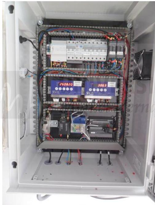
Figura 39. Cuadro eléctrico tras la revisión de las conexiones. Fecha: 5 de julio de 2017.
