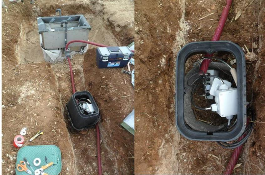
Figura 32. Conexiones de las células de carga y las electroválvulas en la arqueta para su prolongación hasta el cuadro de maniobra.
