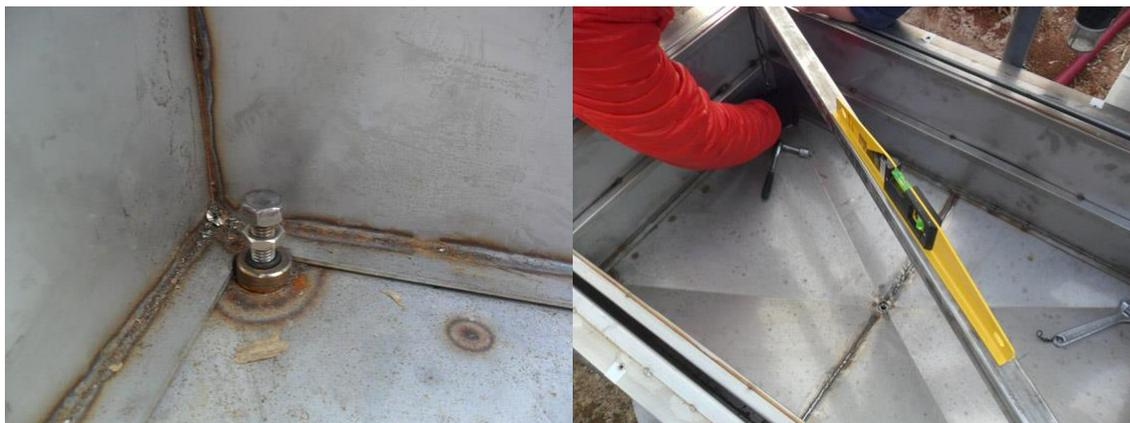
Figura 26. Nivelación y calibración del recipiente de cultivo mediante los tornillos de las esquinas.
