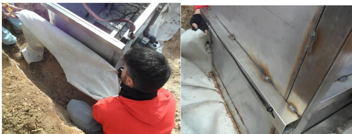
Figura 19. Colocación de la lámina geotextil.
