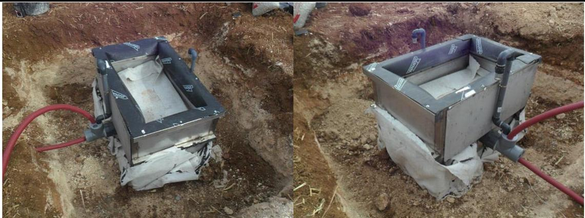
Figura 28. Geotextil en el fondo del recipiente de cultivo y lámina asfáltica perimetral doblada en L en la parte superior.
