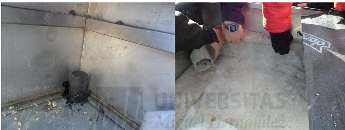
Figura 27. Colocación de los tapones y la lámina geotextil.
