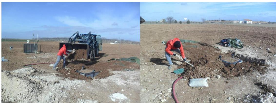
Figura 35. Relleno de la excavación exterior con ayuda de una retroexcavadora.
