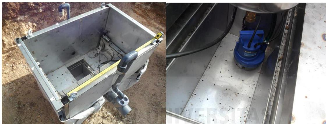
Figura 22. Colocación de la estructura interior de apoyo y de la bomba de succión sumergible.
