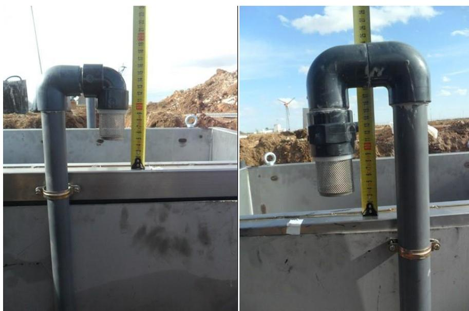
Figura 21. Sistema de ventilación del equipo de lisimetría.
