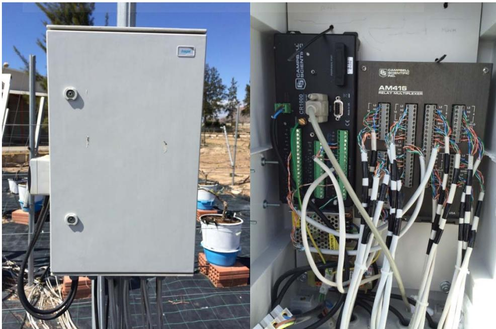
Figura 2-14 – Cuadro eléctrico y conexionado interior.
