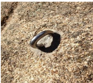
Anclaje químico en pared ( Resistencia de 25-50 KN)
