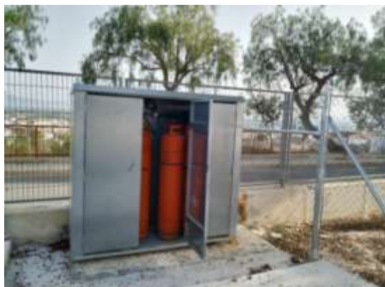
IMAGEN 24: Acopio de botellas de propano.
