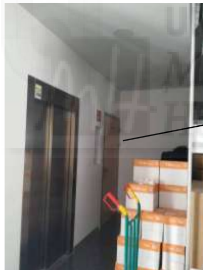
IMAGEN 22: Cuarto sala de máquinas de ascensor.
