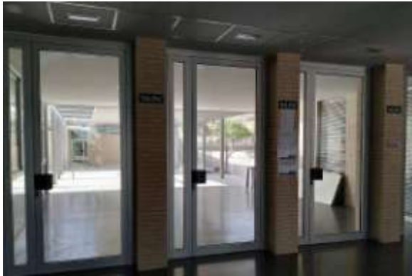
IMAGEN 77: Luces de emergencia
