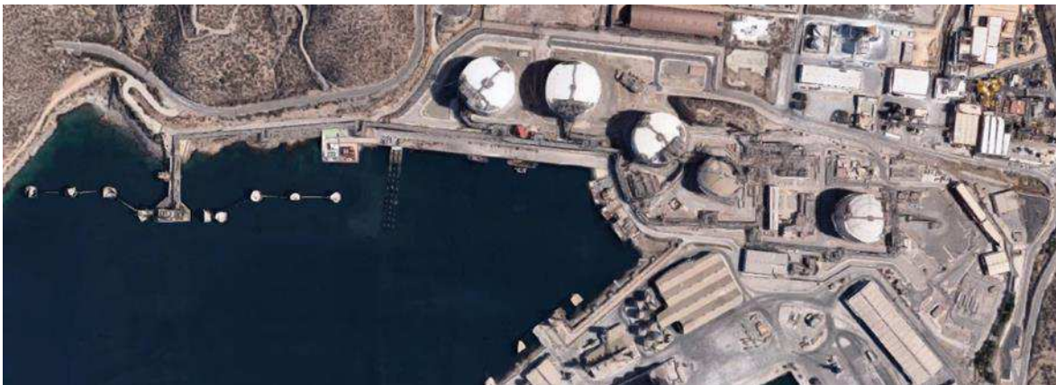
Ilustración 6. Foto aérea de la Planta Regasificadora.
