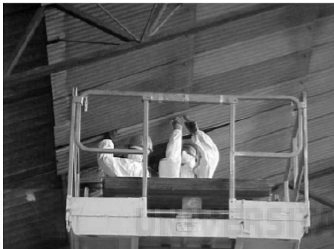
Imagen 21. Desmontaje de placas de fibrocemento desde plataforma elevadora tipo tijera
