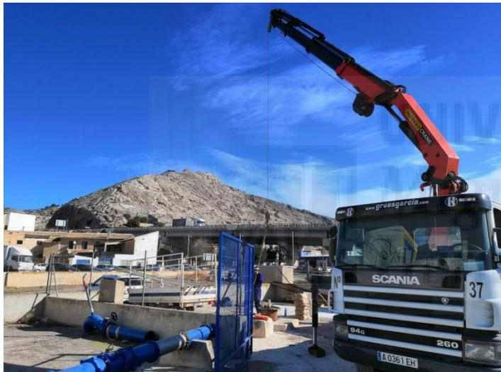
Foto. Montando tubería PVC con grúa
