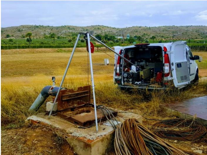
Foto. Equipo de testificación en sondeo.
