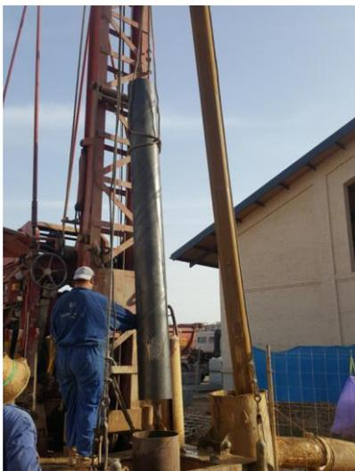
Foto. Entubación con braga metálica.
