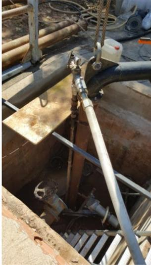
Bombeos y sobrebombeos: En este caso se realiza con la inyección de aire por compresores por un tubo auxiliar y extrayendo agua del sondeo por el efecto venturi
