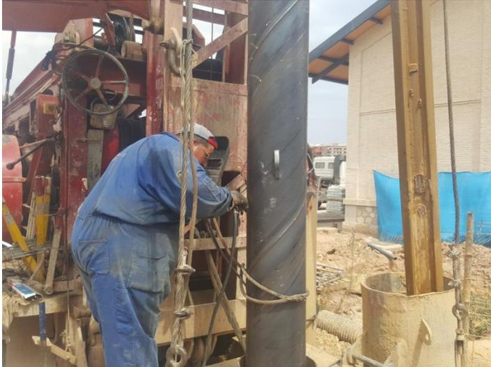
Foto. Entubación con braga metálica.
