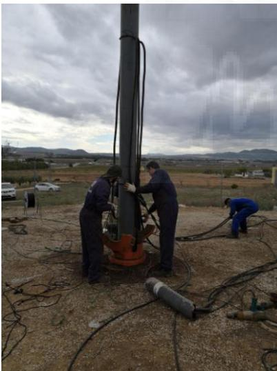
Foto. Instalado cableado para grupo de bombeo.
