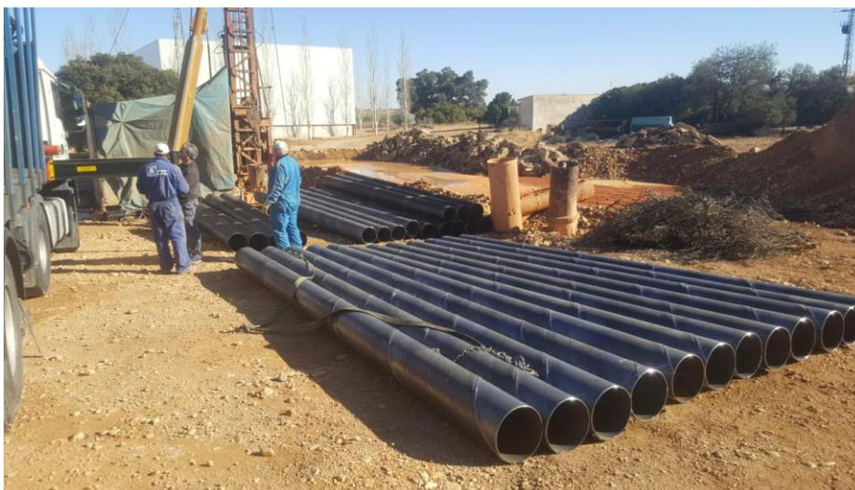
Foto. Entubación con máquina de percusión.
