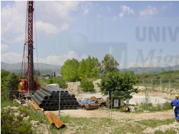
Foto. Máquina de percusión con acopio de tubería.
