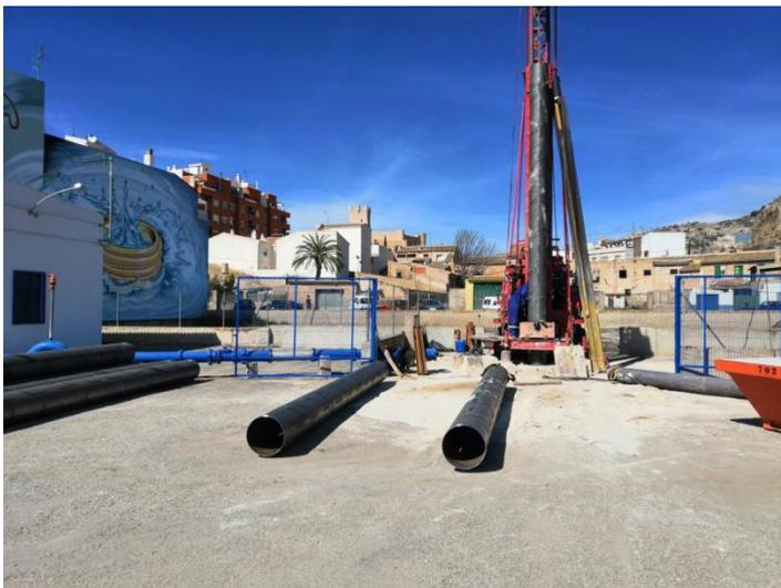
Foto. Entubación con máquina de percusión.
