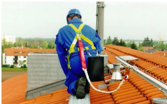
Imagen 20. Dispositivo de anclaje clase D.
