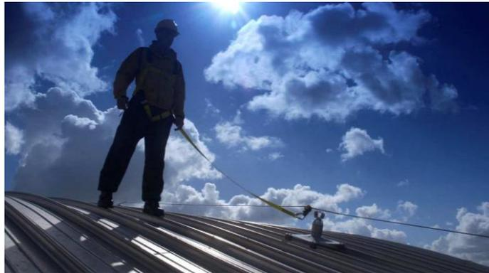
Imagen 20. Dispositivo de anclaje clase C.
