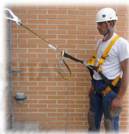
Ilustración 23: Trabajador anclado mediante gancho
