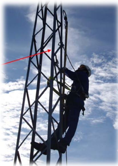
Ilustración 24: Detalle de los ganchos por encima del trabajador mientras asciende la torre
