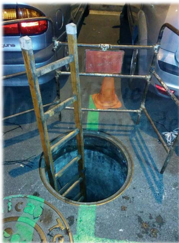
Ilustración 26: Cámara de registro Telefónica
