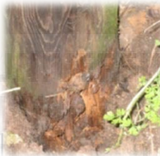
Ilustración 11: Ejemplo de poste en mal estado por la base
