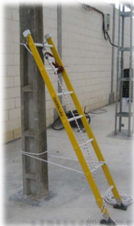
Ilustración 20: Escalera en poste de hormigón correctamente montada, vista lateral
