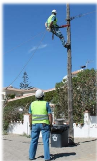
Ilustración 5: Trabajos en poste de madera
