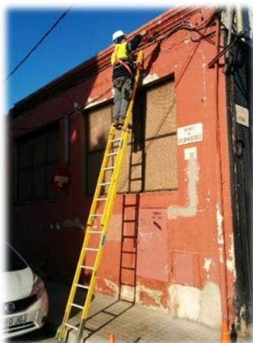
Ilustración 3: Trabajo con escalera en fachada
