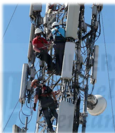
Ilustración 4: Trabajos en torre de telefonía
