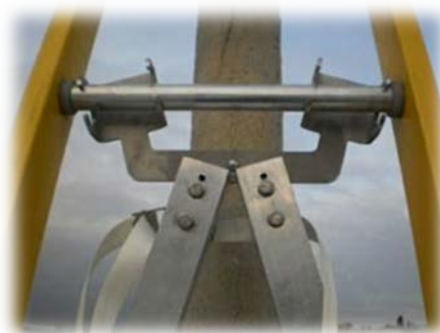
Ilustración 15: Detalle del sistema de anclaje de las patas centrales
