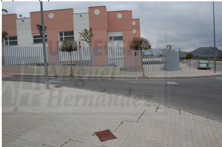
Esquina Carrer Serra dels Castellaret con Avda. Catedrático José M. Bernabé Mae (Se puede observar la trapa del hidrante en la acera)
