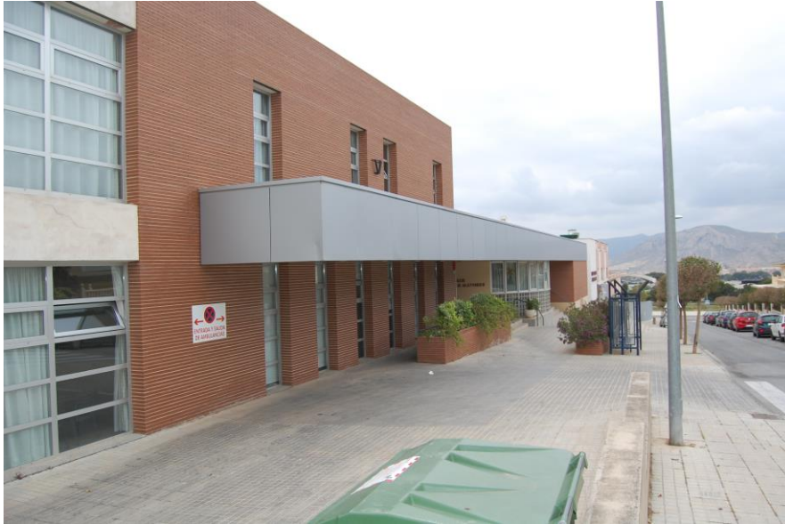
Fachada acceso principal Carrer Serra dels Castellaret (Acceso para vehículos de Bomberos)
