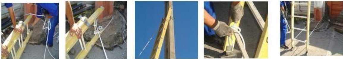
Ilustración 1. Técnica de amarre de escalera manual a apoyo.
