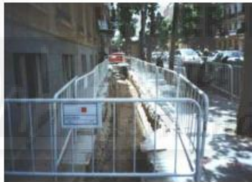
Ilustración 4. Señalización de las zanjas de tendido de cable subterráneo.
