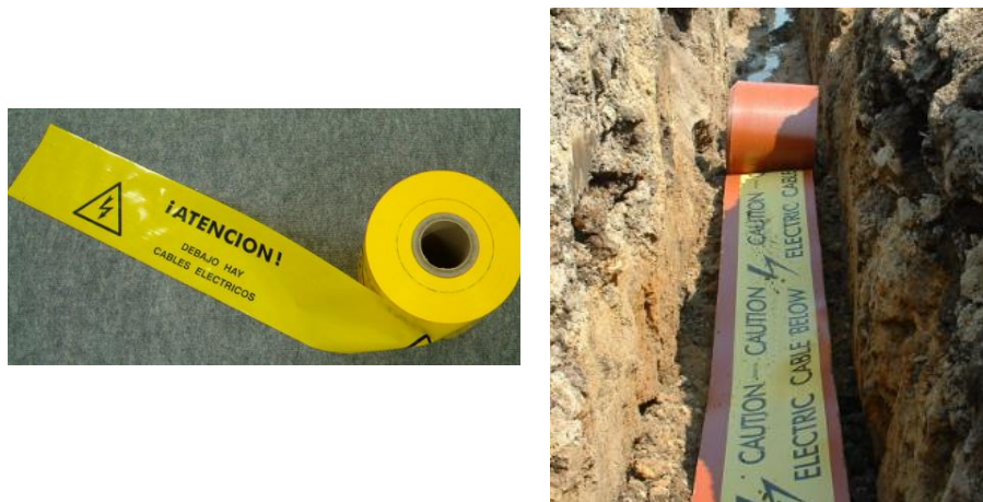
Ilustración 5. Descripción y posicionamiento de la cinta de señalización.
