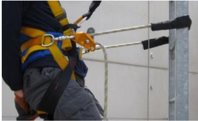
Ilustración 19. Arnés más conexión fast. Método de ascenso a apoyo. Figura de referencia.
