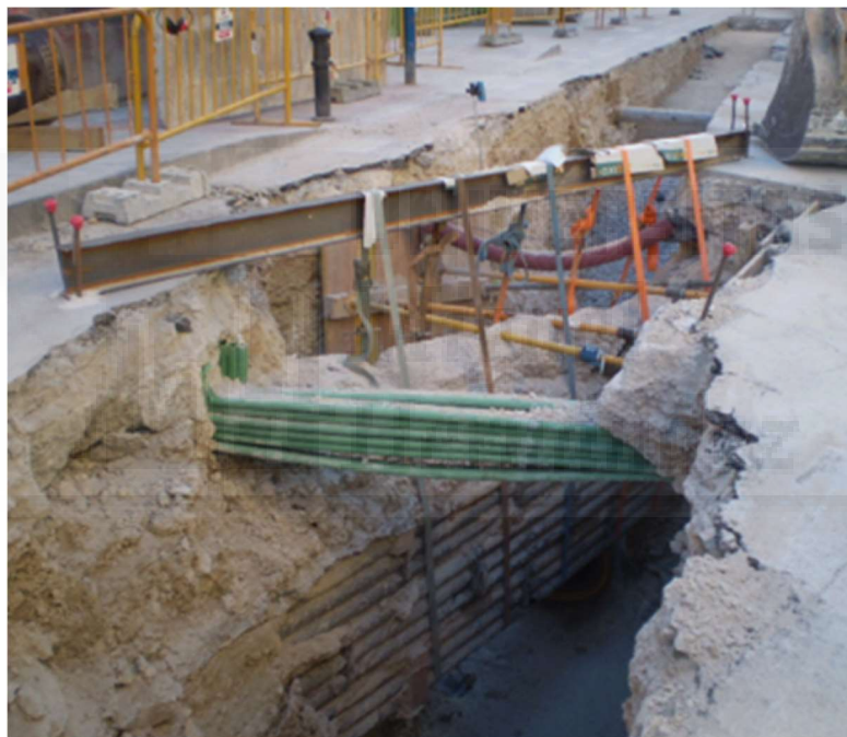
Zanja con diferentes servicios que cruzan con diferentes direcciones y profundidades, lo que dificultan la colocación de protecciones, así como el acceso de los operarios
