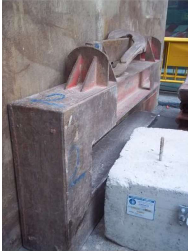
Útil de elevación (Pinzas) con su marcado CE
