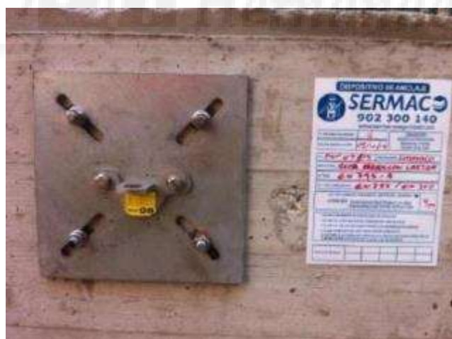
Punto de anclaje certificado sobre peso muerto de hormigón
