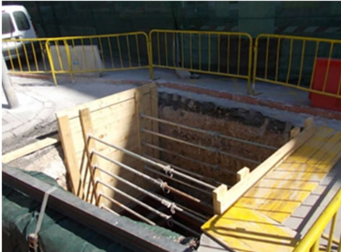
Zanja protegida con entibación cuajada de madera, en zona donde no entra la entibación de módulos estandarizada.
