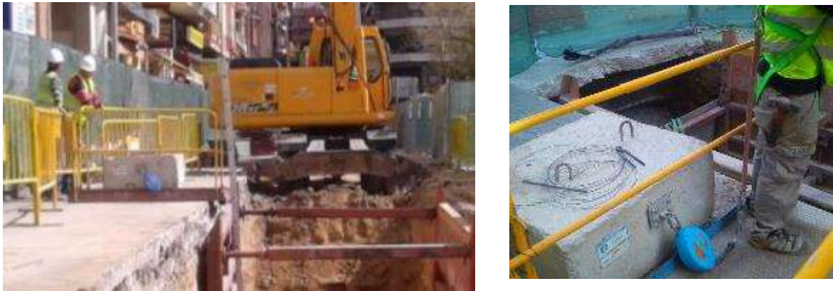
Peso muerto de hormigón situado en obra
