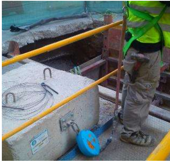
Foto n°2: Retráctil enganchado a punto de anclaje instalado en dado de hormigón.
