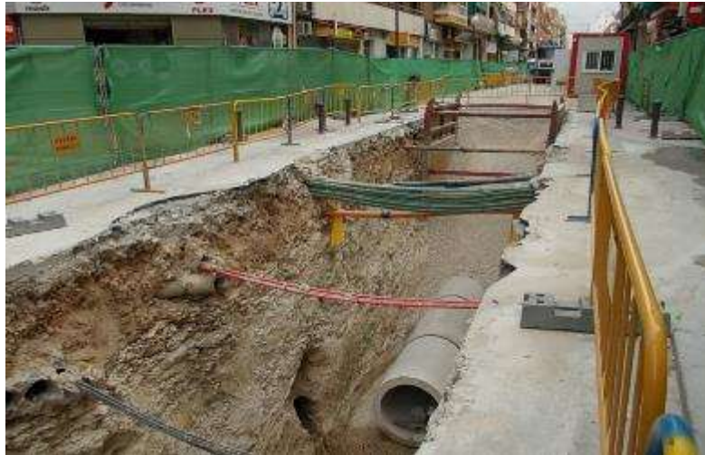
Zanja con diferentes servicios que cruzan la zanja en perpendicular
