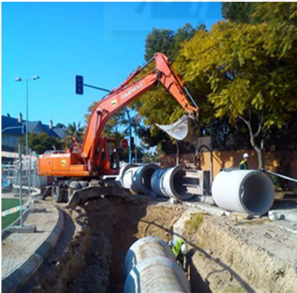
Excavación de la zanja mediante ejecución de bermas
