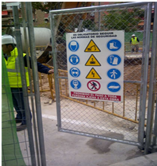
Carteles de señalización en el acceso a la obra
