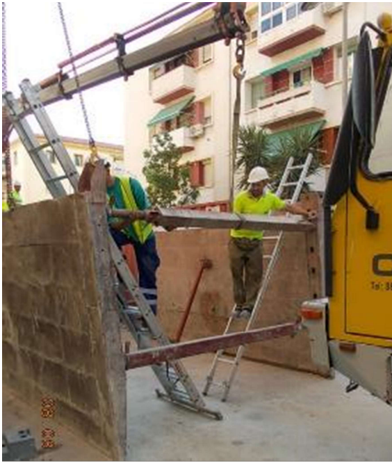
Montaje de módulos de entibación blindada
