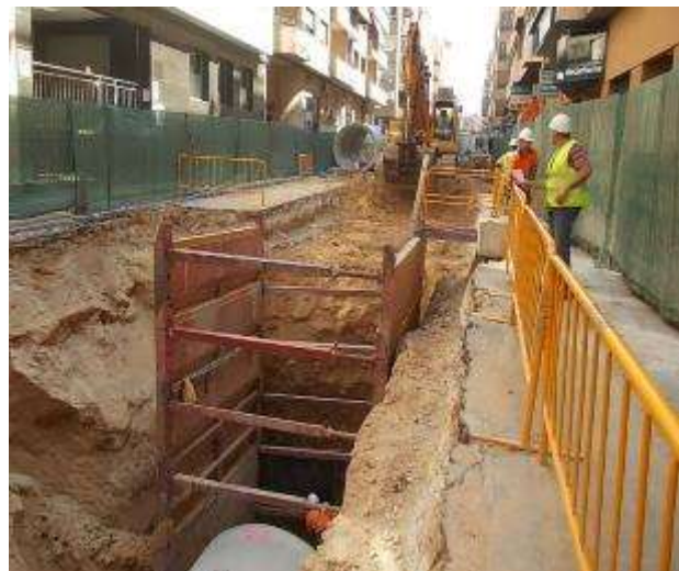
Operarios trabajando en zona segura
