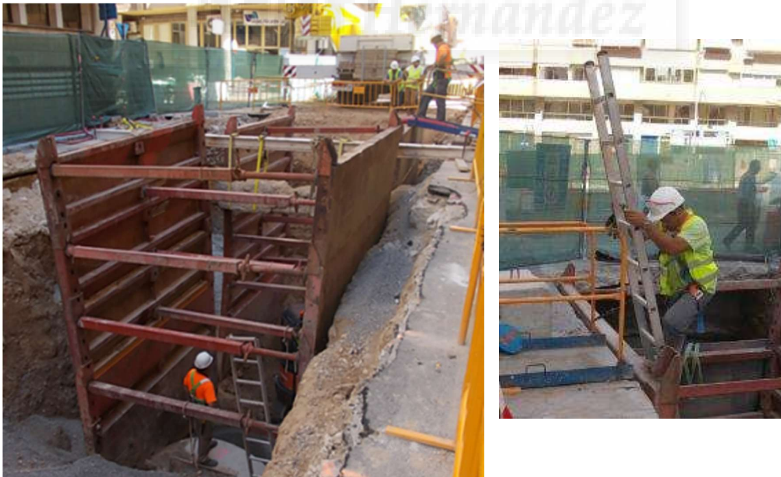
Empleo de pasarelas para acceso al fondo de la excavación
