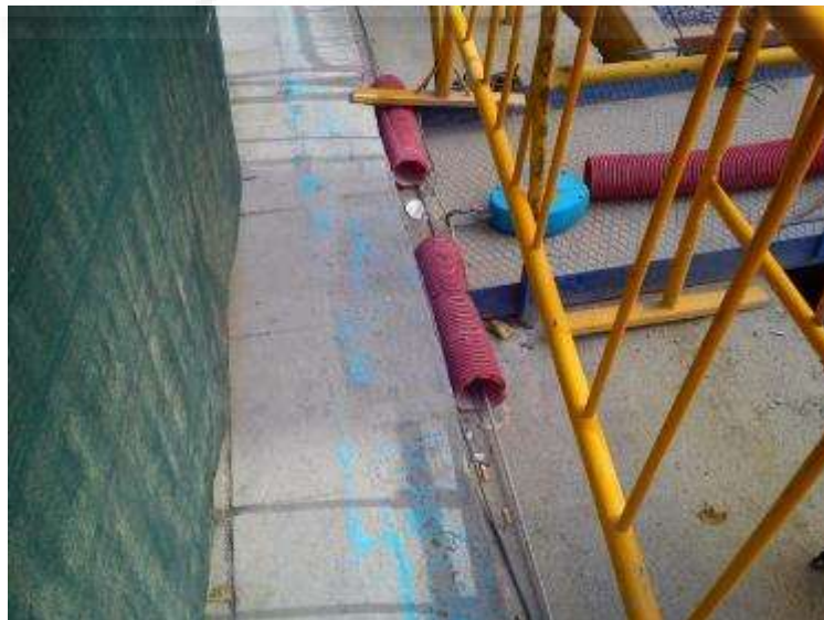
Foto n°3: Línea de vida instalada
