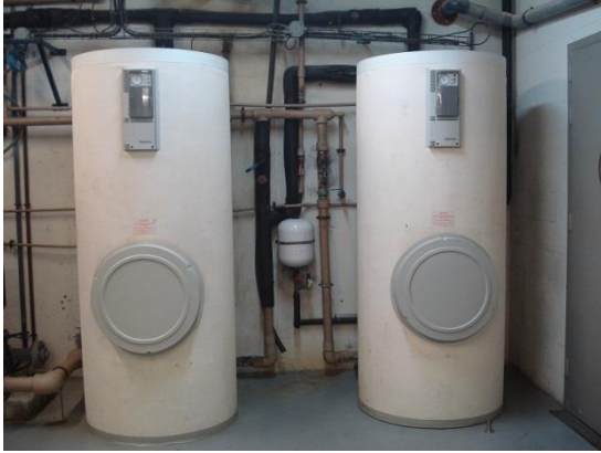
Boca de hombre depósitos ACS (c)
