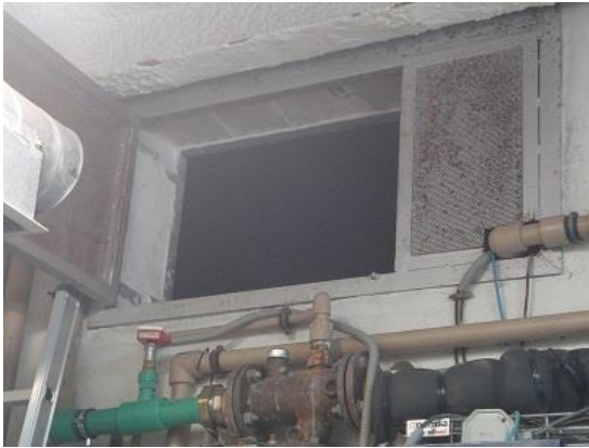
Acceso aljibe AFS (f)
