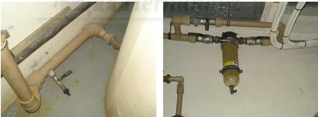
Llave de purga de uno de los depósitos de ACS (a) Filtro de Entrada en acometida (b)
