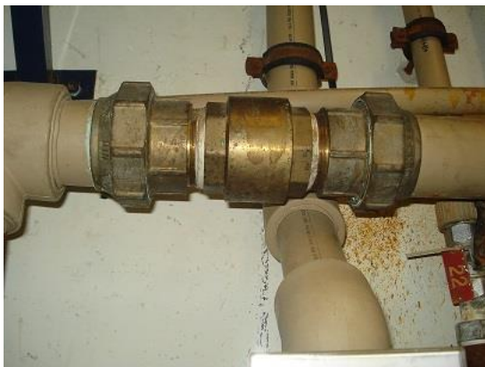
Válvula antiretorno entre circuito de AFS y ACS (h)
