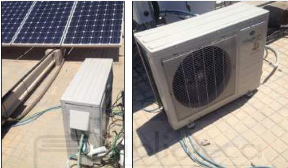
*Figura 2-6 Unidad exterior en cubierta junto a la instalación FV*
