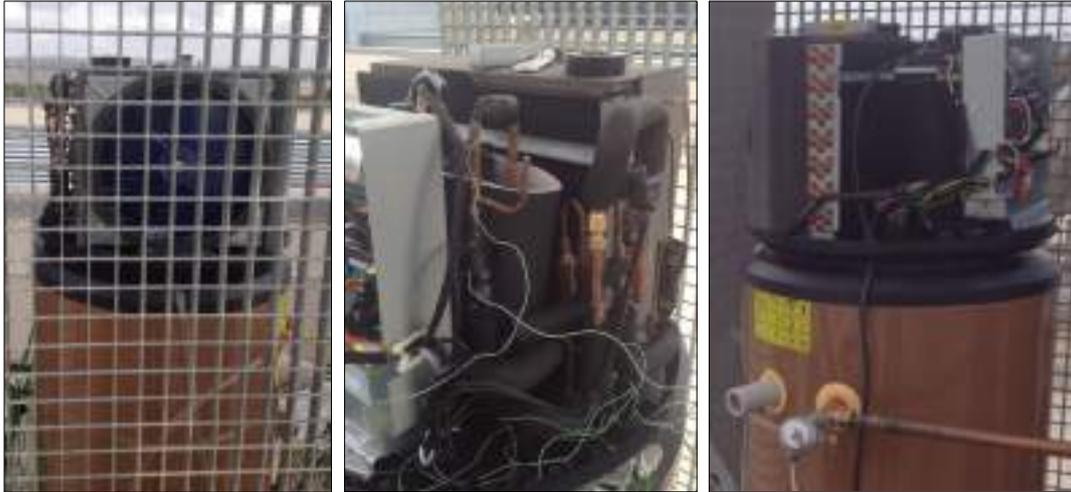
*Figura 5-3 Evaporador de la bomba de calor Compak KHP 15 190*
