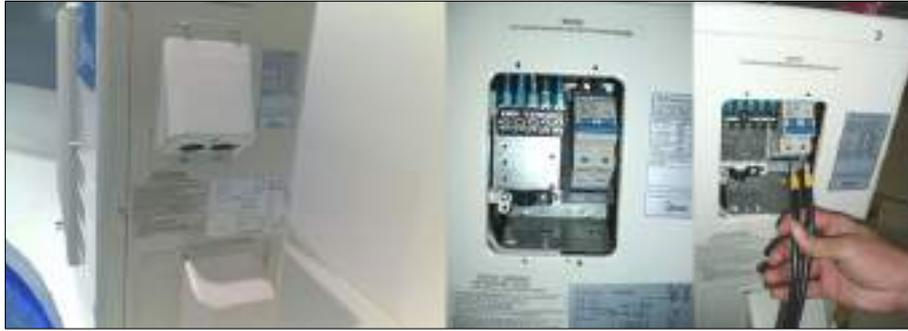
*Figura 2-4 Conexión eléctrica unidad exterior A/C*
