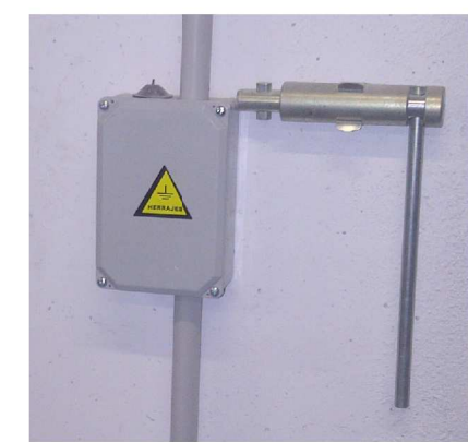
2 y 3 Detalle de cajas de conexión a tierra
