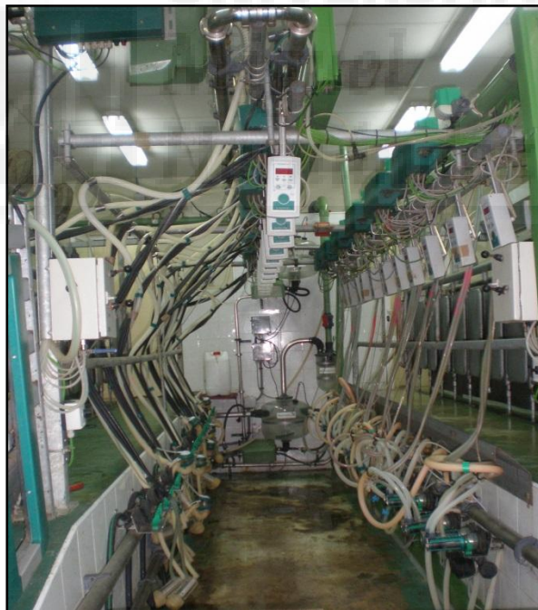
Figura 3. Sala de ordeño de la granja EPSO-UMH. Equipo instalado en línea baja (1X12x12) a la derecha y equipo instalado en línea alta (2x12x12) a la izquierda.
