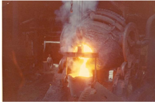
Figura 9. Horno Bessemer de la fundición de cobre de las minas de Río Tinto (fotografía original de J.Ma. Rincón, de 1966)
