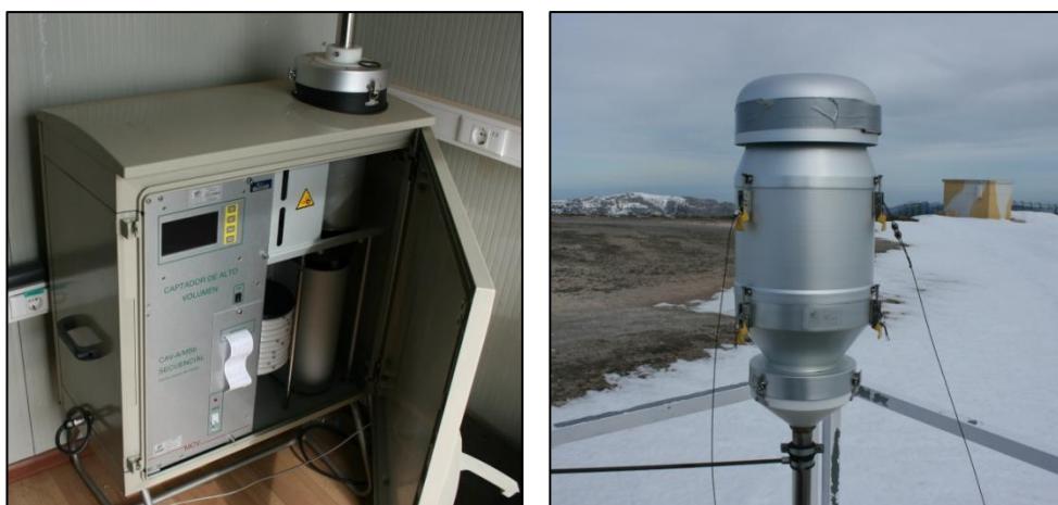
Figuras 14 y 15. Captador de alto volumen MCV CAV-A/MSb y cabezal \text{PM}_{10} , en la estación de Aitana.
