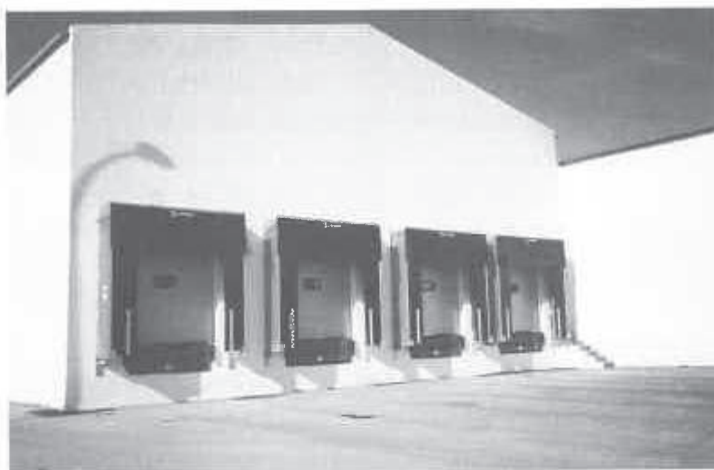
Foto. 15. Puertas de guillotina en abrigos de muelles de carga. Las plataformas de los muelles son de altura regulable.
