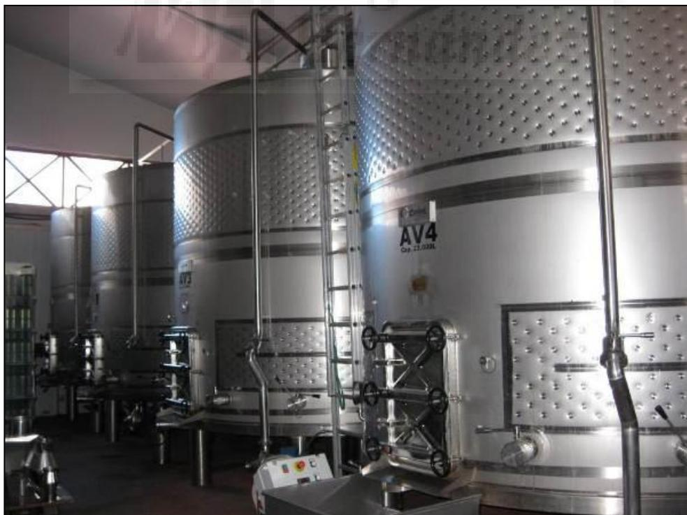
Figura 1.19. Depósitos de acero inoxidable de descube manual en interior de bodega
