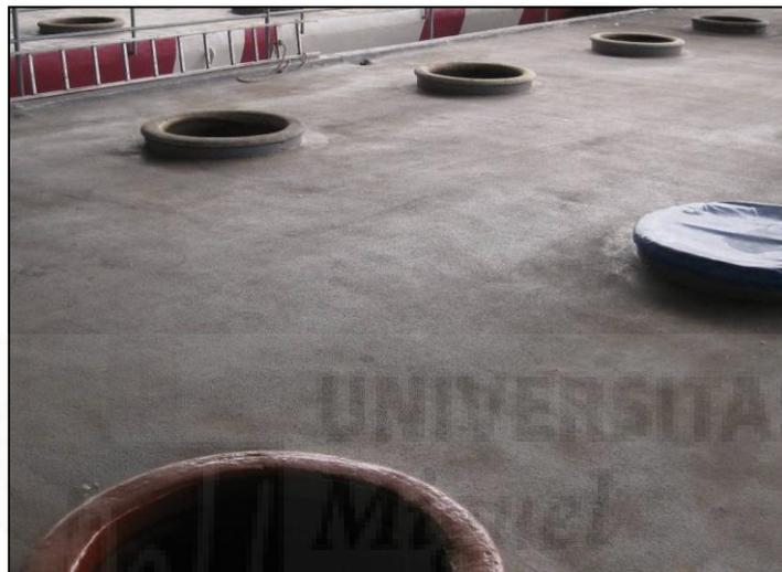
Figura 1.17. Vista de varios depósitos de hormigón bajo rasante (subterráneos) adosados
