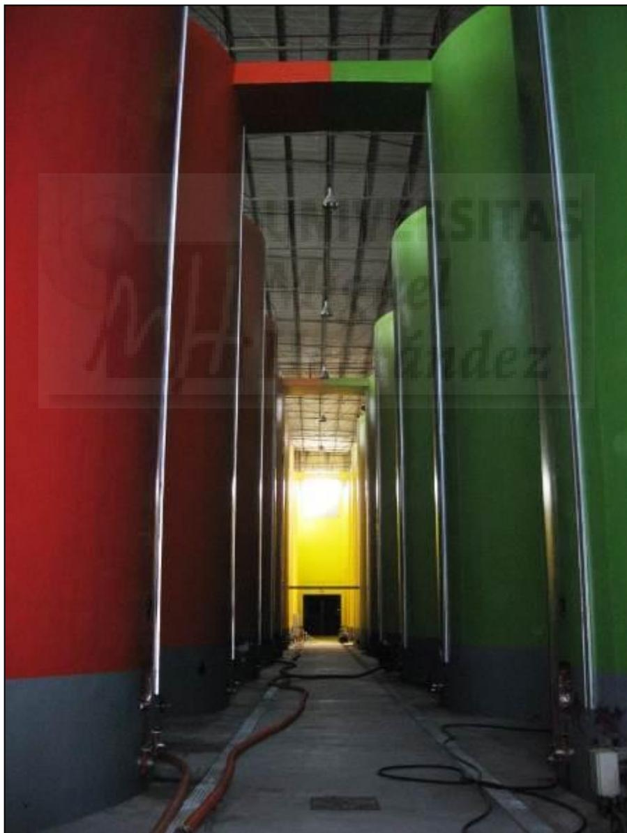
**Figura 1.16. Depósitos de hormigón sobre rasante (con pintura exterior)**
