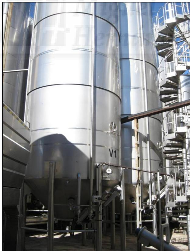
**Figura 1.20. Depósitos de acero inoxidable autovaciantes de descube controlado, ubicados al exterior**
