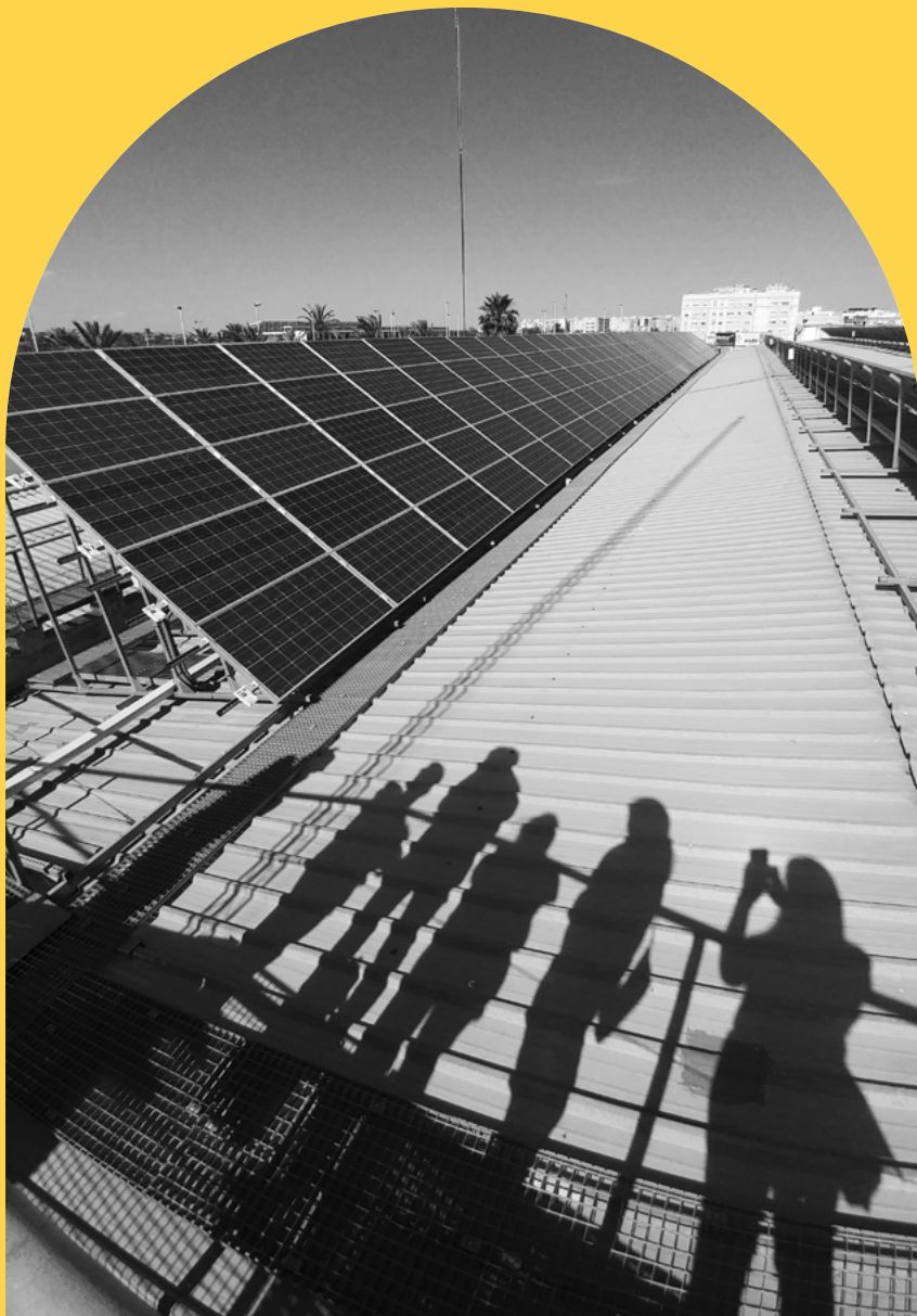
Imágenes cedidas por el Máster de Instalaciones Térmicas y Eléctricas de la UMH
