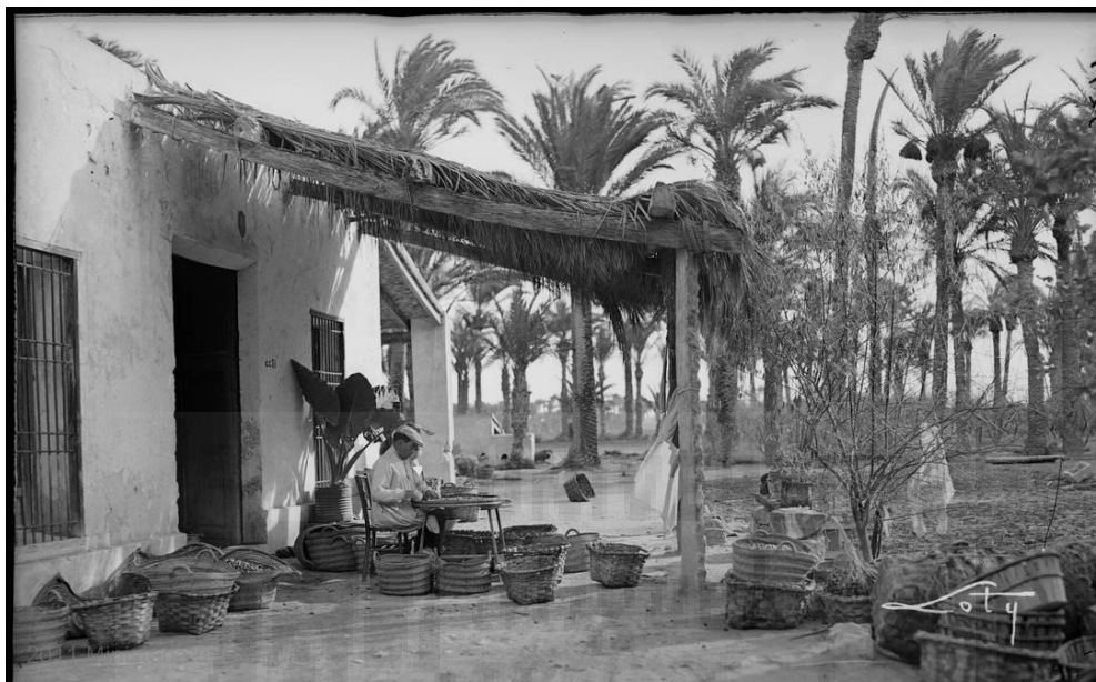
Figura nº 25. Troncos de palmera haciendo las funciones de vigas y pilares.
