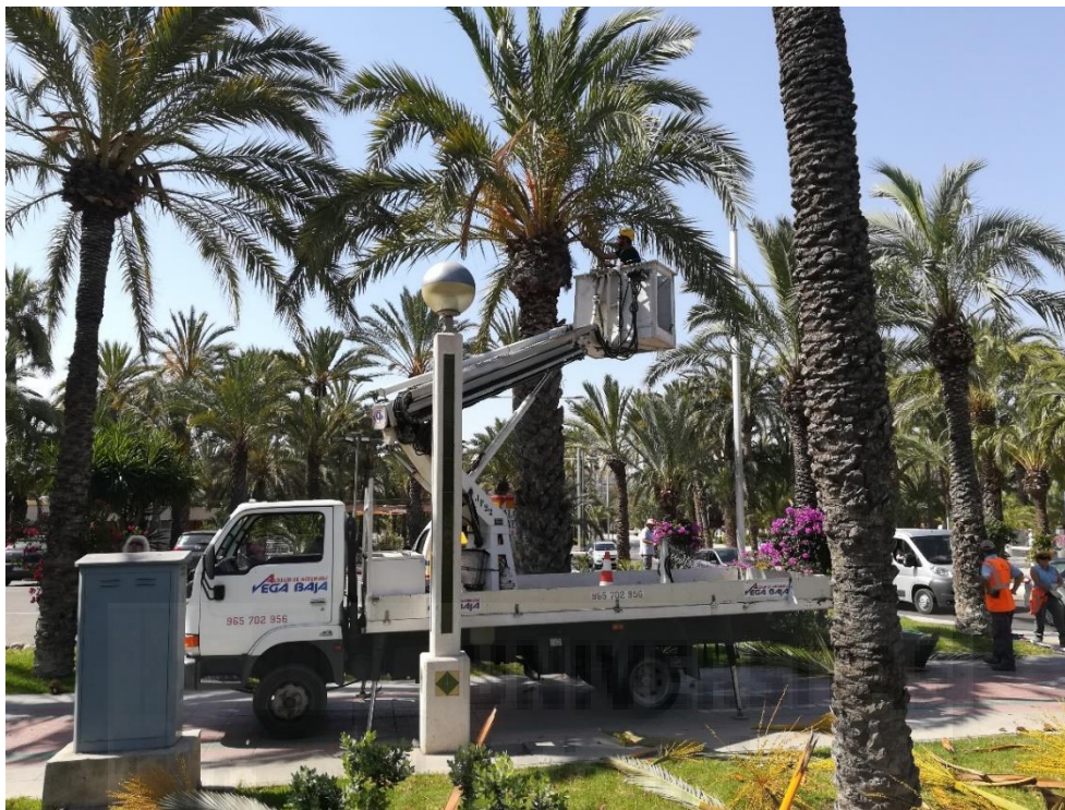
Figura nº 17. Operarios del ayuntamiento retirando restos de palmeras cortadas.
