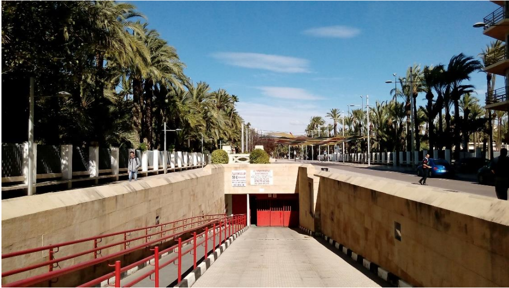
Figura nº 110. Parking subterráneo en el Paseo de la Estación. Fuente propia.
