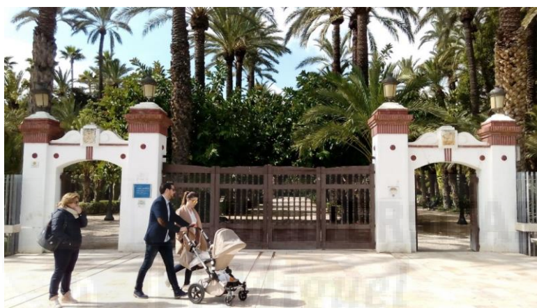
Figura nº 106. Puerta principal del Parque Municipal, 2016. Fuente propia.
