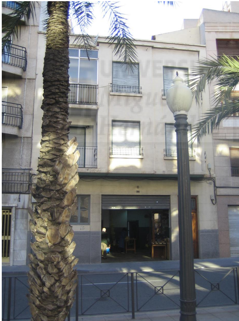
Figura nº 48. Edificio de la casa familiar. En la planta baja está ubicado el taller de artesanía de la palma blanca. Fuente propia.
