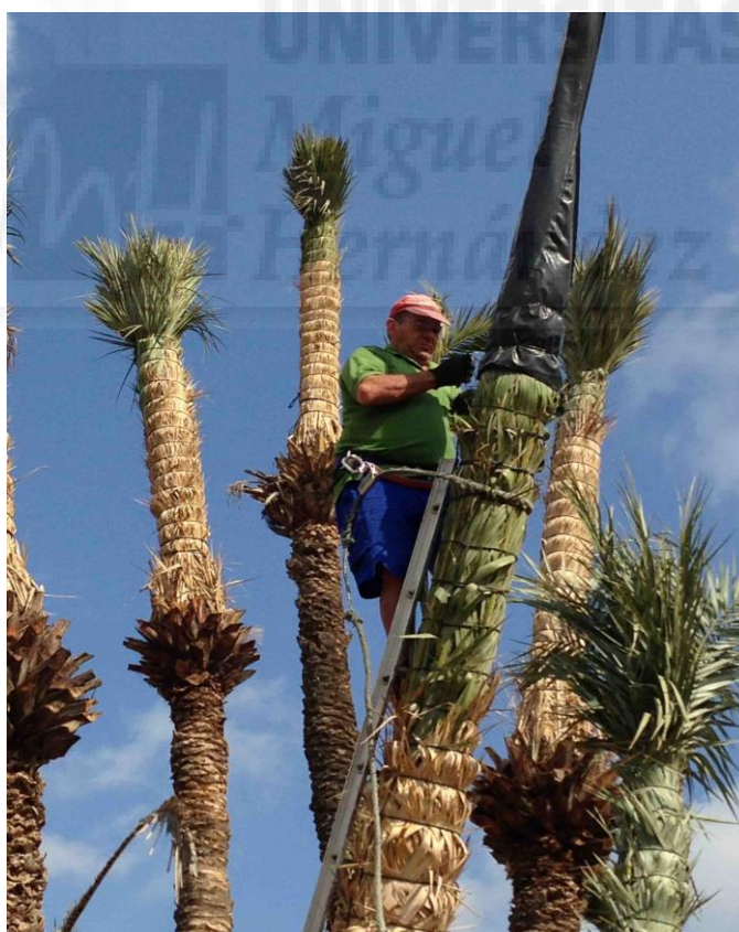
Figura nº 169. Encaperuzado (del cinturón del palmerero pende la cuerda con la que suben elementos). Fuente:
