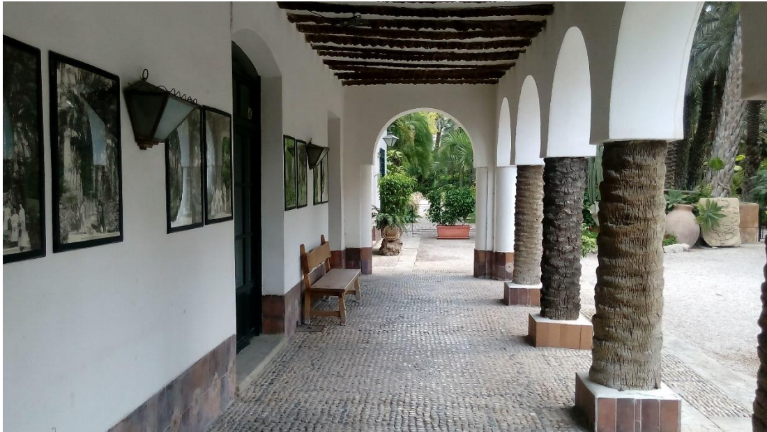
Figura nº 27. Casa del Huerto del Cura , con vigas y pilares hechos del tronco de la palmera. Fuente propia.
