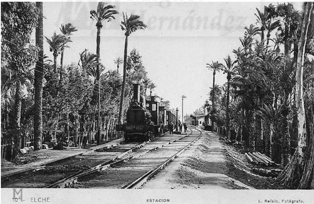
Figura nº 37. Trazado de la vía férrea partiendo en dos el Palmeral. Fuente: http://lamiradadeladama.foroes.org/t763-fotos-antiguas-de-elche-ferrocarril
