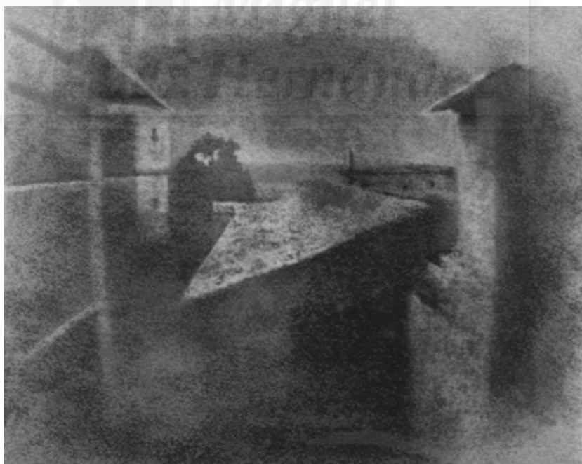
Figura 9 Gernsheim, Helmut y Laboratorio de Investigación Kodak (1952) Versión editada de la de la heliografía de Niépce, J. N. (1826 o 1827) Vista desde la ventana en Le Gras [Fotografía].
