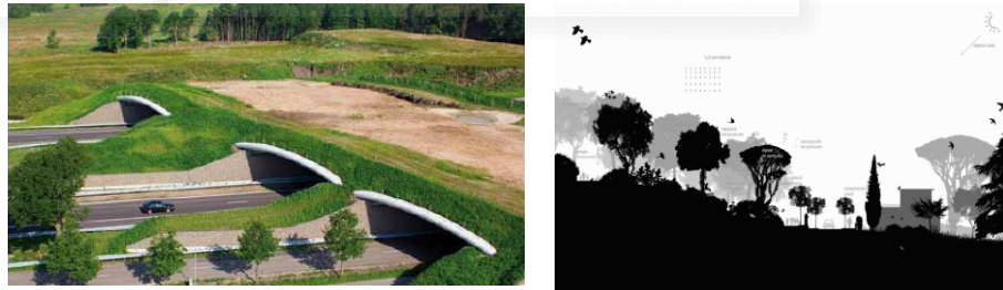
Ilustración 86: Izquierda actuación ecológica sobre vial de gran tránsito tipo autovía. Derecha sección del corredor del parque Güell de Barcelona. Fuente: Foro S.U.M.A. S.XXI., Alicante 2010.
