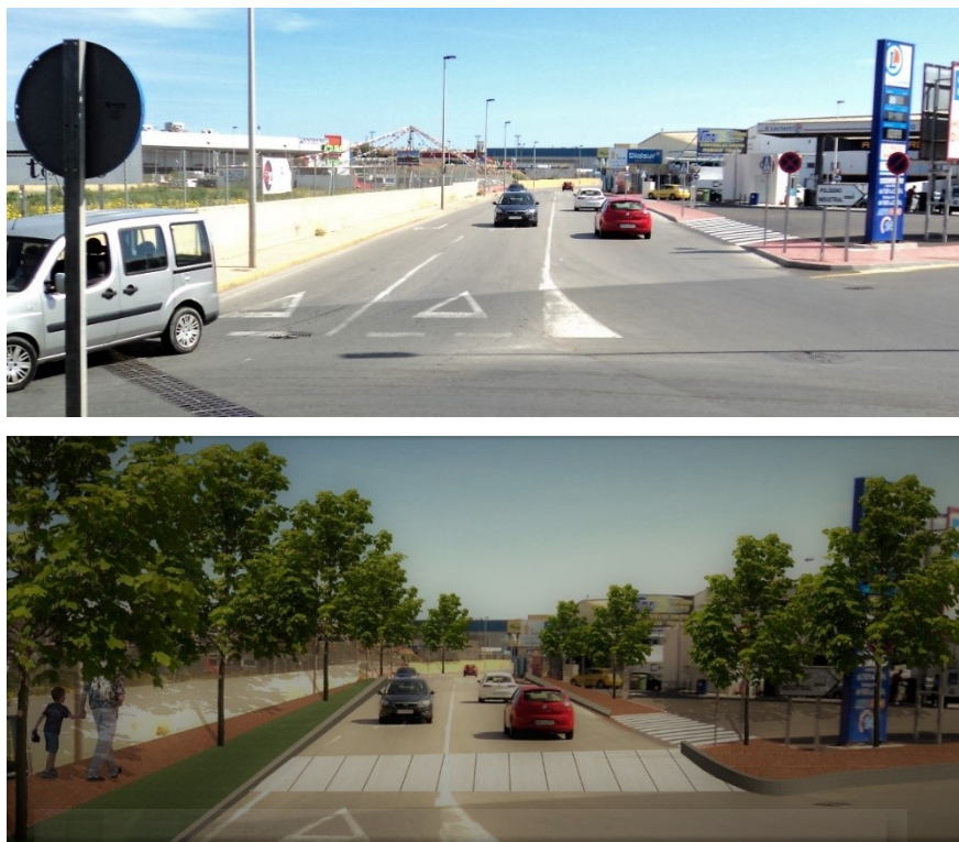
Ilustración 98: Antes y después de la propuesta de actuación en Polígono industrial Casa Grande, en el vial Roza Mazón. Se introduce arbolado, aceras peatonales y carril bici. Fuente: Elaboración propia.
