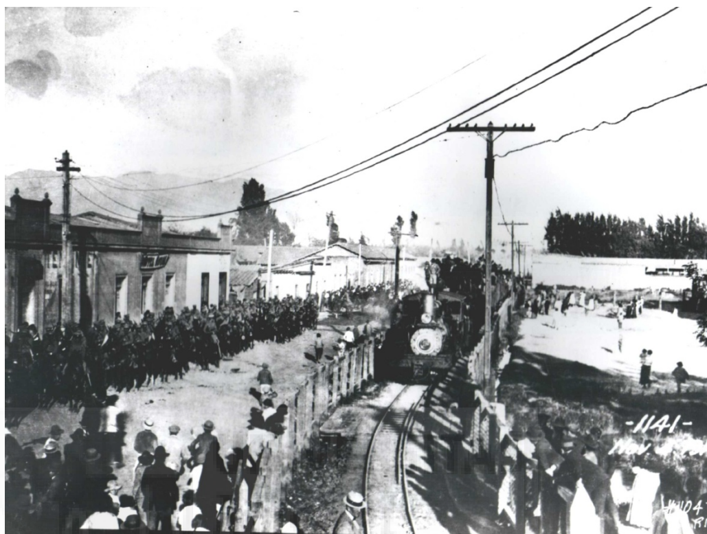
Fotografía 8. Llegada del ferrocarril a Rancagua
