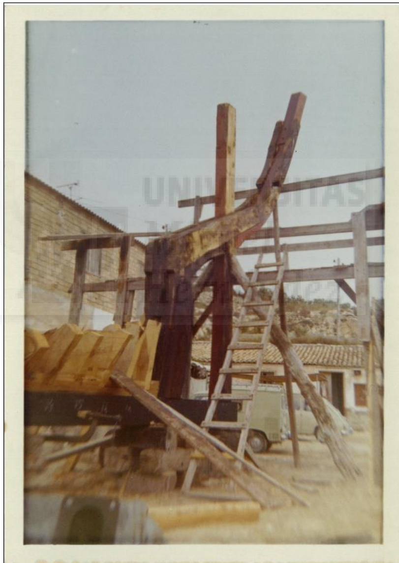
Imatge nº 73.- Peces: roda de popa i codastre. Font: Arxiu Drassana Zaragoza.
