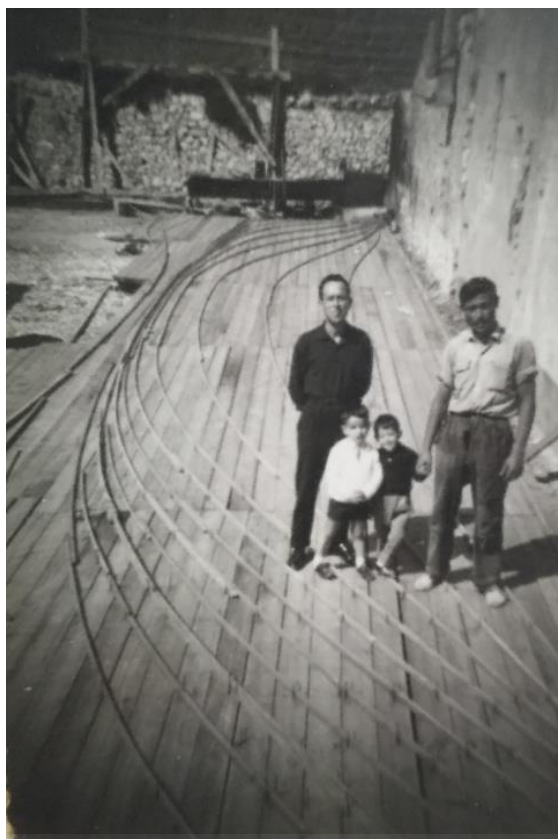
Imatge nº 59.- Plànol del traç de les vagres del Cabo San Antonio. Font: Arxiu Drassana Zaragoza.
