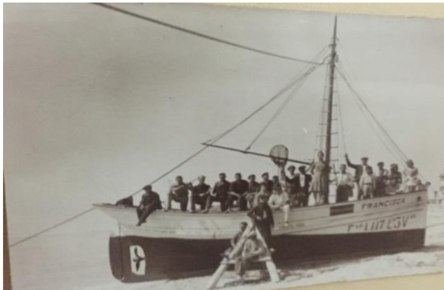
Imatge nº 100.- Varada amb "patarassos". Font: Arxiu drassana Zaragoza.
