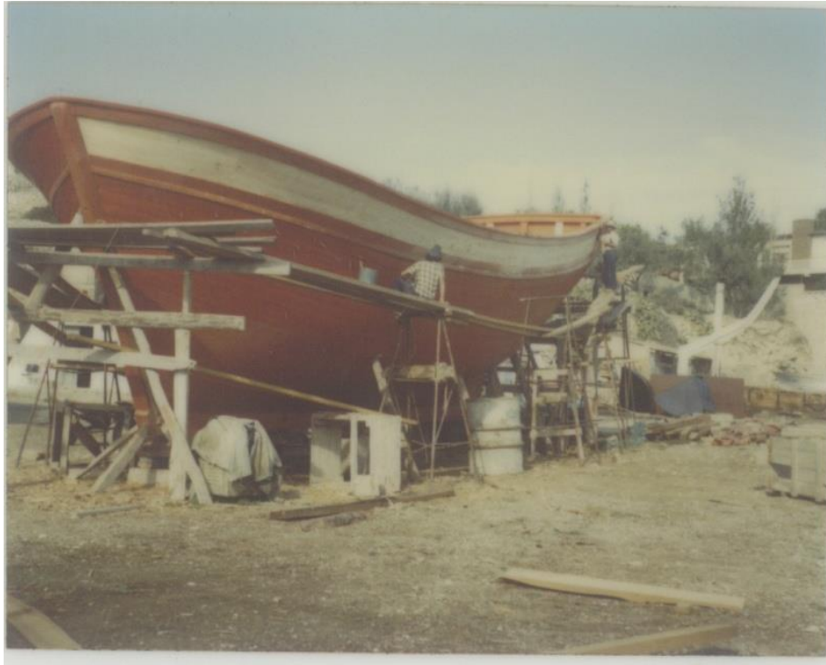
Imatge nº 87.- Tractament de la fusta. Font: Arxiu Drassna Zaragoza.
