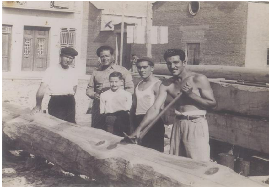
Imatge nº 25.- Els treballadors estan llevant la corfa dels troncs a la drassanes Atlàntida, a la platja de la Malva Rosa. Font: Baldó, 2017.
