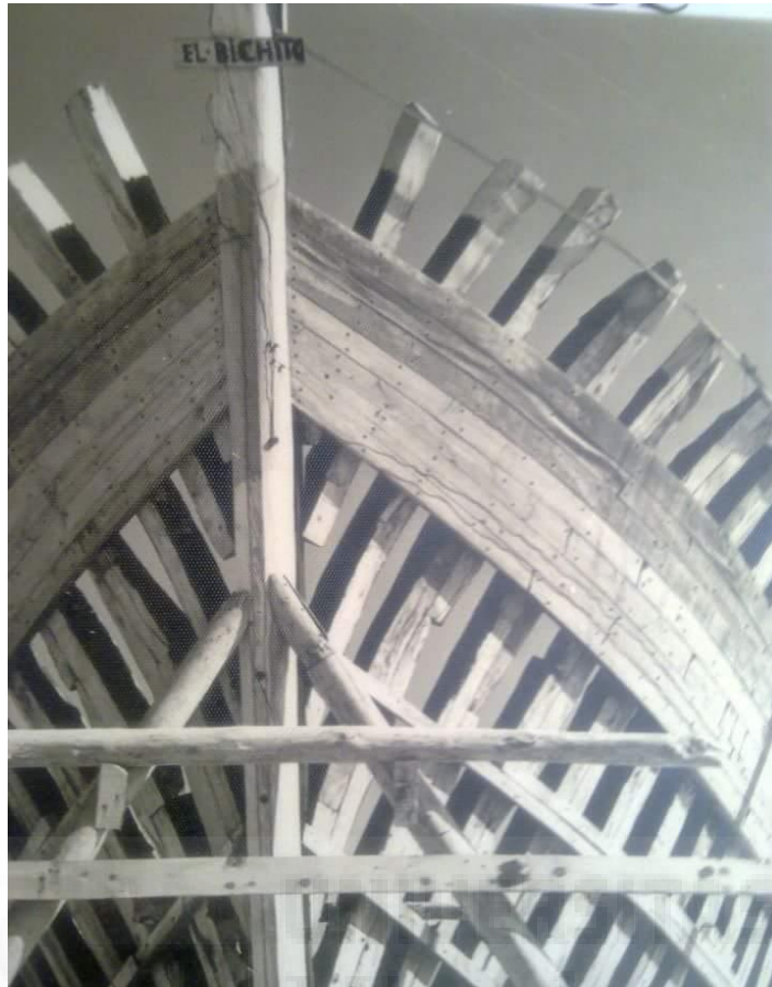
Imatge nº 83.- Posar la coberta. Font: Arxiu Drassana Zaragoza.
