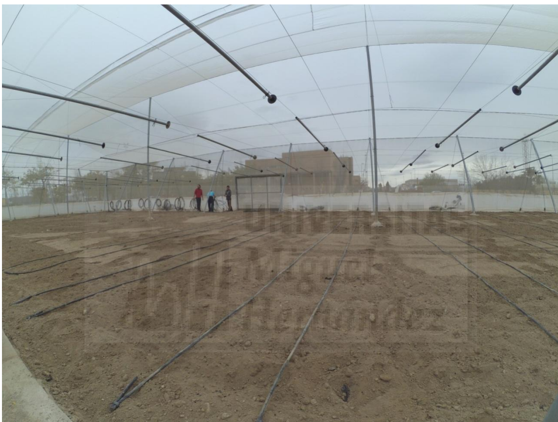
Figura 14. Detalle del terreno ya preparado previo a la instalación de acolchado
