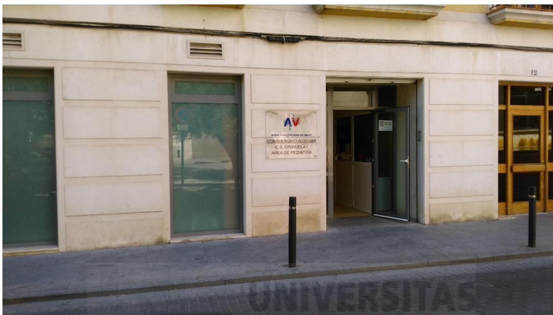
Acceso al Centro de Salud. En calle semi-peatonal sin aparcamiento y sin la puerta de 2 lamas recomendada
