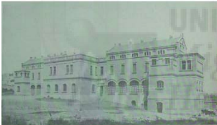
Fig. 1.—Façana posterior del Pavelló del Càncer de l'Hospital de la Santa Creu i Sant Pau. A la dreta, ala Roentgen i a l'esquerra, poc visible, ala Curie.
