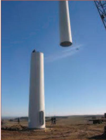
Figura 10. Izado y alineación de los tramos.
