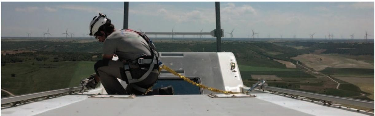
Figura 14. Trabajos en el exterior de la góndola.
