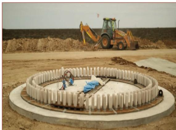
Figura 8. Estado final de la base del aerogenerador.
