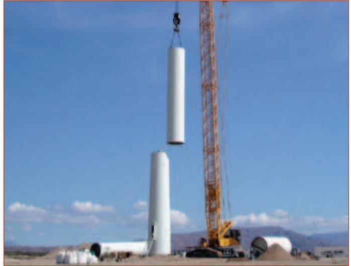
Figura 11. Izado y alineación de los tramos.
