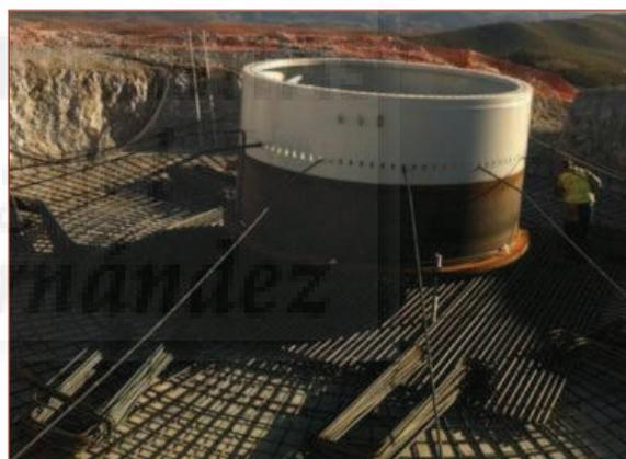
Figura 4. Inicio de los trabajos de ferrallado.
