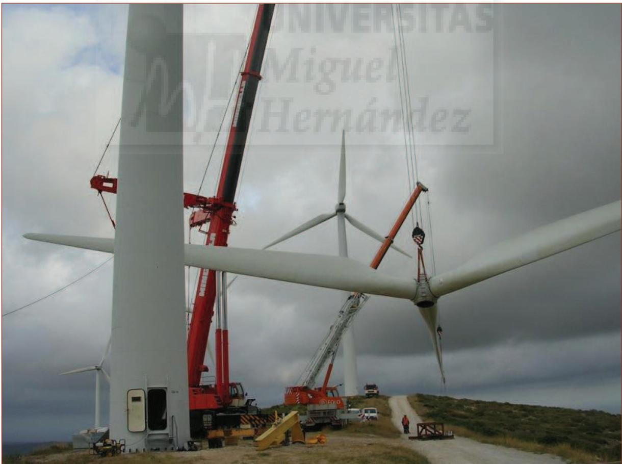
Figura 15. Trabajos para la colocación de las palas.
