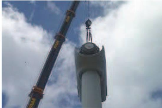
Figura 13. Izado y colocación de la góndola.
