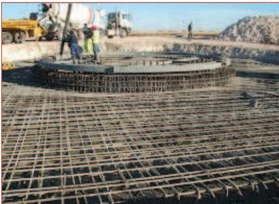
Figura 6. Proceso de hormigonado.
