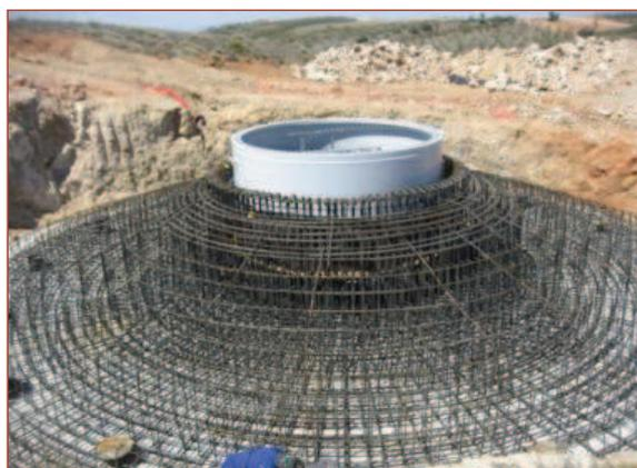
Figura 5. Base preparada para el hormigonado.
