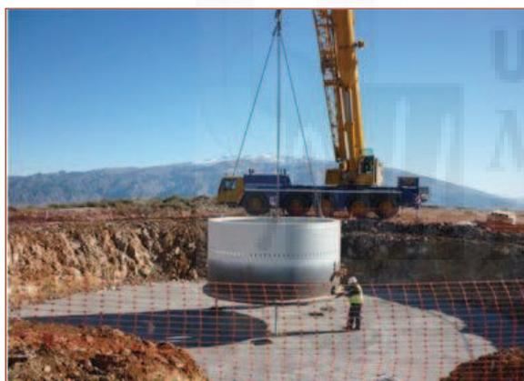
Figura 3. Izado y colocación de la base.
